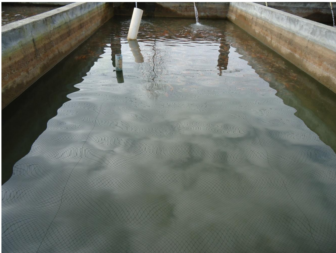
Figura 26. Tanque de hormigón utilizado para el almacenamiento de carpas con aglomeración de los ejemplares en la entrada puntual de agua.
