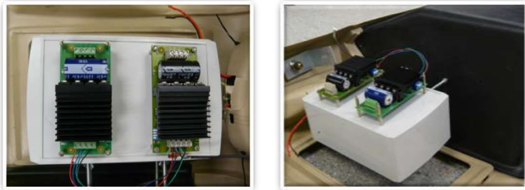
FIGURA 85: SUJECIÓN PLACAS DE POTENCIA A CAJA PRINCIPAL CONTROL
