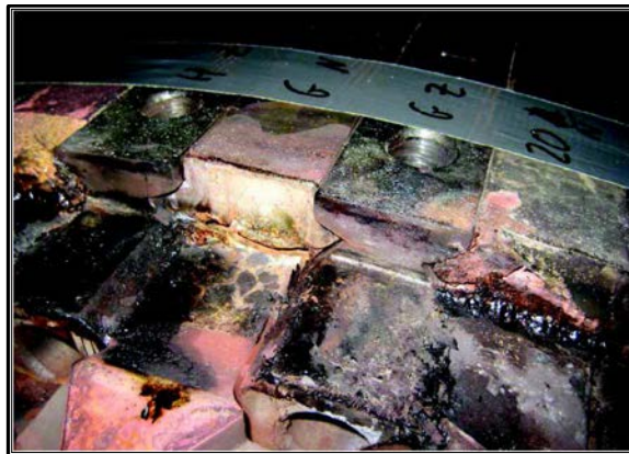
Fig. 4. Vista del área del rotor después de quitar el anillo de retención.
