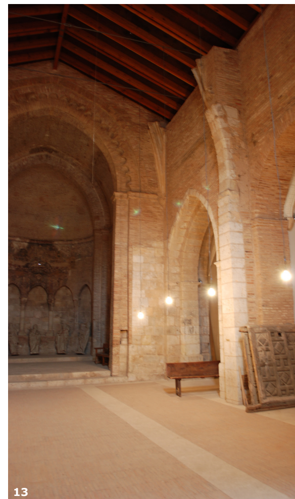
Fig. 13. Fotografía del interior de la nave. Los arranques de los nervios de las bóvedas originales dan testimonio de la estructura desaparecida.
