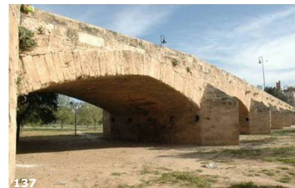
Fig. 137. Vista del puente de la Trinidad, aguas arriba. Se aprecian los arcos apuntados y los tajamares triangulares.
