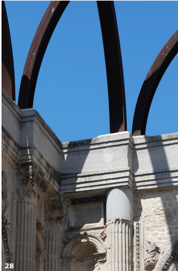
Fig. 28. Encuentro entre los diferentes materiales en el interior de la Capilla Mayor. El nuevo capitel de hormigón muestra su absoluta abstracción, mientras que el nuevo entablamento continúa el perfil del entablamento original.
