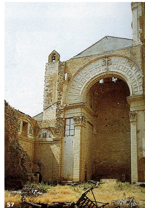
Fig. 57. Estado inicial del interior de la iglesia ( Arq. nº257, p.80 )
