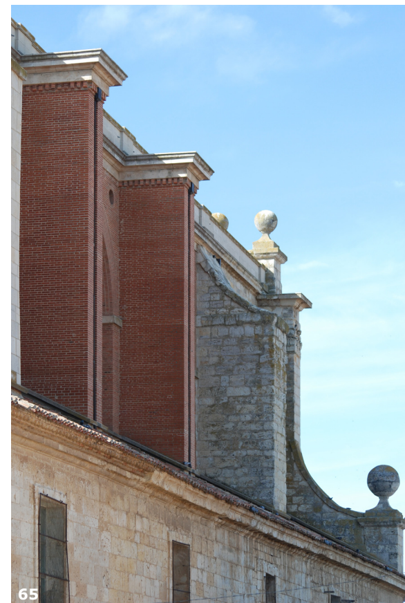
Fig. 64 y 65. Interior y Exterior. Relación entre lo nuevo y lo preexistente.
