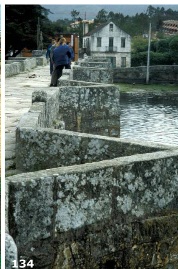
Fig. 134. Puente de Gondomar (Pontevedra). Arrimaderos sobre tajamares triangulares.
