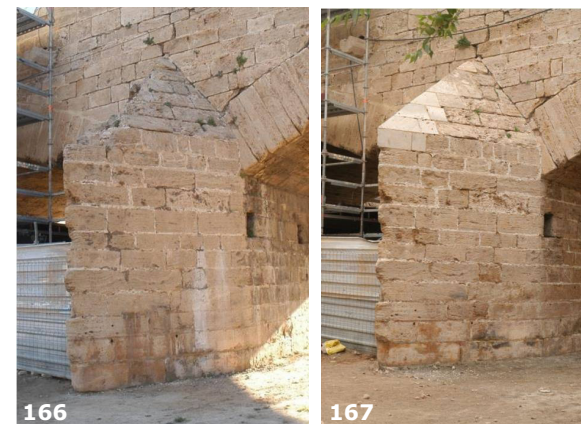
Fig. 166 y 167. Antes y después de las restituciones puntuales llevadas a cabo en los tajamares del puente de la Trinidad.
