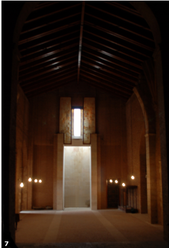
Fig. 7. Interior de la nave. Cubierta y muro hastial reconstruidos.
