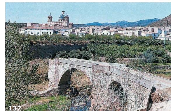
Fig. 132. Puente de Sot de Ferrer sobre el Palancia (Valencia). Posiblemente del siglo XVII. El tajamar se prolonga hasta el tablero creando arrimaderos.
