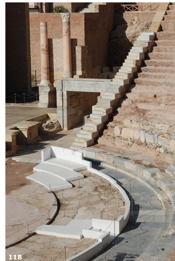
Fig. 118. Fotografía donde se observa la restitución de fragmentos de la orchestra, así como la restitución de otros elementos de la cávea y de la escena.
