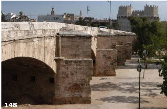
Fig. 148. Vista del puente de Serranos, aguas arriba.
