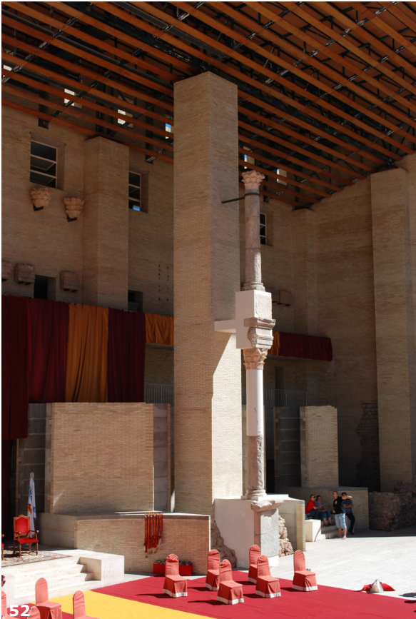
Fig. 50, 51 y 52. Vistas del teatro después de la intervención. Detalles de la cávea y la escena.
