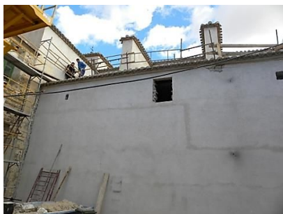
Figura 122: Acceso habilitado a bajo cubierta.
