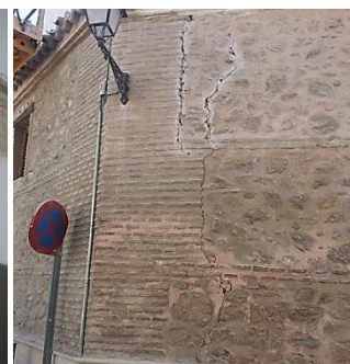
Figura 6: Ladrillo macizo en fachada sureste.
