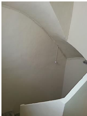
Figura 50: Escalera interior de campanario.
