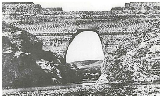
Figura 8: Pantano de Puentes tras su rotura en el año 1802.
