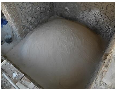
Figura 30: Bóveda Capilla Lateral.
