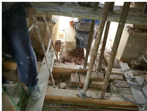
Figura 77: Ladrillo macizo utilizado en la recuperación de las fábricas.
