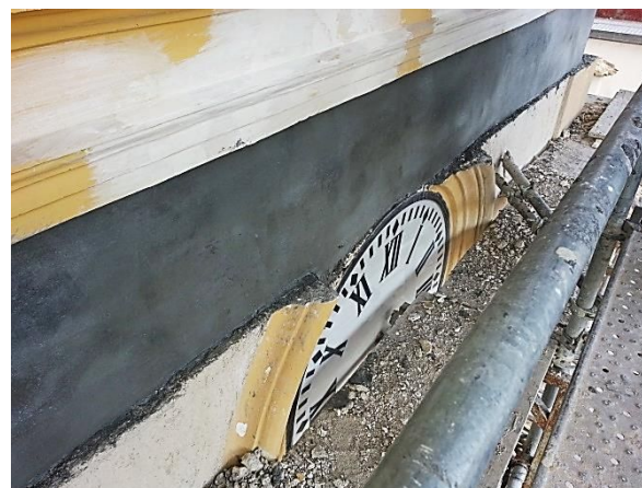
Figura 63: Regularización de superficie, para recibir las bandas de refuerzo. Picado de moldura de reloj.
