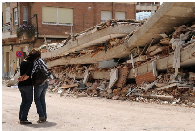
Figura 10: Edificio colapsado, C/ Infante Juan Manuel y C/ Talleres.
