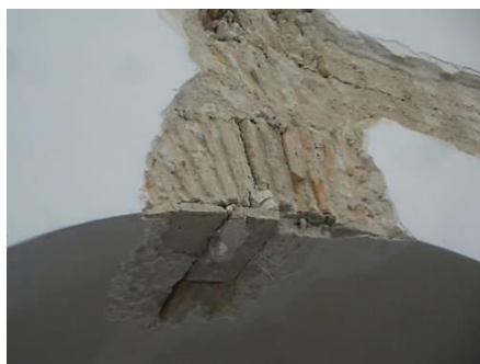
Figura 5: Formación arco de medio punto.
