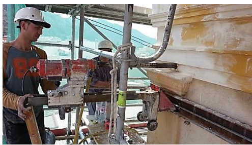
Figura 55: Realización de las perforaciones mediante máquina perforadora.
