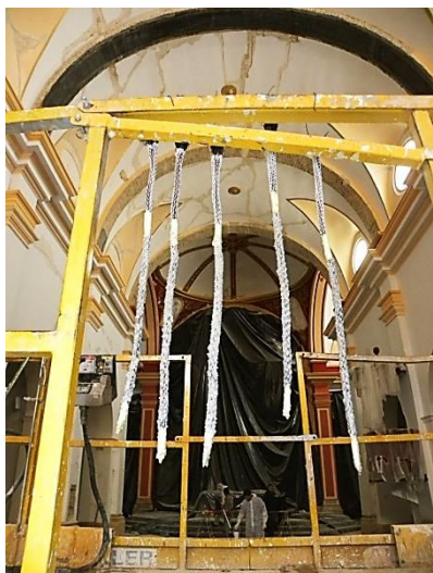
Figura 37: Preparación de los elementos fioccos.
