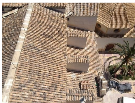
Figura 9: Imagen general de las cubiertas del templo.
