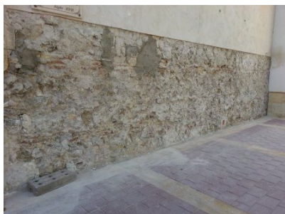
Figura 105: Picado de paramento.
