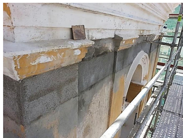
Figura 65: Capa de mortero de cal, recuperando la geometría de las fachadas.
