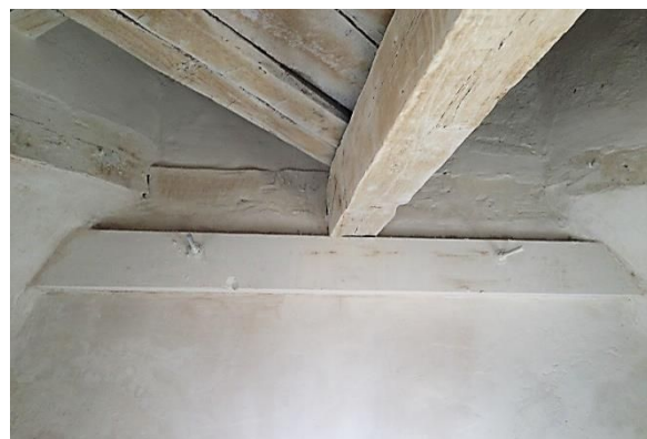
Figura 80: Aspecto final con revestimiento de pintura blanca a la cal.
