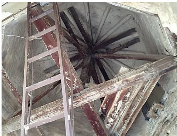
Figura 47: Estructura interior de cúpula.
