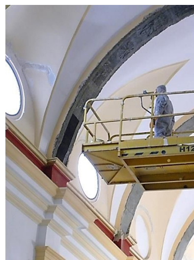
Figura 42: Colocación de la última banda de fibra de carbono.
