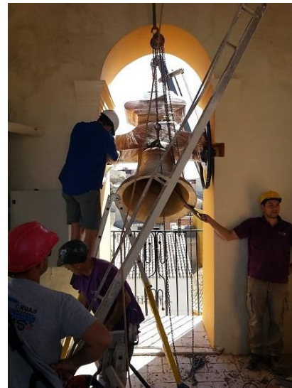
Figura 83: Colocación de nuevas campanas.
