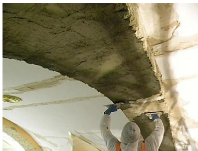
Figura 30: Aplicación de la capa de regularización mediante llana.
