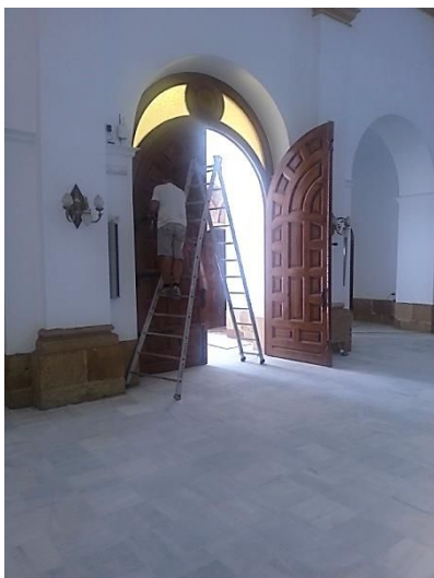
Figura 125: Lijado y barnizado.
