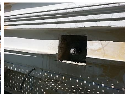
Figura 60: Final del refuerzo.
