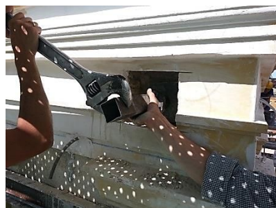
Figura 59: Tensionado de barras mediante doble tuerca.
