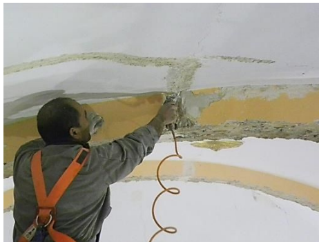
Figura 18: Soplado uniforme de las grietas.
