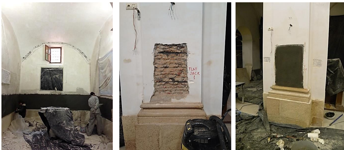
Figura 53: Mortero de reparación en la capilla del Bautismo.
