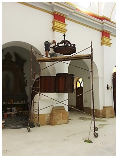
Figura 126: Reparación del púlpito.
