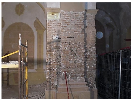
Figura 4: Fábrica de ladrillo macizo en paramentos interiores.
