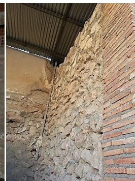
Figura 19: Estructura de contrafuerte.
