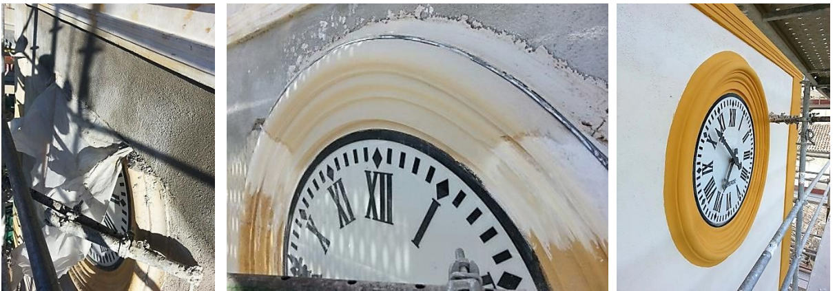
Figura 88: Proceso de recuperación de moldura de reloj.
