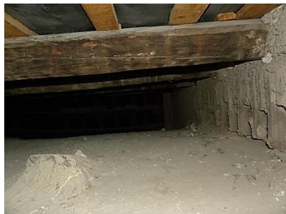
Figura 36: Cubierta Nave Central.
