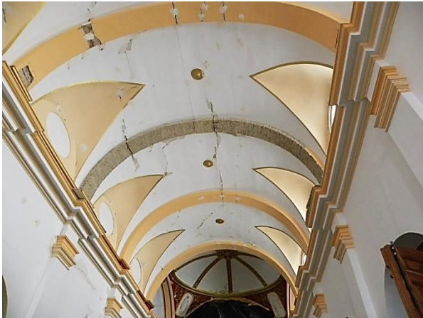
Figura 28: Picado de la primera hoja del intradós.
