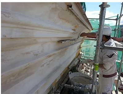
Figura 14: Molduras del campanario con yeso aditivado.
