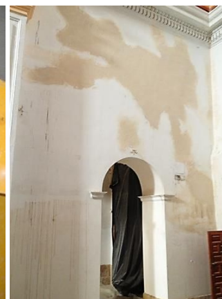
Figura 51: Enlucido de yeso, crucero evangelio.
