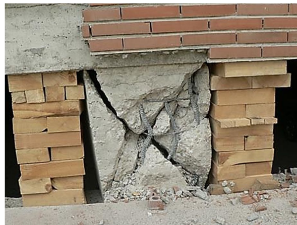
Figura 12: Pilar corto agotado.
