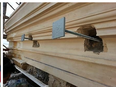
Figura 72: Arriostramiento con placas de acero.
