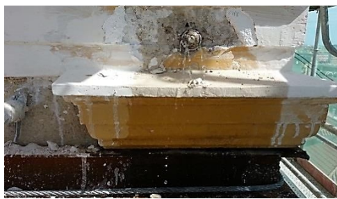
Figura 56: Taladro atravesando la longitud del campanario.
