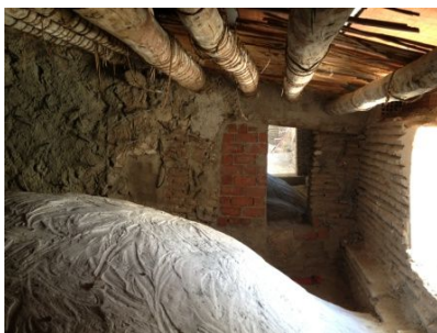
Figura 114: Refuerzo con machón de ladrillo.
