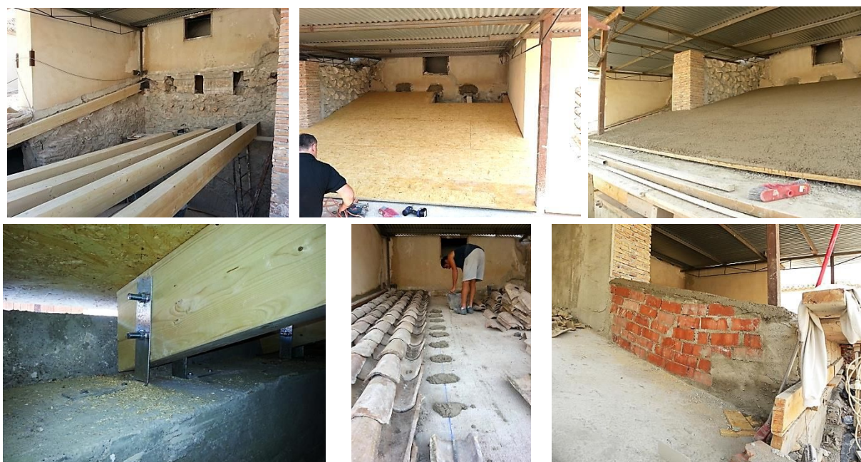
Figura 118: Montaje de Cubierta en las capillas nº 3 y nº4.
