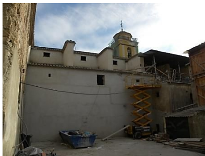
Figura 7: Acceso a bóveda nave central.
