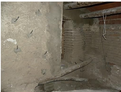
Figura 18: Muros bajo cubierta sustentados por rollizos de madera.
