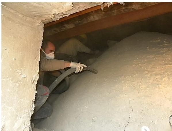
Figura 12: Limpieza y saneado de grietas mediante aspirado manual.
