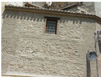
Figura 1: Mampostería con verdugadas de ladrillo en la fachada sureste.
