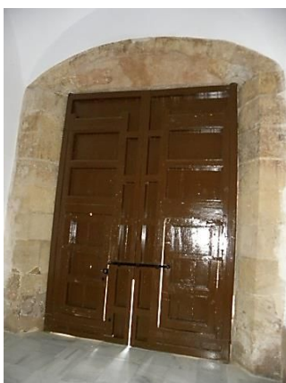
Figura 25: Arco adintelado.
