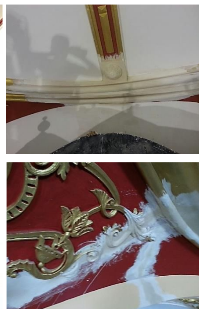
Figura 25: Recuperación de molduras y decoraciones con yesería.
