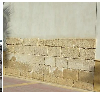
Figura 3: Zócalo torre Campanario realizado en Sillería.
