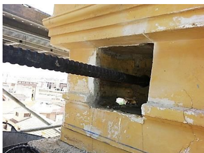
Figura 58: Colocación de barras DYWIDAG.
