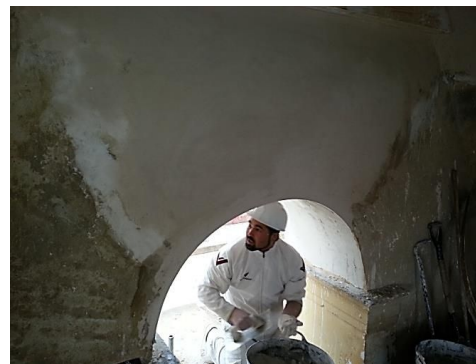
Figura 78: Recuperación de la geometría de los arcos.
