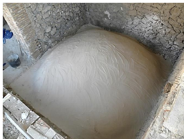
Figura 117: Atarrajado de yeso.
