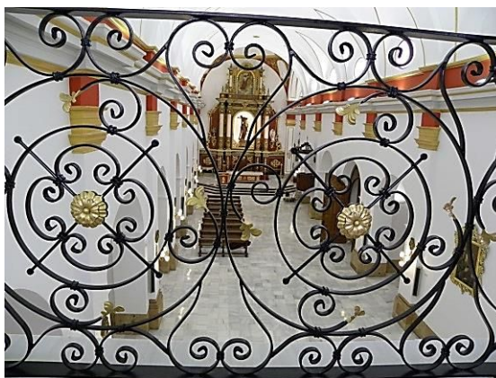
Figura 37: Barandilla situada en la zona del coro.
