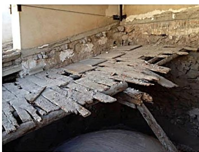
Figura 41: Estructura original con tablero de madera.
