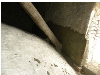
Figura 113: Consolidación de fábrica.
