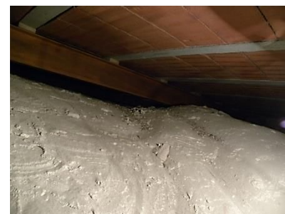
Figura 16: Viga metálica presente en las bóvedas del crucero del evangelio y epístola.
