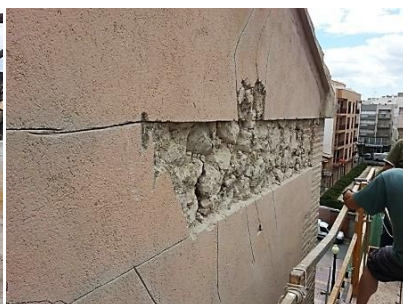
Figura 94: Picado de superficie.
