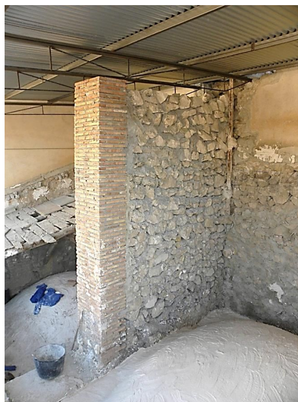
Figura 110: Ejecución de contrafuerte.
