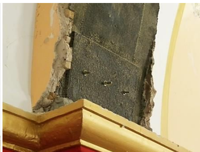
Figura 44: Capa de arena de sílice para mejorar la adherencia.
