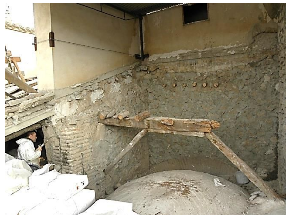
Figura 112: Inyección de cubierta en los paramentos.
