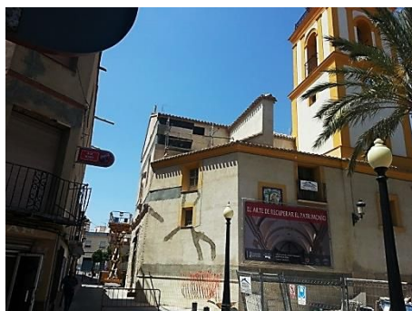
Figura 98: Refuerzo sobre fachada SE.
