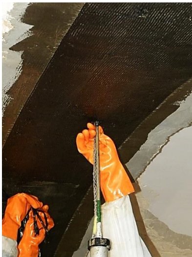
Figura 38: Inyección de resina epoxídica en la colocación.
