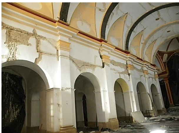
Figura 47: Saneado de grietas muro nave central.
