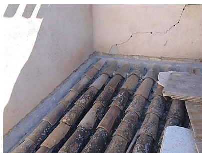
Figura 119: Roza en el perímetro de los muros.
