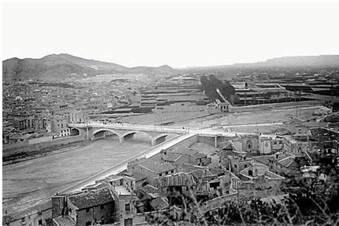
Figura 10: Puente de Piedra de Rocafull.
