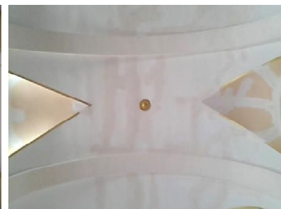
Figura 22: Aplicación de fondeado de tratamiento final.
