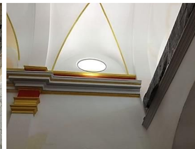
Figura 31: Luneto en Nave Central.
