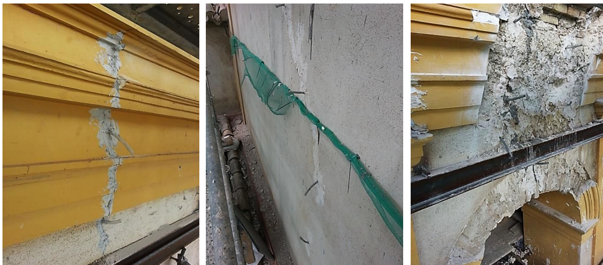
Figura 89: Inyección de cal en los paramentos exteriores del campanario.
