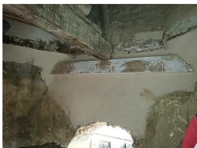
Figura 71: Ejecución de Refuerzo.
