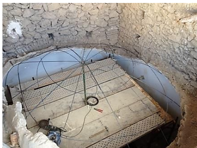
Figura 29: Creación de Bóveda.
