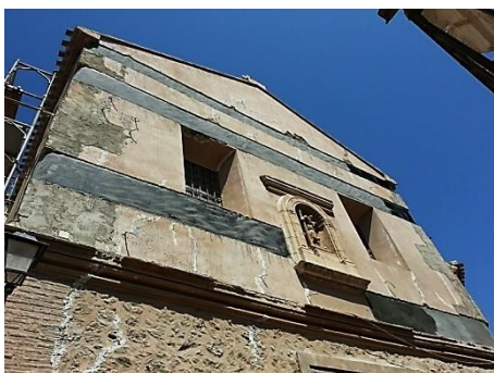
Figura 97: Refuerzo en Fachada SW.
