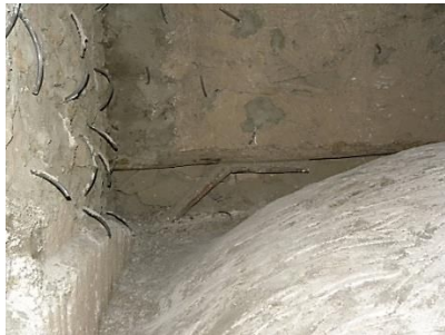
Figura 10: Maderas imbricadas en las fábricas de mampostería en las capillas superiores.
