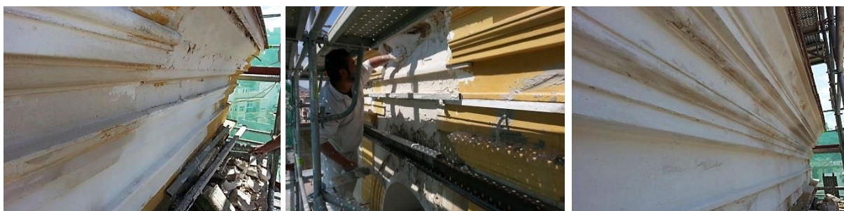
Figura 86: Proceso de recuperación de molduras en fachadas de campanario.
