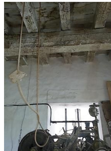
Figura 51: Forjado reloj campanario.
