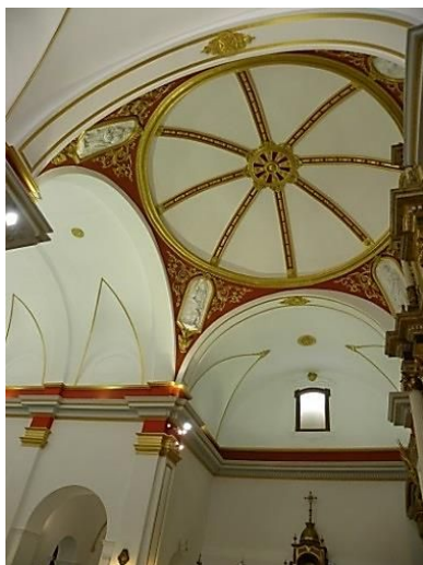
Figura 32: Cúpula con pechinas.
