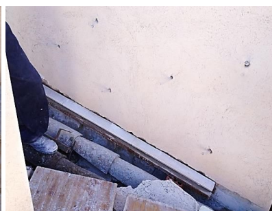
Figura 120: Colocación de albardilla pétreo.
