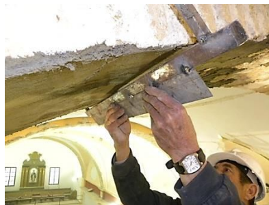
Figura 31: Homogeneizado de la capa de regularización.
