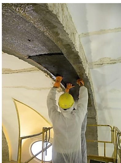
Figura 35: Colocación de 1ª banda de fibra de carbono.
