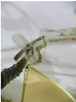
Figura 17: Picado y saneado de grietas.
