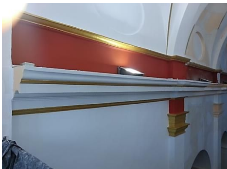
Figura 128: Revisión instalación eléctrica.
