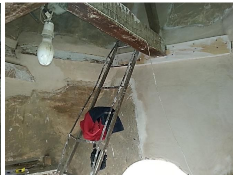
Figura 75: Refuerzo con varillas.
