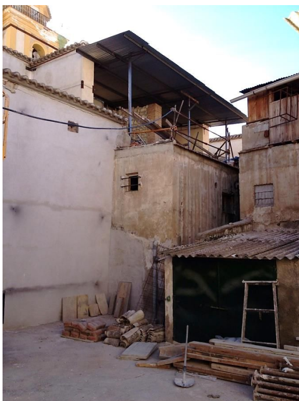
Figura 109: Cubierta provisional.
