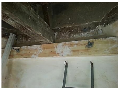
Figura 70: Anclaje mediante varilla de acero.
