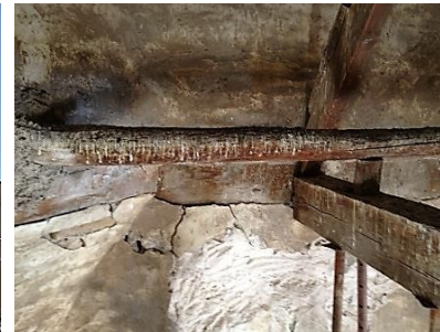
Figura 12: Estructura de madera situada en el campanil arriostrando el cuerpo superior.
