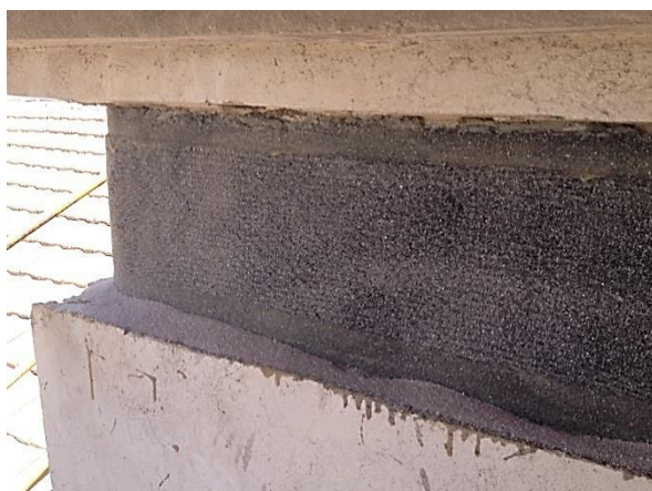
Figura 64: Aplicación de bandas de fibra de carbono. Esquinas redondeadas.
