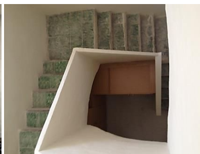
Figura 54: Solado en peldaños de escalera.
