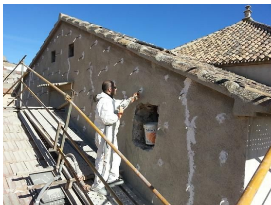
Figura 103: Inyección de Cal en paramentos.
