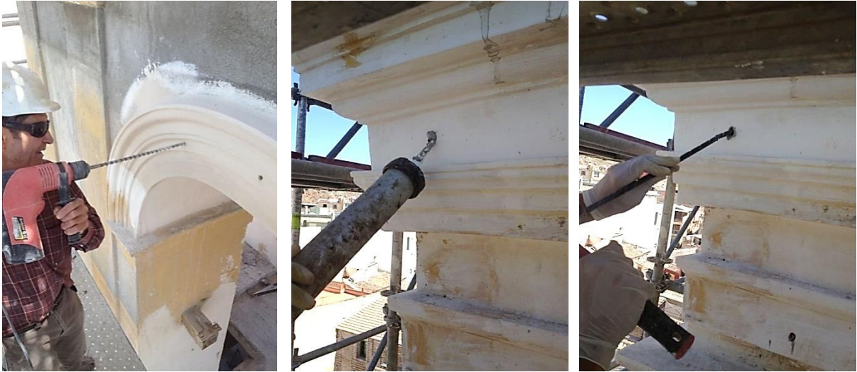
Figura 87: Anclaje de molduras con varillas de fibra de vidrio.
