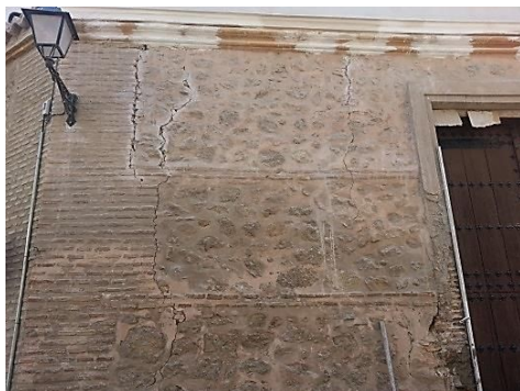
Figura 17: Técnica empleada para la ejecución de los muros portantes.
