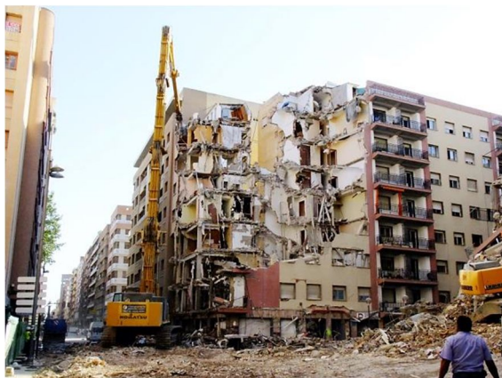
Figura 9: Demolición del Edificio Residencial San Mateo 2.
