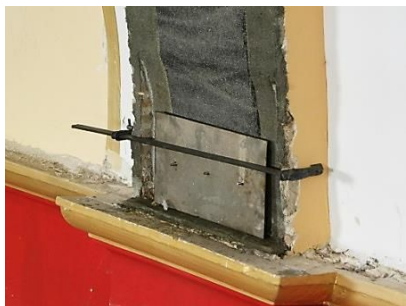
Figura 43: Colocación de placas de acero tratado.
