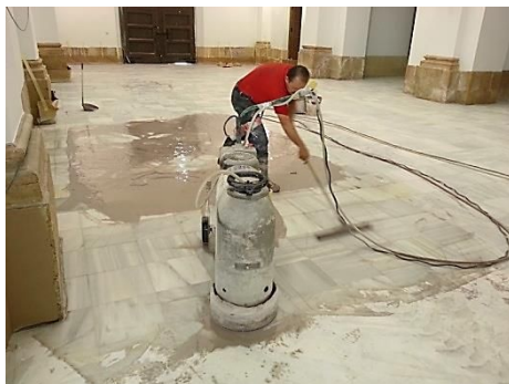
Figura 129: Pulido y abrillantado de solado
