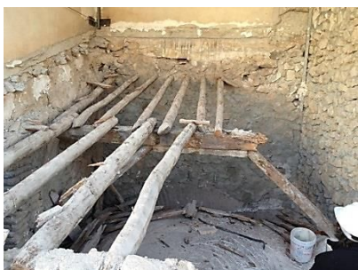
Figura 40: Estructura cubierta original.
