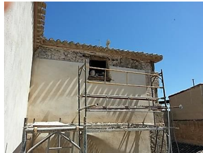
Figura 11: Rollizos de madera a modo de dintel en los huecos practicados.
