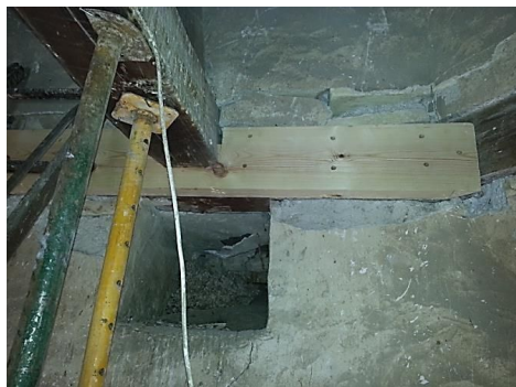
Figura 74: Refuerzo de recalce.
