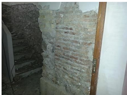
Figura 90: Picado de zócalo.
