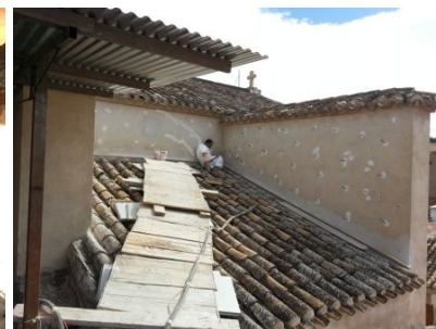
Figura 115: Inyección de cal en contrafuertes.
