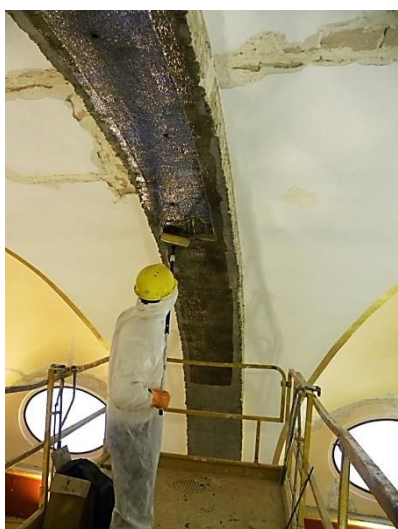
Figura 34: Aplicación de resina epoxídica.
