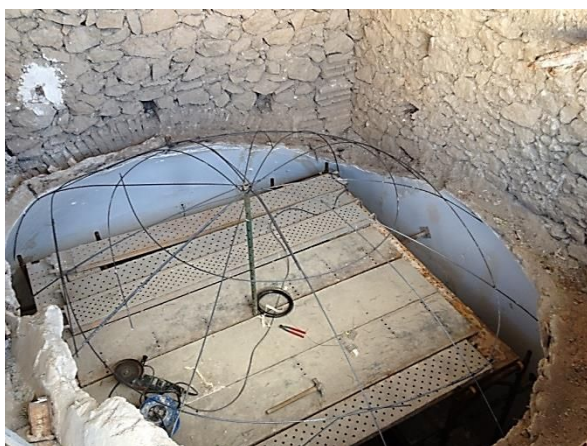
Figura 116: Creación de cúpula en la capilla nº3.
