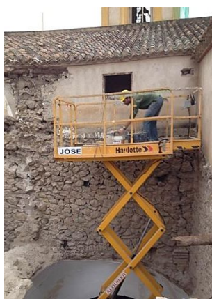
Figura 4: Vista exterior tras el derrumbe.
