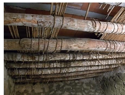
Figura 42: Estructura original con doblado de cubierta actual.
