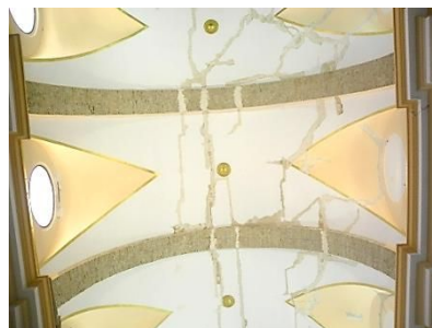
Figura 21: Picado y enlucido de grietas.
