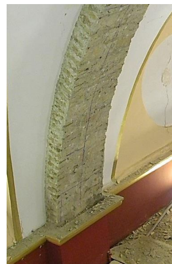
Figura 23: Arranque arco fajón, sin la capa inferior.
