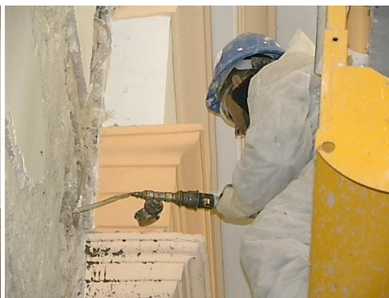
Figura 50: Inyección de Cal en paramentos interiores.
