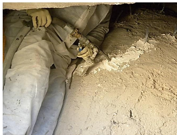
Figura 13: Inyección de cal, a través de las cánulas perforadas en las fisuras.
