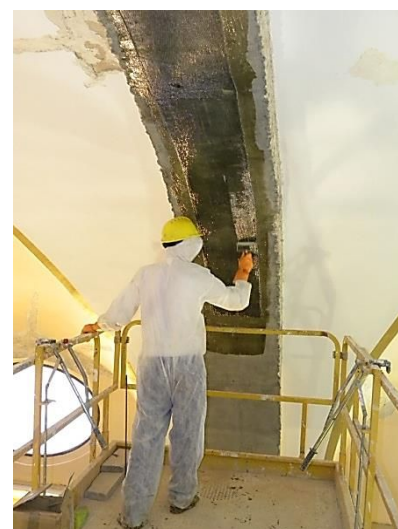
Figura 36: Repaso con tornillo sin fin para eliminar el aire interior.
