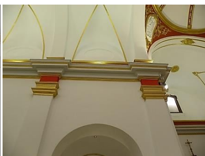
Figura 21: Moldura perimetral en toda la Iglesia.
