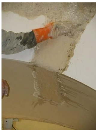
Figura 49: Aplicación malla de fibra de vidrio.
