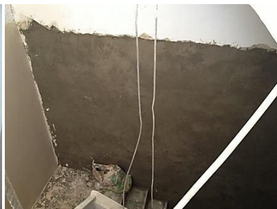
Figura 91: Enfoscado con mortero hidrófugo.
