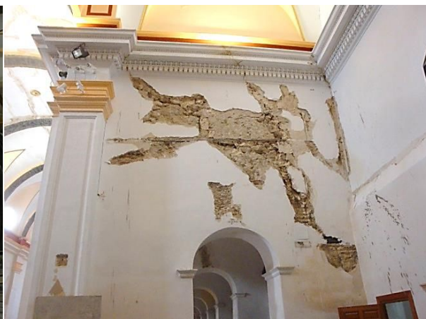
Figura 48: Saneado de grietas crucero evangelio.
