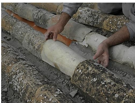
Figura 8: Retejado de cubiertas.
