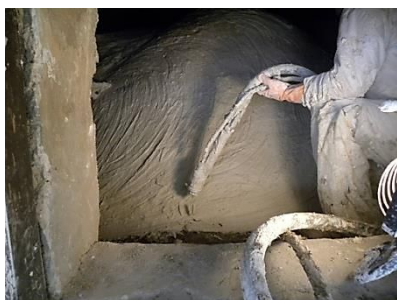
Figura 14: Atarrajado de bóveda mediante proyección de cal reforzada.
