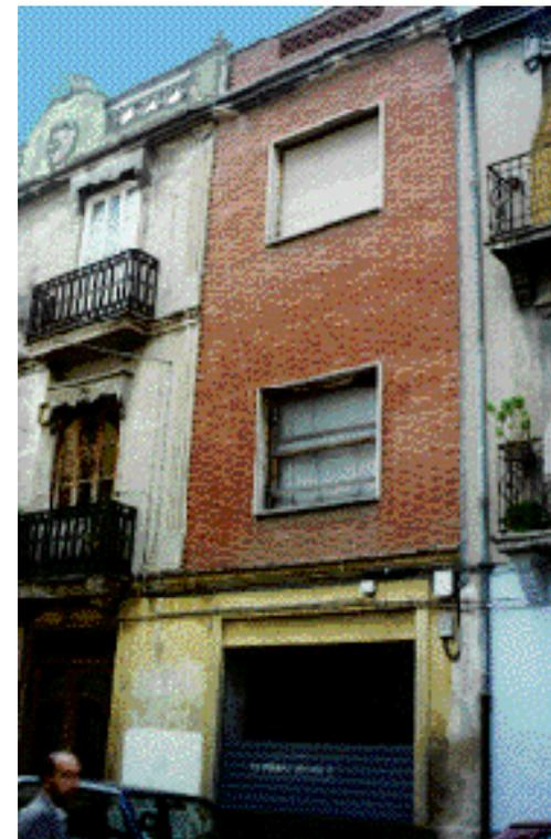
La fábrica aparece en un plano exento y muy desvinculado. Únicamente la planta baja y la prolongación de las molduras enlazan el paramento descrito con el resto del edificio. El hecho de que la fábrica cara vista presente su traba abierta, en la unión con el paramento enfoscado del edificio, hace pensar que ha sido un "añadido" al edificio original o una ampliación, para nosotros poco afortunada.
