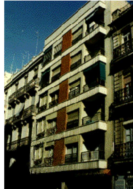
La línea de imposta muy acusada, interrumpe en cada planta el plano central de la cara vista del cuerpo volado.
