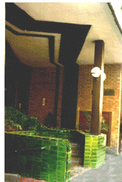
La fábrica se utiliza únicamente en los paramentos que limitan la entrada del edificio, tanto del zaguán como del garaje y se combina con cerámica vidriada del color liso verde musgo en las jardineras y con distintas líneas quebradas que continúan en el techo.
