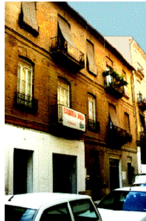
Las líneas de imposta, de parte a parte del edificio, aparecen molduradas utilizando un ladrillo aplantillado romo. Por debajo de los huecos de la fachada aparece una fábrica dentada alternando el vuelo de los ladrillos consecutivos colocados a rosca.
