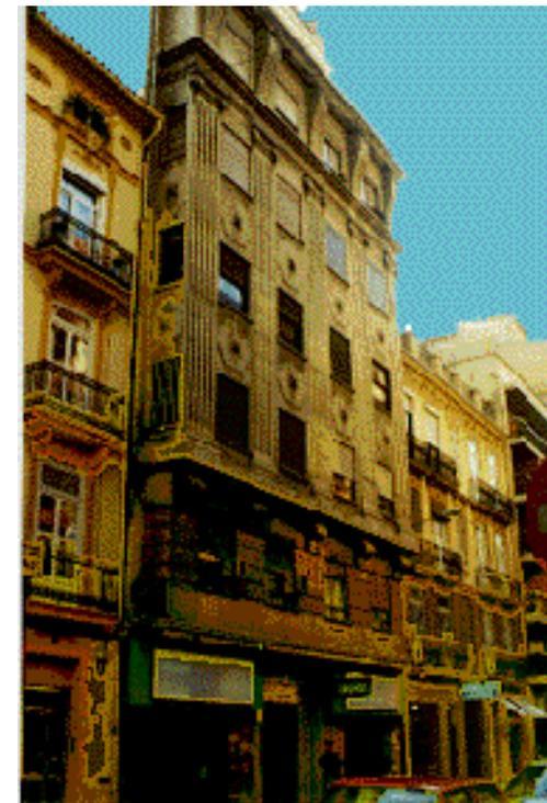
La fábrica de ladrillo cara vista presenta la particularidad de tener una hilada rehundida cada seis hiladas, acusando un efecto de horizontalidad.
