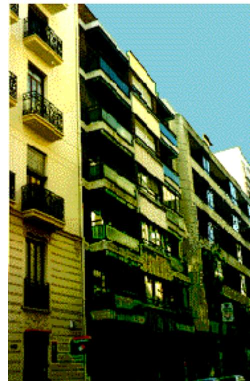
La fábrica se ve interrumpida por las líneas de imposta que, cuando alcanzan el cuerpo volado, se ensanchan ocupando todo el espacio entre el dintel de las ventanas y el antepecho de la planta superior.
