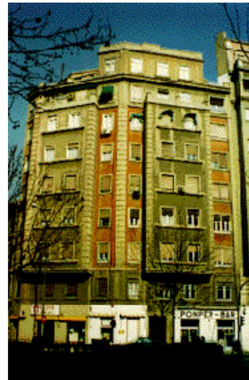
La fábrica cara vista, se imita acusando sobre el enfoscado los tendeles y pintando la superficie con pintura de color rojo.
