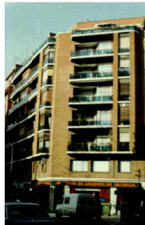
Los dinteles de los huecos de la planta 1ª están resueltos con aparejo recto de un pie y medio de canto; en las plantas altas, a partir de la 2ª, los dinteles de puertas y ventanas están revestidos de gresite. En los cuerpos volados y en el plano de la fachada, la fábrica cara vista, arranca y se remata con líneas de imposta continuas de color blanco.
