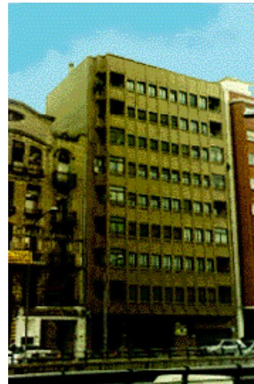
El cuerpo volado se divide en la dimensión de los vanos con bandas continuas resaltadas, utilizando para ello dos piezas a tizón. En el ángulo del cuerpo volado con el plano de la fachada aparecen unas jardineras.
