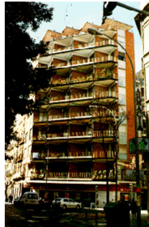
El edificio resuelve el chaflán con planos en diente de sierra. Como excepción a la utilización de la cara vista, se puede destacar la utilización de planchas metálicas pintadas, entre los huecos de las ventanas en sentido vertical.
