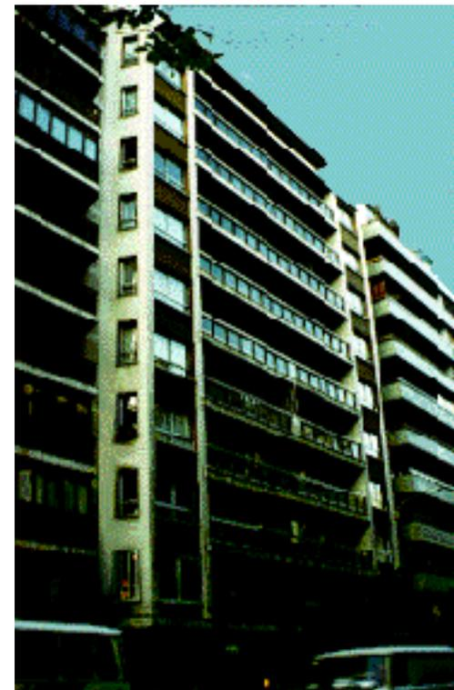
La fábrica cara vista se utiliza de dos formas: una en el frente de los cuerpos volados, formando de modo continuo el antepecho y dintel de los huecos de ventana; y la otra, entre los cuerpos volados, siguiendo el plano de la fachada que es quebrado con el interior de las solanas retranqueadas y también en los planos perpendiculares a ésta. Las líneas de imposta se acusan en todo el edificio, siendo continuas en el arranque del voladizo y en la última planta.
