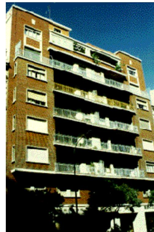
Las líneas de imposta sirven de arranque a la cara vista en la 1ª planta y de remate del edificio, siguiendo el mismo criterio en los cuerpos volados.
