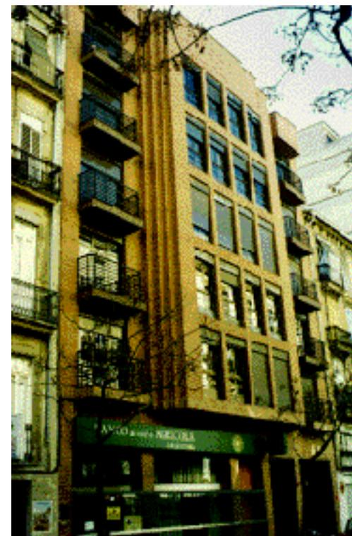
Del plano de la fachada al cuerpo volado se pasa mediante un escalonado sucesivo. En el frente del cuerpo volado la fábrica cara vista, forma una retícula enmarcando los huecos. Las líneas de imposta, se resuelven con aparejo a sardinel y rosca, todos los cuales dan un canto de pie y medio. Los voladizos de los balcones están pintados con color y tono acordes con el ladrillo.
