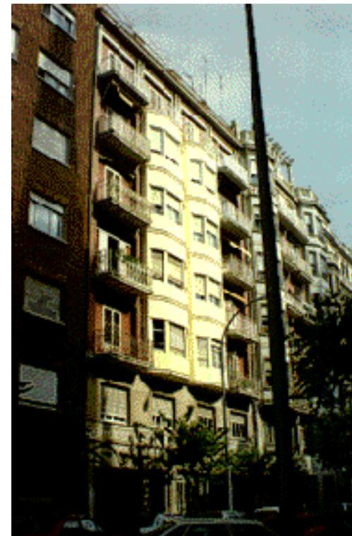
La fábrica forma dos bandas verticales, una a cada lado del edificio, que se unen con el plano de la fachada de la planta sexta.
