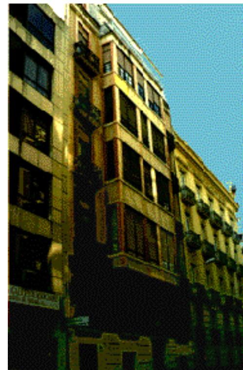
La fábrica se utiliza en los recercados de los huecos del plano de la fachada. En el cuerpo volado forma bandas con acusada verticalidad, aunque se interrumpen por franjas horizontales que van desde el dintel de los huecos hasta el remate del antepecho de la planta siguiente. La fábrica aparece muy decolorada.
