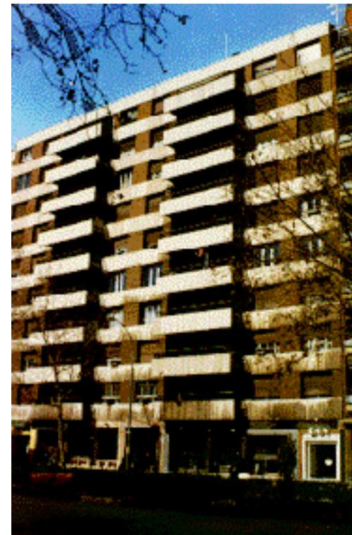
La fábrica se ve interrumpida en cada planta por franjas formadas con aplacado de piedra blanca, de anchura igual al dintel más el antepecho, de modo que la fábrica, en cada planta, tiene la misma altura que el hueco de las ventanas.
