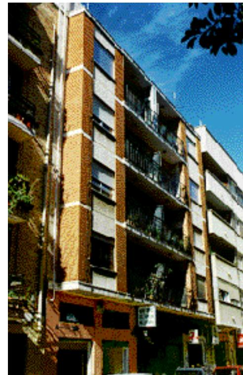
La fábrica se ve interrumpida por la línea de imposta de cada forjado y ocupa los dos cuerpo volados formando sus cantoneras, así como en el centro del plano de la fachada. Coincidiendo con la separación de viviendas en la solana, forma una banda entre los forjados de tres pies de anchura.
