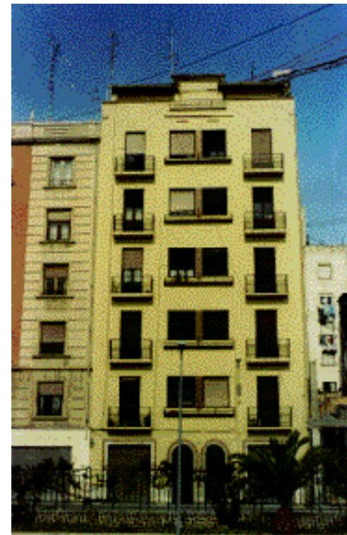
La fábrica aparece en la columna que divide a las ventanas pareadas en el centro de la fachada de las plantas 1ª a 5ª. Se utiliza una cenefa con el ladrillo a rosca rodeando los huecos de la planta baja desde la altura del zócalo. El acceso a la finca se realiza a través de una doble puerta con remate semicircular en el centro de la fachada. El mismo aparejo de rosca se repite como líneas discontinuas en el remate del edificio.
