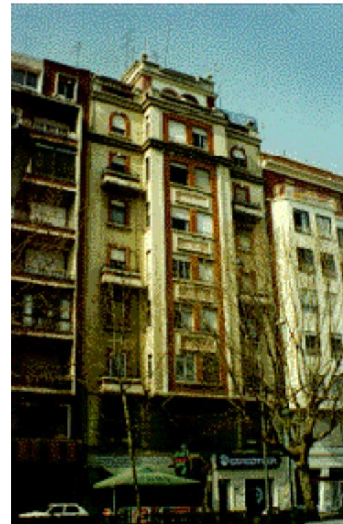
En el plano de la fachada, la fábrica se utiliza como recercado de los huecos que, en la planta séptima, se rematan con un arco de medio punto.
