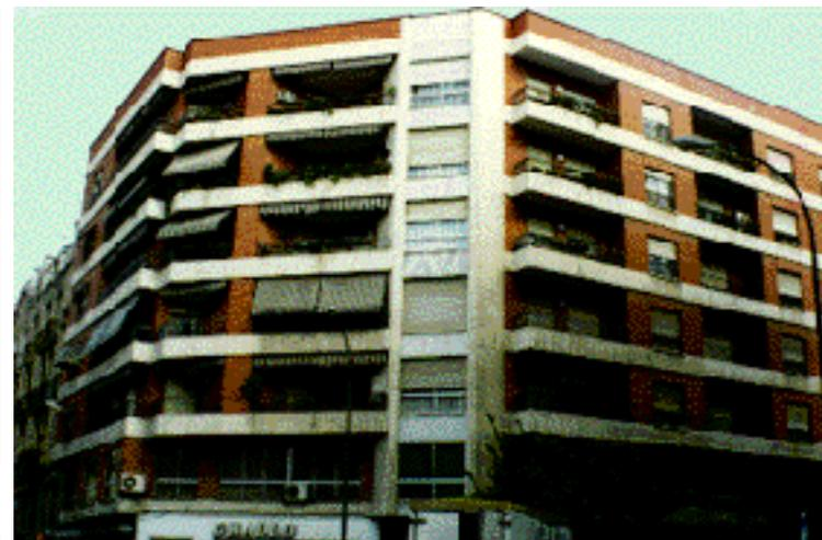
Se acusan franjas horizontales de aplacado blanco que, a la altura de las barandillas de las solanas y de los antepechos de las ventanas, recorren todo el edificio, interrumpiéndose en una de las esquinas del chaflán con un paramento vertical aplacado de color blanco.
