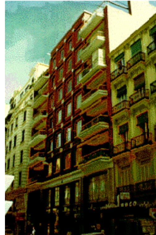
El cuerpo central forma una retícula enmarcando los huecos de las ventanas, que se consigue resaltando, del plano de la fachada, dos ladrillos colocados a tizón y en medio de ellos un ladrillo a soga. En los puntos de cruce de la retícula, aparecen cuadros de piedra blanca para evitar utilizar el encuentro a inglete o a testa entre los ladrillos.
