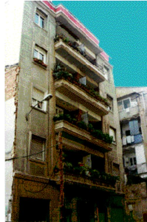
La fábrica ocupa todo el perímetro de las solanas en su plano retranqueado de la fachada y los planos perpendiculares a la misma. También ocupa la parte central del remate del edificio que sigue el contorno del cuerpo central volado.
