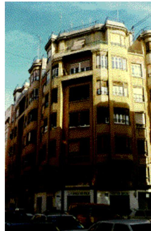
La fábrica aparece a ambos lados del recercado común de los huecos, desde la planta 1ª a la planta 5ª, uniéndose mediante una franja horizontal en esta última planta. Los nombres del constructor A. Martínez y del arquitecto aparecen en la fachada. Avance Catálogo del Centro Histórico y Primer Ensanche de la Ciudad de Valencia (FICHA S4-149).
