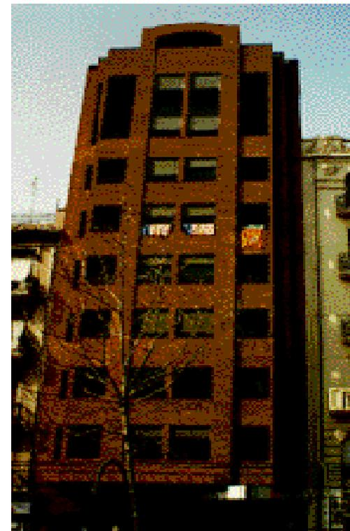
El edificio se remata con un gran arco rebajado de tres pies de canto. En la planta baja otro arco, también rebajado, de dos pies de canto, ocupa todo el ancho de la fachada y se ve interrumpido por dos pilares de hormigón de planta circular que no se integran en él.
