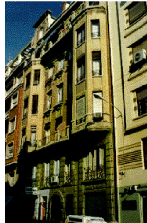
La separación entre viviendas, en los balcones corridos, se resuelve con fábrica de ladrillo cara vista que, con un escalonado cada dos hiladas, sigue una directriz de un cuarto de circunferencia. El remate de los huecos que corresponden a los dos laterales del edificio, se solucionan con arco de medio punto con la clave enfoscada y aparejo de sardinel.
