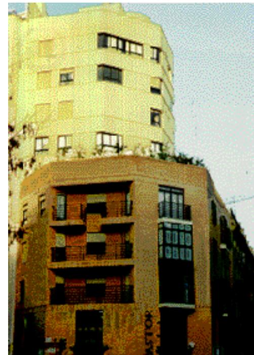
El zócalo está formado por un plano rehundido con un aparejo a sardinel. Las dos líneas de imposta, de la planta primera y del forjado de la terraza, están resueltas a sardinel, al igual que los frentes de los balcones.
