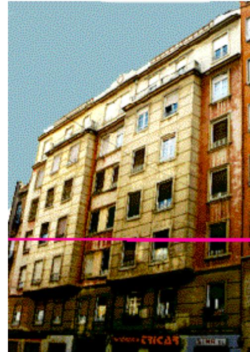
La fábrica cara vista es simulada sobre el enfoscado de la fachada, apareciendo muy decolorado el rojo con que se pintó.
