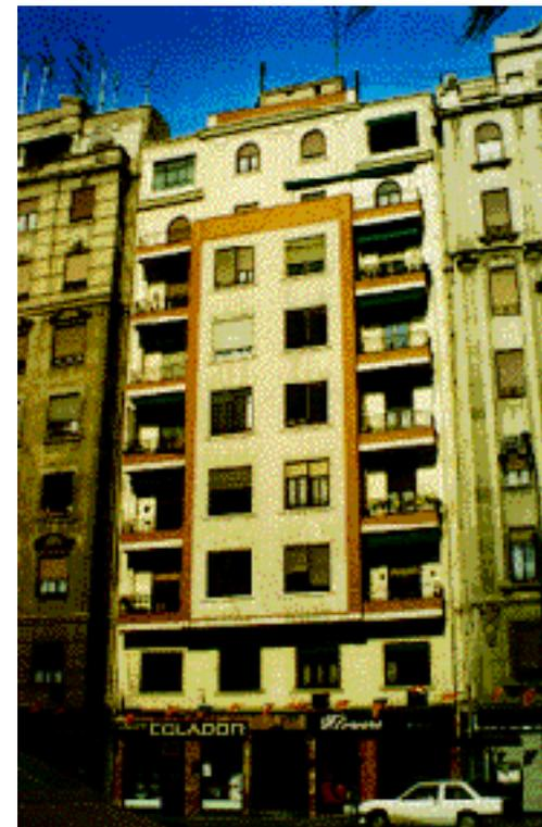
La fábrica cara vista, enmarca el cuerpo volado por sus laterales y por la parte superior, no haciéndolo en el arranque del cuerpo volado en el cual se acusa la línea de imposta.
