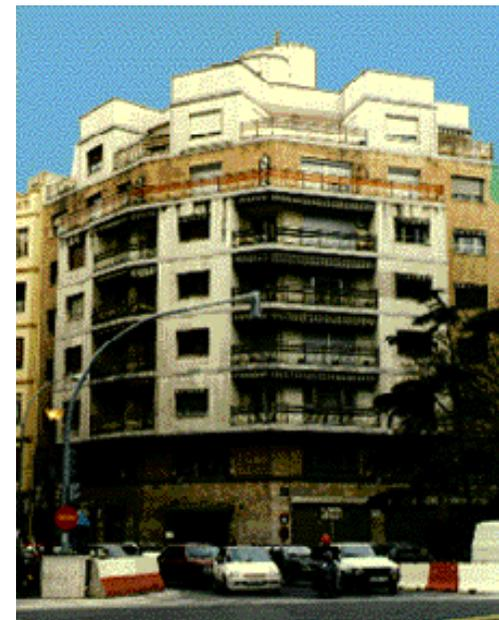
La fábrica cara vista que ocupa el plano de la fachada, enmarca totalmente al conjunto de cuerpos volados y solanas.
