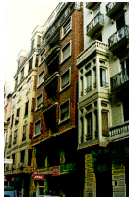
En las esquinas exteriores de los cuerpos volados se utiliza ladrillo apantillado romo.
