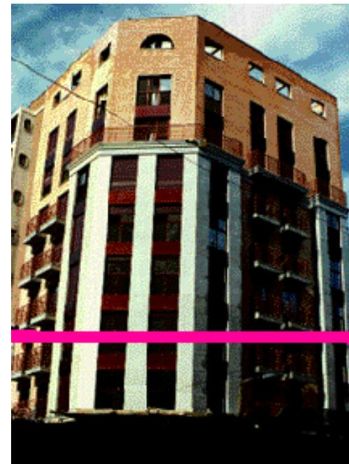
El edificio, de reciente construcción, recupera la utilización de balcones con barandilla metálica en las plantas primera a sexta. En el chaflán el hueco de la última planta se resuelve con un arco de medio punto y aparejo de rosca.
