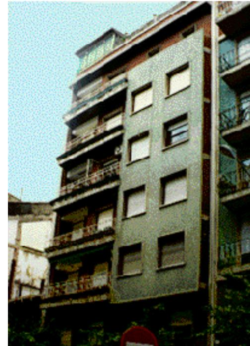
La fábrica se utiliza además en los dos planos perpendiculares del cuerpo volado, cuyo frente está revestido con gresite.
