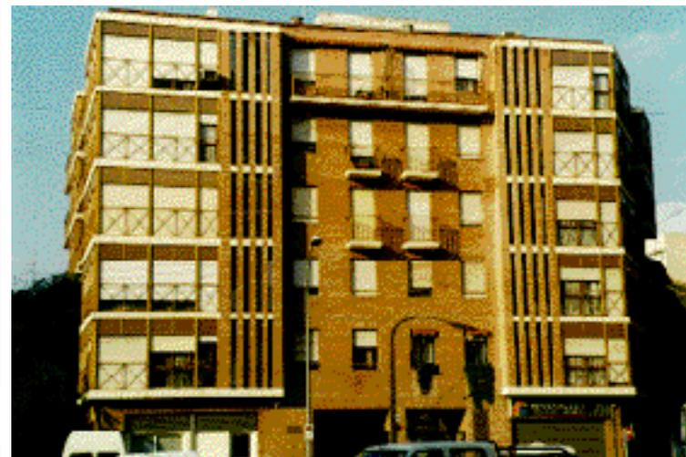
En las esquinas de los cuerpos volados, aparecen muros calados de composición vertical. Estos muros están formados por dos bandas de un pie y medio de anchura, entre las que se alojan otras tres de un pie de anchura.
