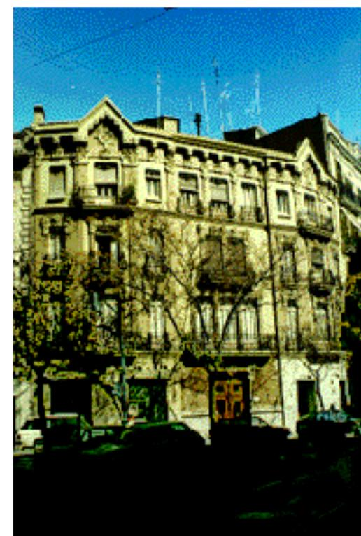
En la planta baja, la fábrica únicamente aparece en la zona central del chafflán, sobre zócalo de piedra, enmarcando la puerta del zaguán. En las plantas 1ª a 3ª, enmarca a su vez los huecos, ocupando el plano de la fachada en la planta 3ª. En las fachadas laterales ocupa el plano de la fachada. Todo el edificio se remata por debajo de la cornisa por una franja de cara vista en la que son de destacar los arcos planos de pie y medio de canto.
