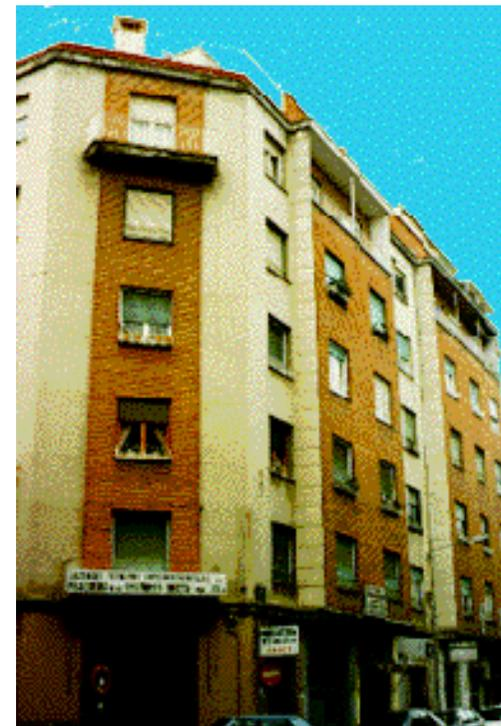
El edificio presenta distintas alturas según las calles. La fábrica cara vista remata el edificio en la parte del antepecho de la terraza, en la que no se utiliza barandilla metálica.
