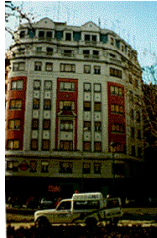
La fábrica está simulada acusando los tendeles en el enfoscado pintado de rojo. La última planta se remata con baldosines pintados de color verde, recordando la colocación de la pizarra en plantas abuhardilladas, dada la fuerte inclinación del plano revestido.
