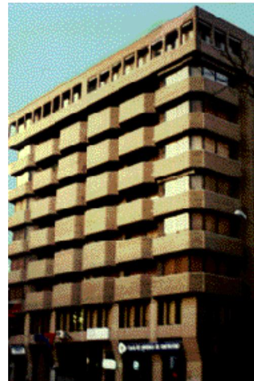
Los antepechos de los cuerpos volados y voladizos son progresivamente más altos desde los chaflanes hacia el centro de la fachada, en la calle Guillém de Castro. Los voladizos, en la planta primera, se unen al plano de la fachada mediante pilastras que se escalonan en cada hilada de ladrillo a modo de un capitel, excepto en los dos pilares que limitan el zaguán que son uno metálico y el otro revestido de ladrillo cara vista, pero manteniendo el plano de la fachada.
