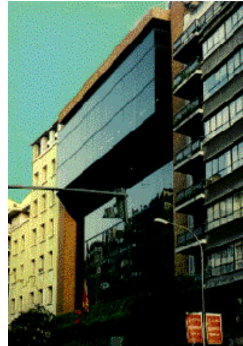
La fábrica cara vista es de ladrillo refractario y se utiliza para enmarcar el muro cortina.
