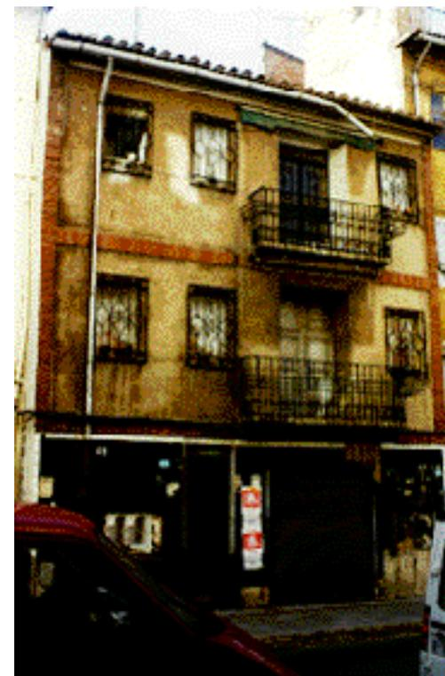
La fábrica enmarca los laterales del edificio con un pie de anchura y forma dos líneas de imposta de un pie de canto.
