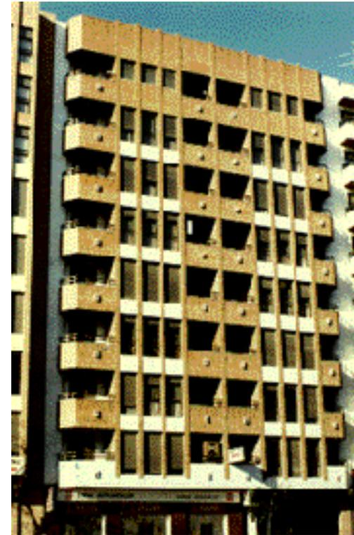
Las jambas entre ventanas y la separación de solanas, se prolongan hasta el antepecho de la terraza acusando un efecto de verticalidad.
