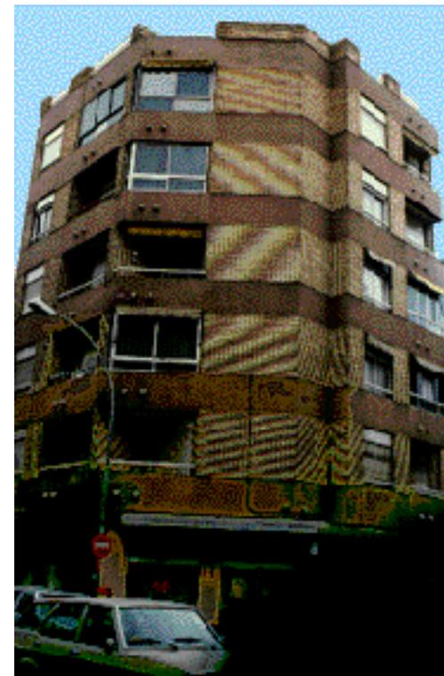
Las líneas de imposta fundidas con los antepechos forman unas franjas horizontales enfoscadas de lado a lado del edificio.
