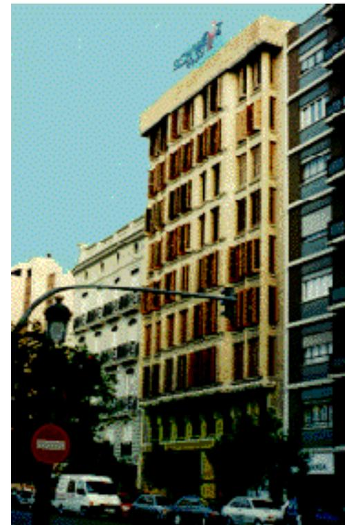
Los planos de la fachada forman una sucesión de diedros salientes, para cuyo arranque y remate se utilizan piezas labradas en forma de semipoliedros.
