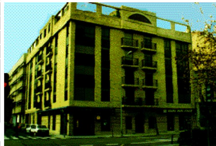
En el arranque de la planta 1ª se acusa, en los balcones, una línea a sardinel. La última planta aparece sobrevolada, arranca con un sardinel de pie y medio y se remata con una hilada a sardinel, o dos a sardinel y una rosca, según se trate del remate del dintel o del cuerpo del edificio.
