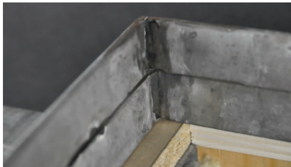
Figura 2.2.2.5: Soldaduras en la estructura
