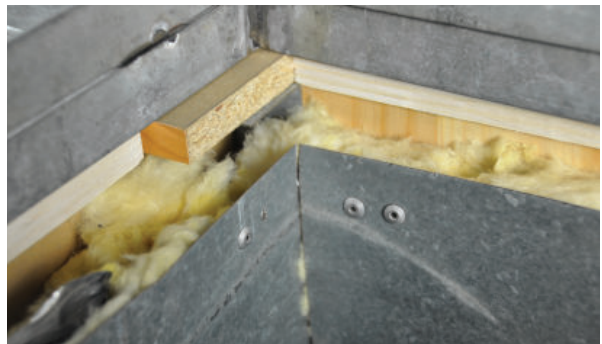
Figura 2.2.3.4: Separación entre estructuras
