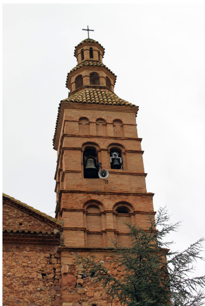
Figura 4 Detalle de la torre de tres tramos remata de doble linterna.
