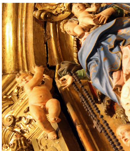
Figura 33 Junta abierta por el movimiento estructural
