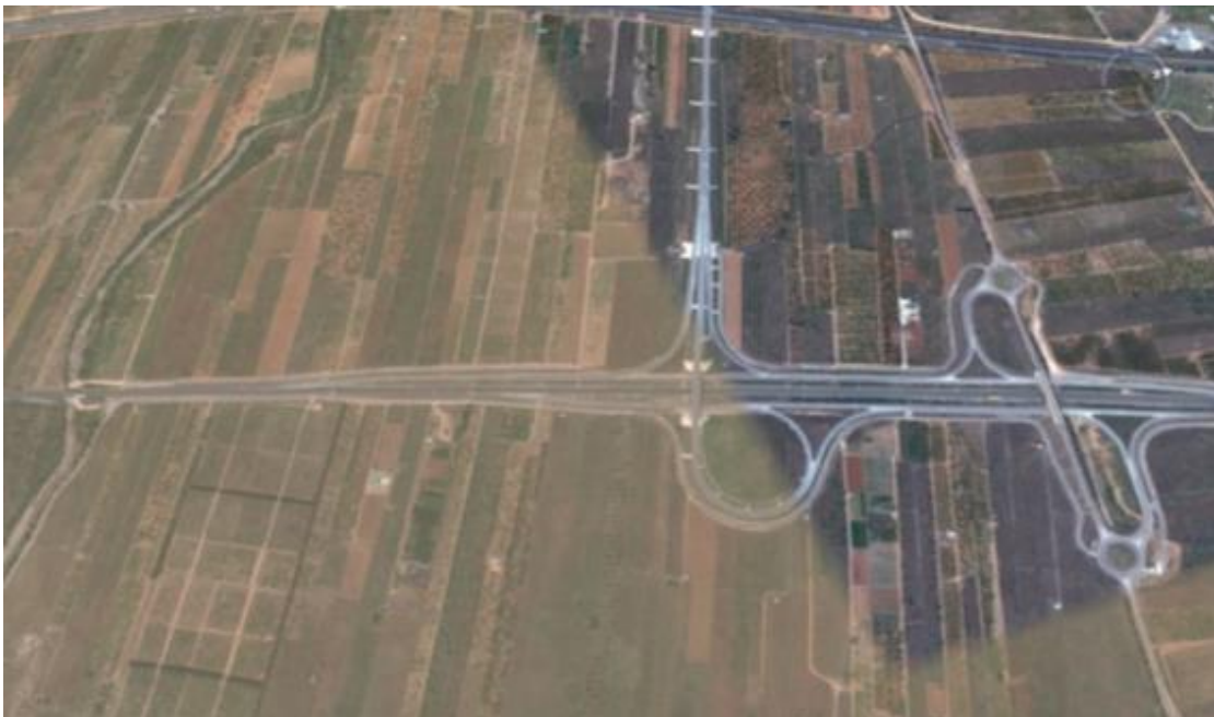
Figura 4. Vista aérea del enlace con la CV-148. Fuente: Google Earth.
