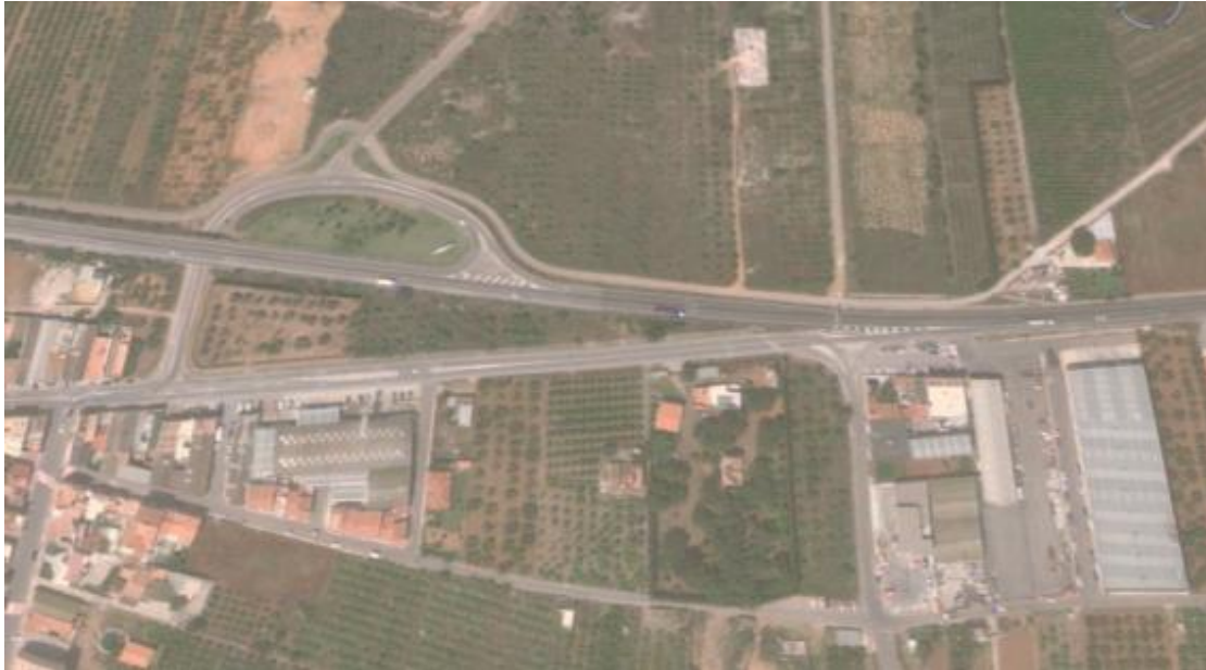
Figura 3. Vista aérea del enlace Oropesa Norte. Fuente: Google Earth.
