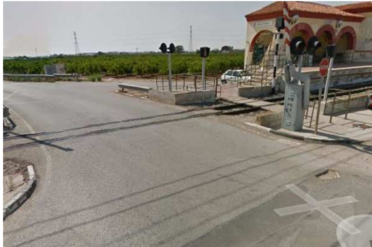
Foto 7: Apeadero de San Ramón (Paso a Nivel)
