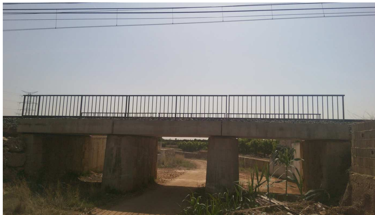
Foto 24: Puente sobre Barranco Alcadet (Lado derecho)
