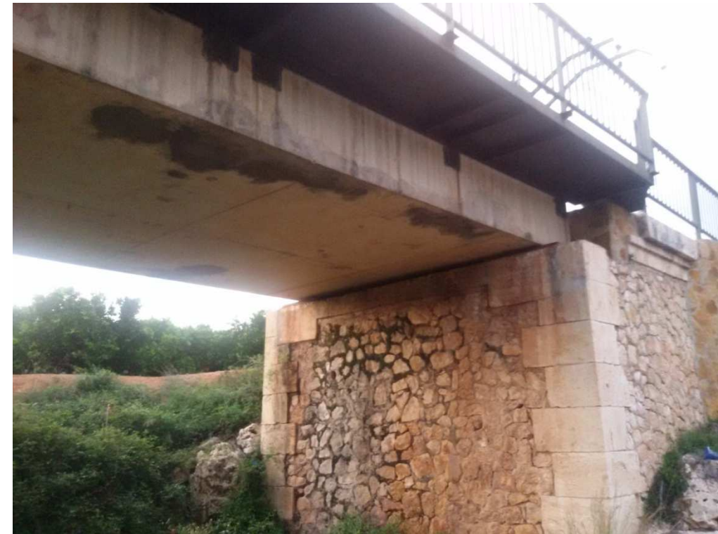
Foto 35: Puente Barranco Ciscar (Estribo, tablero, acera y barandilla)
