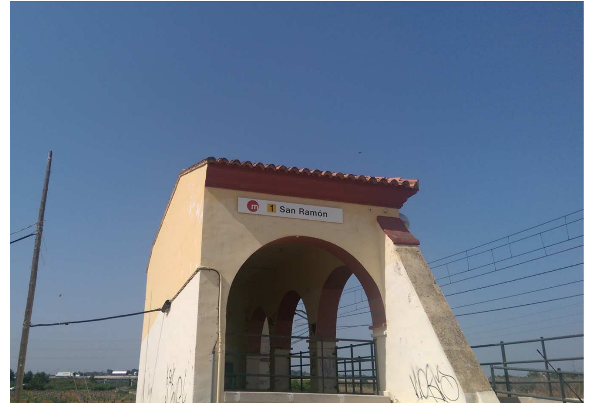
Foto 5: Apeadero de San Ramón (Edificio actual)
