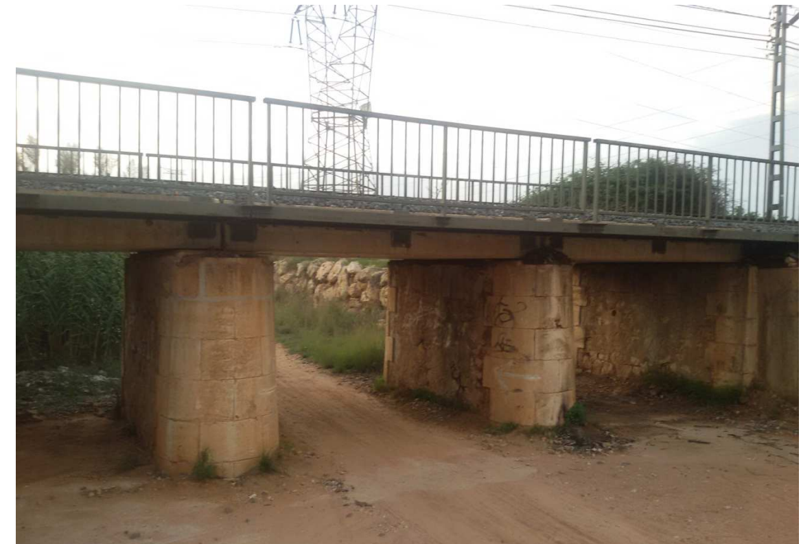
Foto 29: Puente Barranco Alcadet (Tablero sobre pilas centrales)
