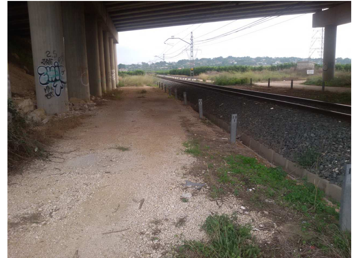
Foto 21: Paso superior sobre ferrocarril (Espacio para albergar vía doble)
