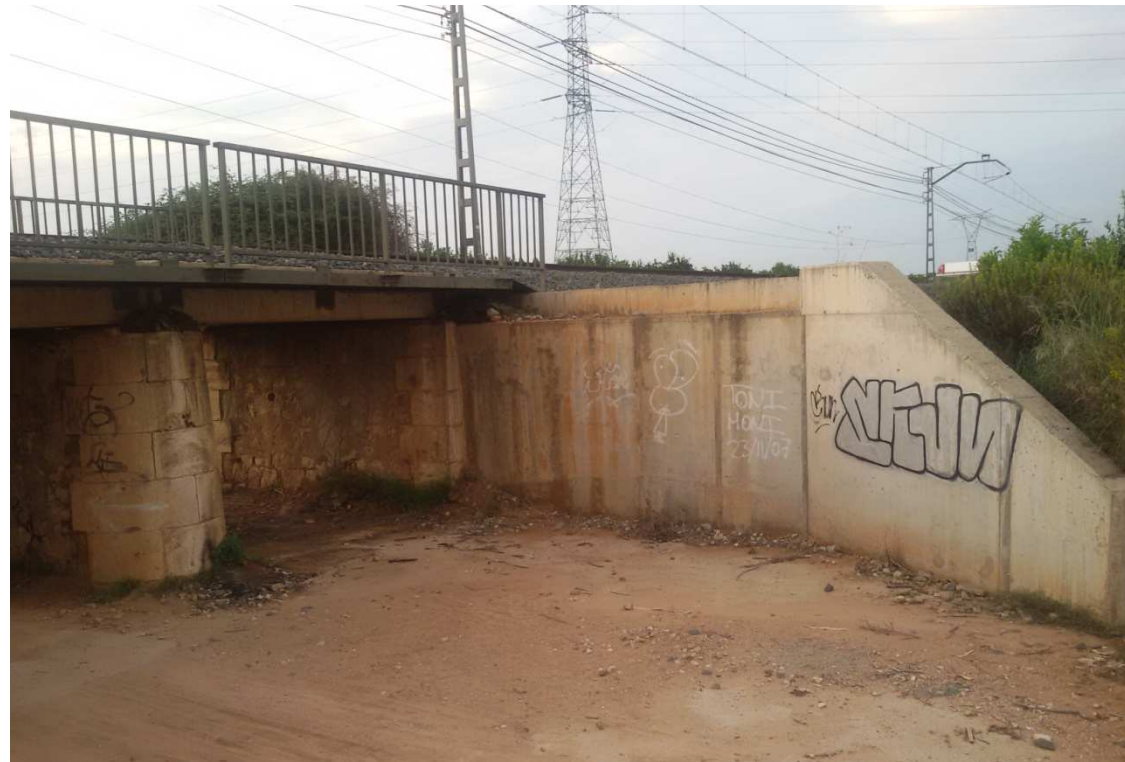
Foto 27: Puente Barranco Alcadet (Estribo y aleta Norte)
