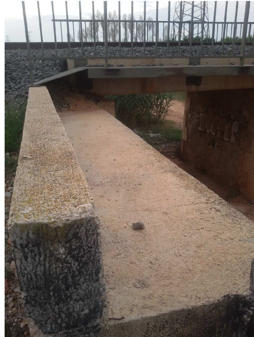
Foto 32: Puente Barranco Alcadet (Detalle estribos existentes para vía doble)
