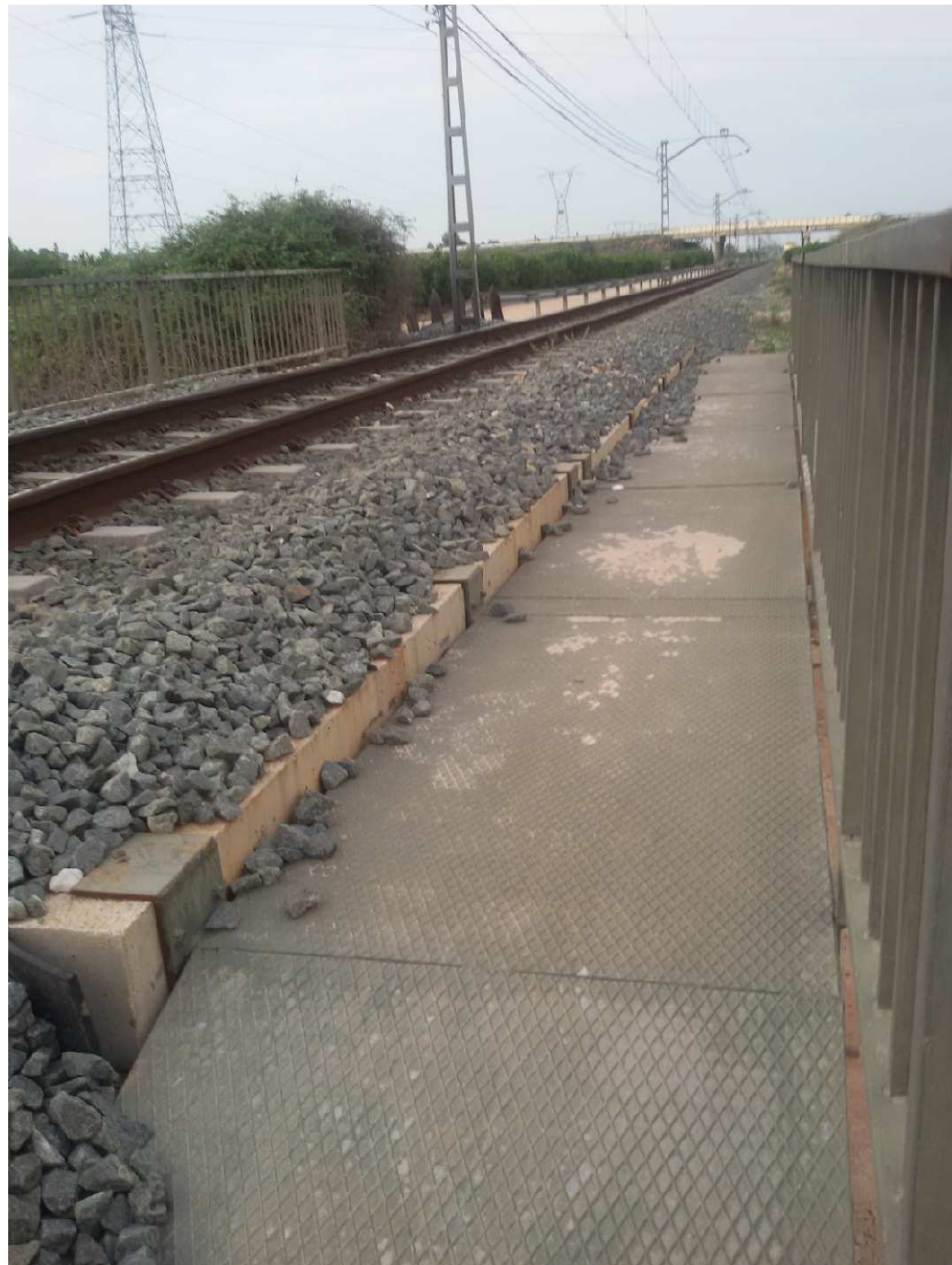
Foto 31: Puente Barranco Alcadet (Detalle acera y barandilla)
