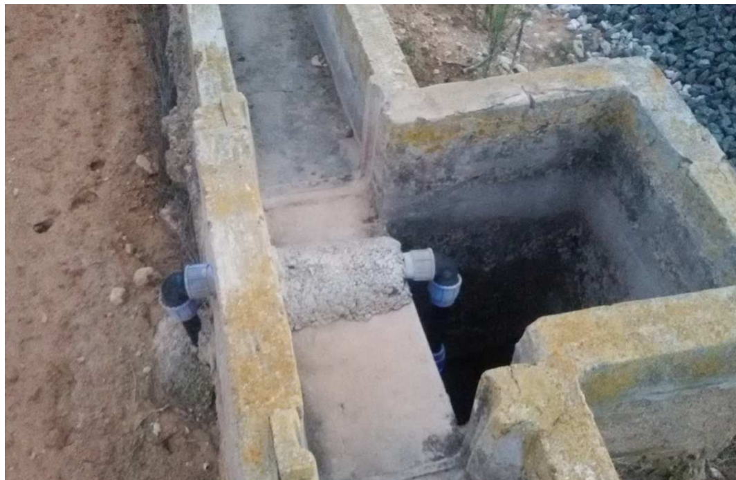
Foto 40: Arqueta en la margen izquierda a demoler
