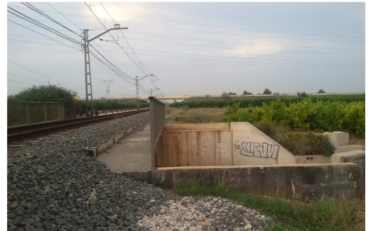
Foto 30: Puente Barranco Alcadet (Espacio nuevo tablero, vía duplicada)
