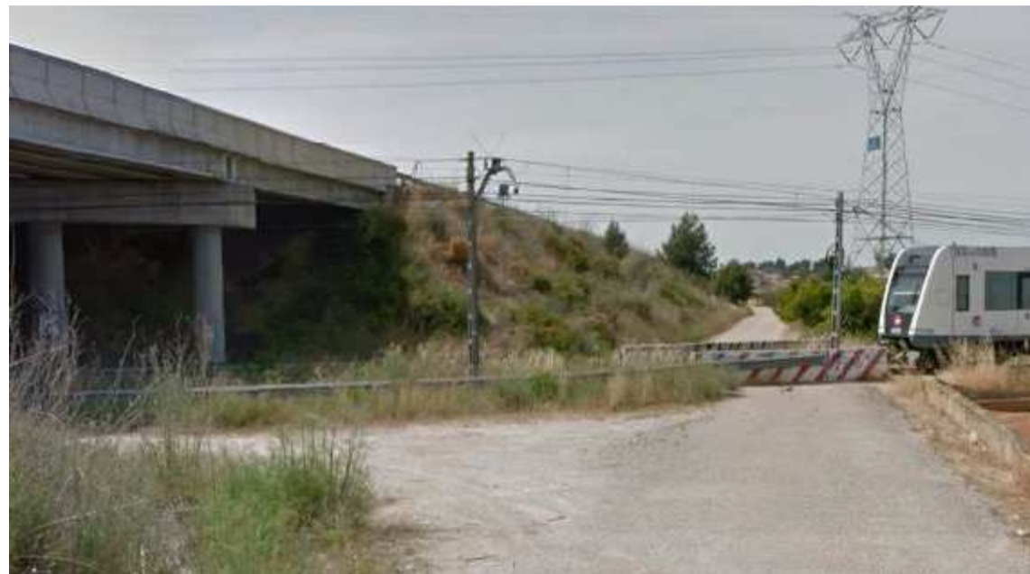
Foto 20: Antiguo paso a nivel camino Garrofera Guaita (P.K 7+127)
