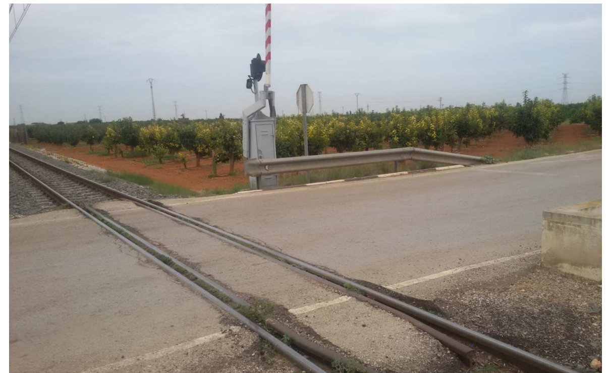
Foto 6: Apeadero de San Ramón (Paso a Nivel)
