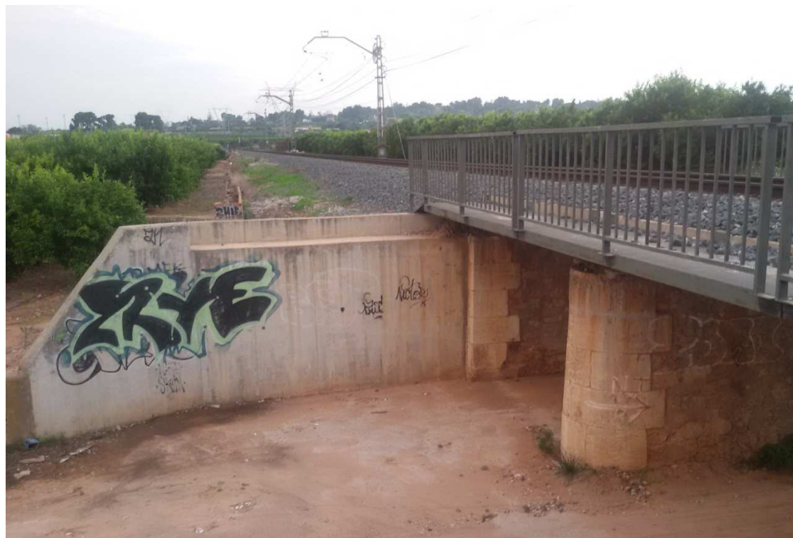
Foto 28: Puente Barranco Alcadet (Estribo y aleta Sur)
