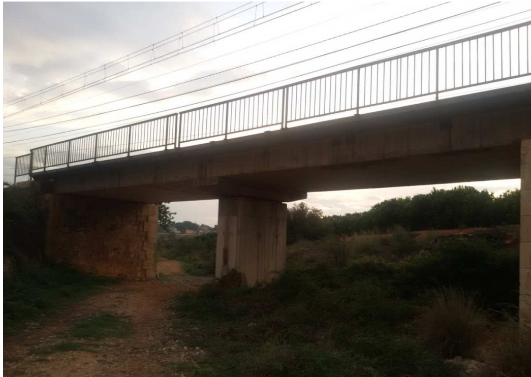
Foto 33: Puente sobre Barranco del Ciscar, PK 7+603 (Lado izquierdo)
