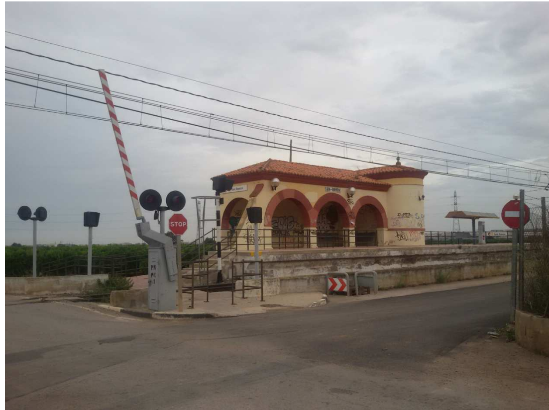
Foto 3: Apeadero de San Ramón (Desde lado derecho)
