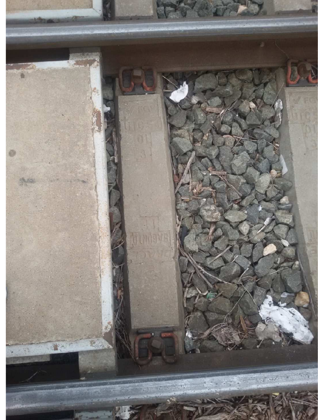
Foto 12: Detalle superestructura de vía (carril, traviesa, sujeción)
