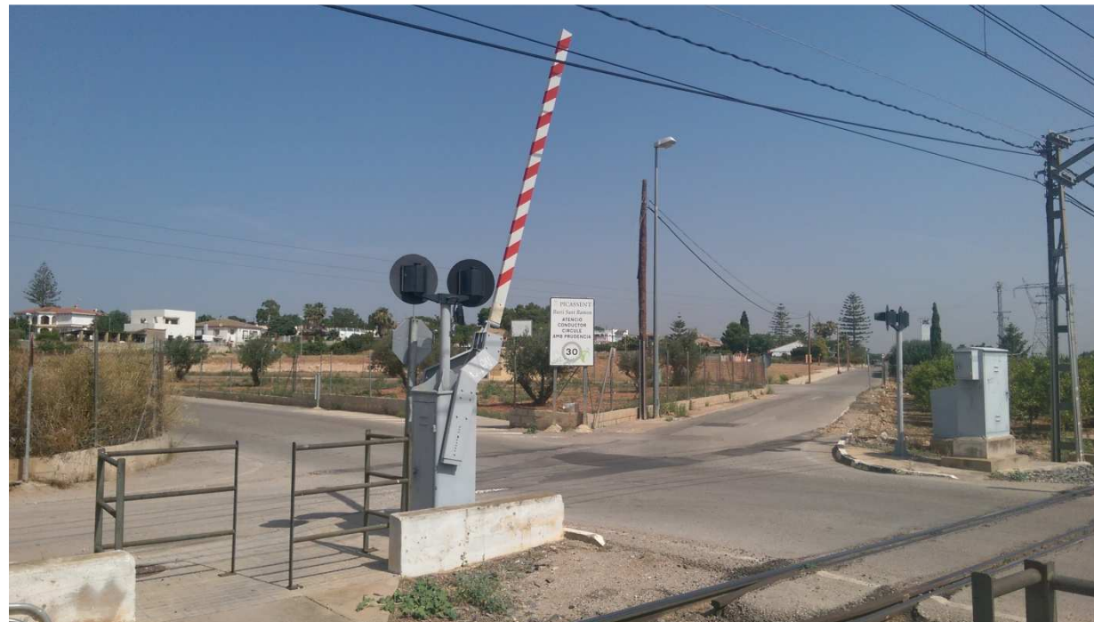
Foto 8: Apeadero de San Ramón (Paso a Nivel y Acceso Peatonal)
