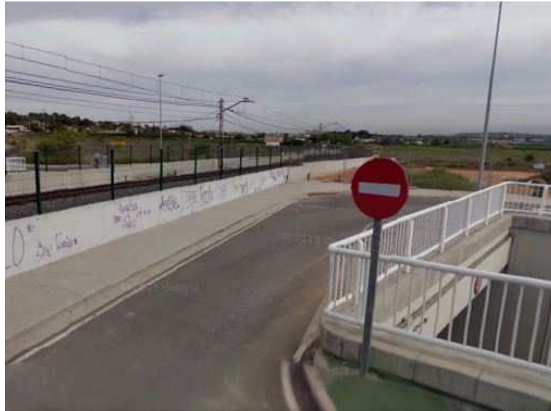
Foto 43: Paso inferior bajo el ferrocarril
