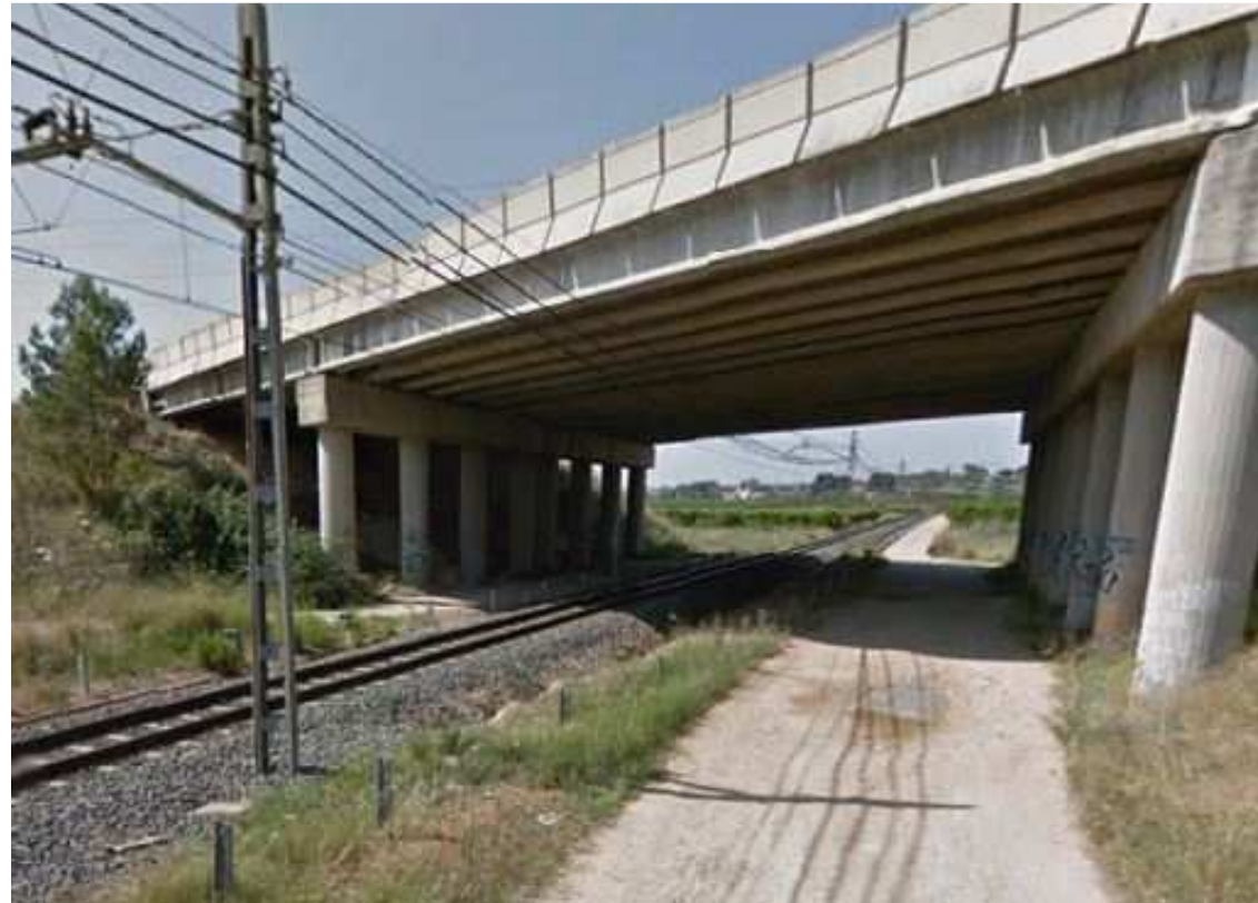
Foto 19: Paso superior sobre ferrocarril (Gálibo suficiente)
