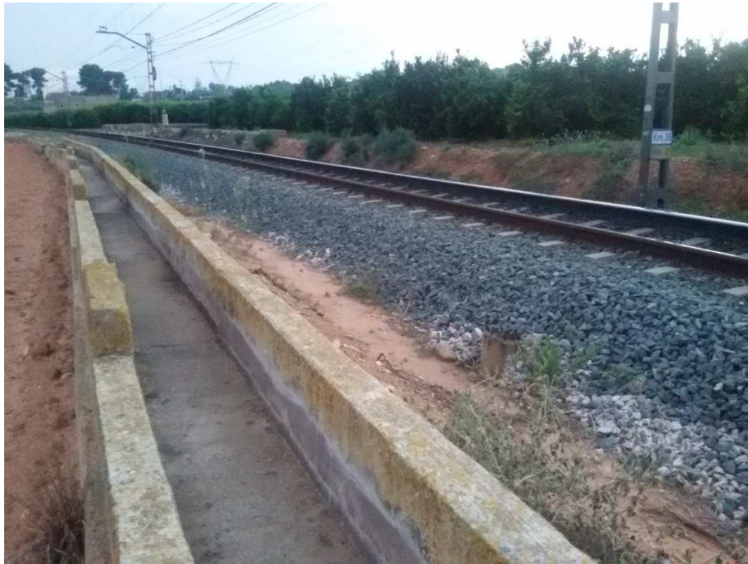
Foto 39: Acequia en la margen izquierda a demoler
