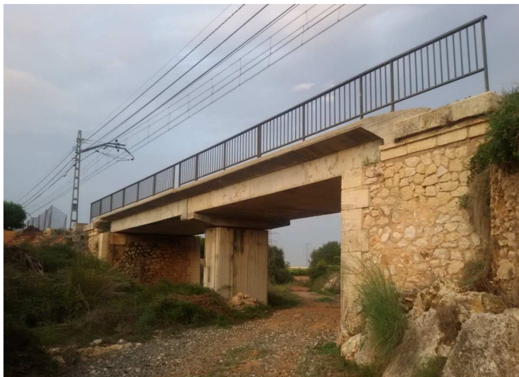
Foto 34: Puente sobre Barranco del Ciscar, PK 7+603 (Lado derecho)
