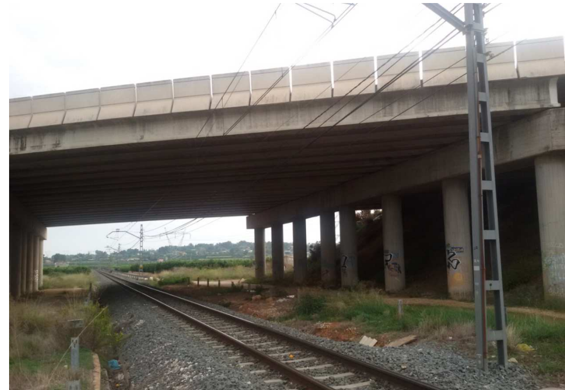
Foto 18: Paso superior sobre ferrocarril (Autovía A-7)
