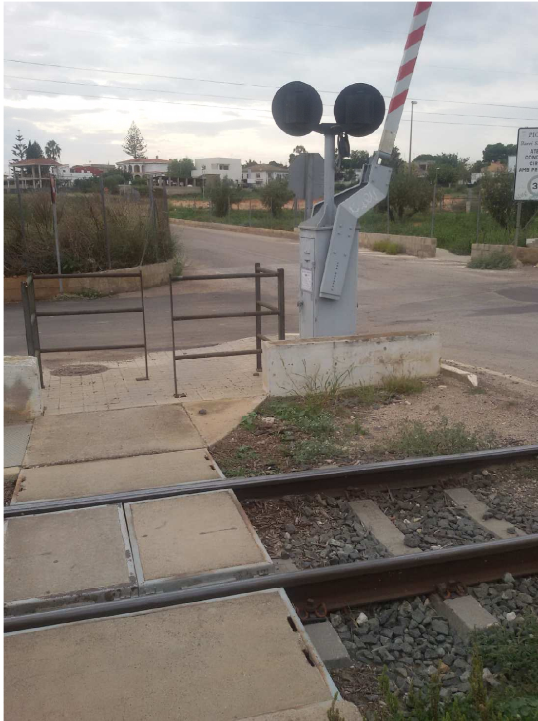
Foto 11: Apeadero de San Ramón (Paso Peatonal)
