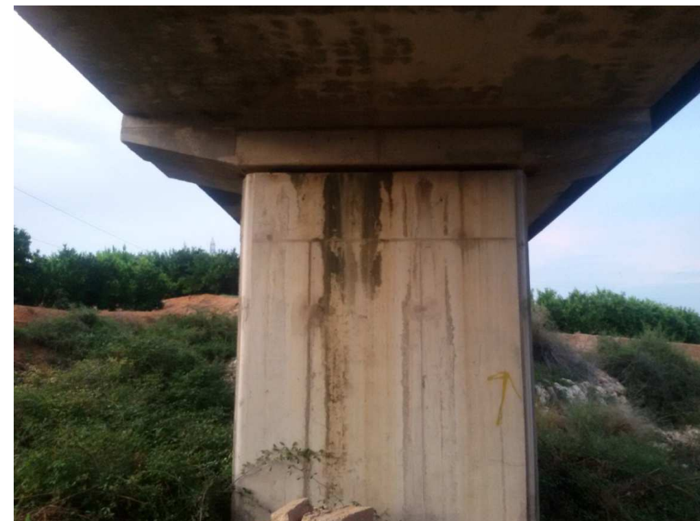
Foto 36: Puente Barranco Ciscar (Pilar central rectangular)
