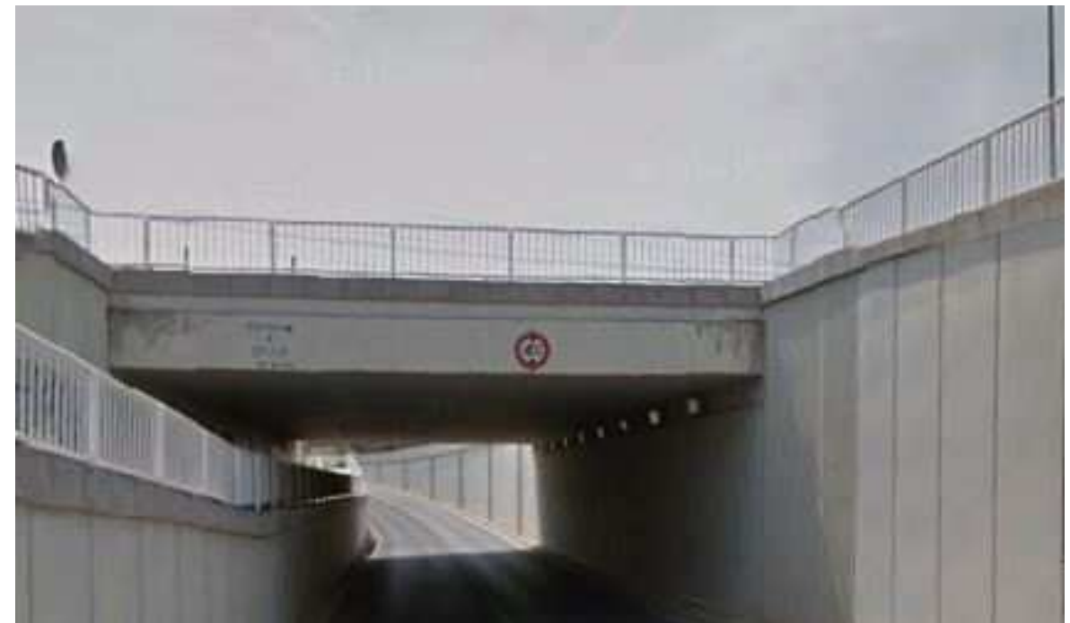
Foto 42: Paso inferior bajo el ferrocarril
