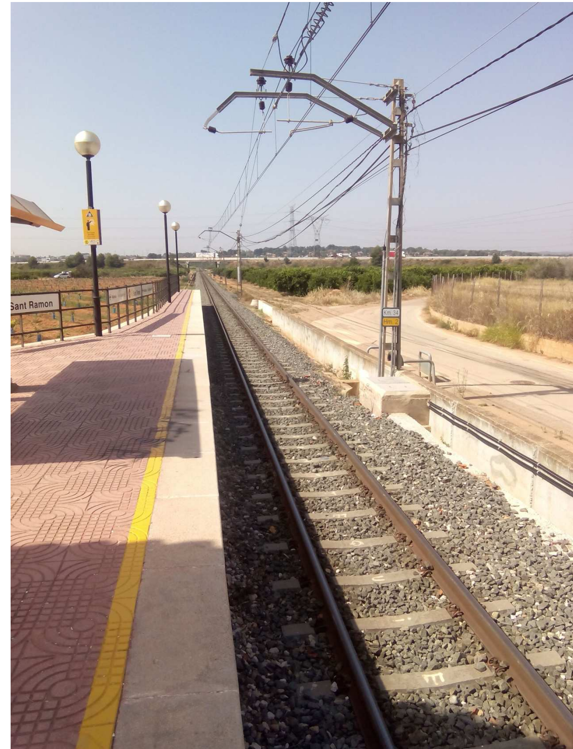
Foto 14: Apeadero de San Ramón Sur (Hacia Picassent)
