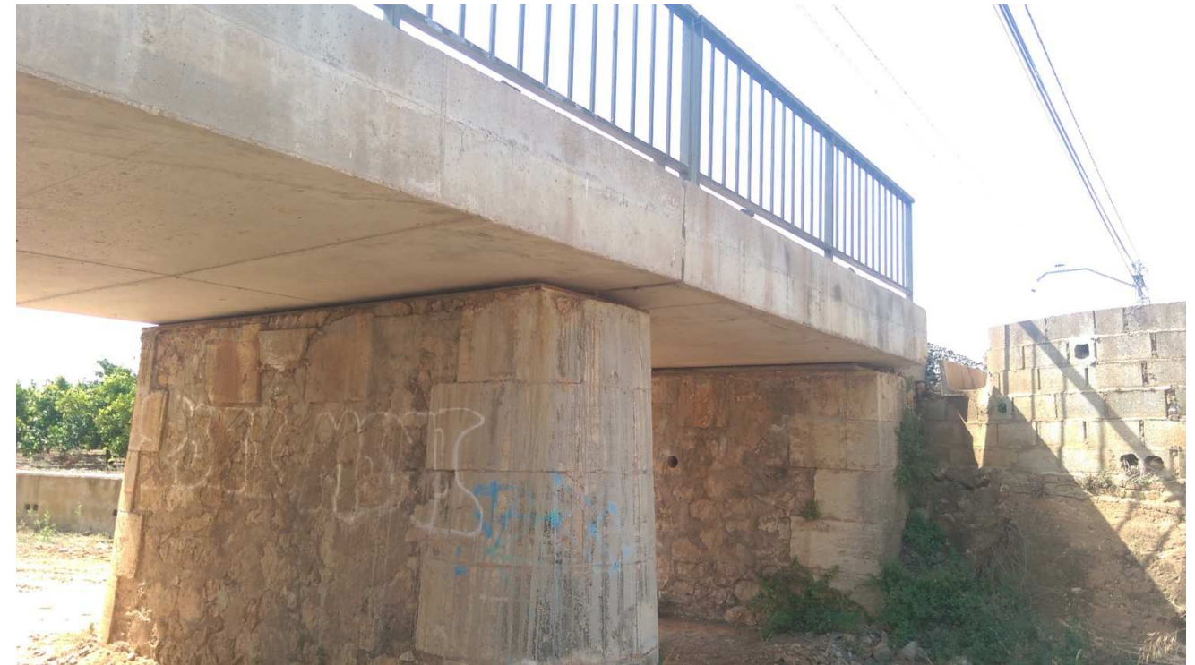
Foto 25: Puente sobre Barranco Alcadet (Pilas y estribos de sillería)
