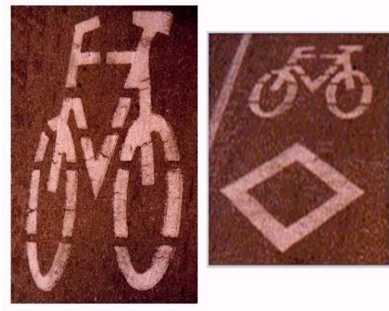
Figura 72: Señales anamórficas en la calzada
