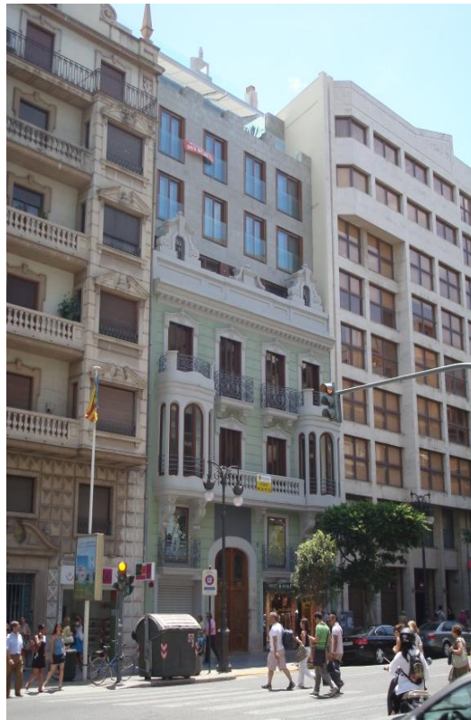
Antiga botiga de mobles i sala d'exposicions, edifici del mig. (Foto, González, Felip, 2008).
