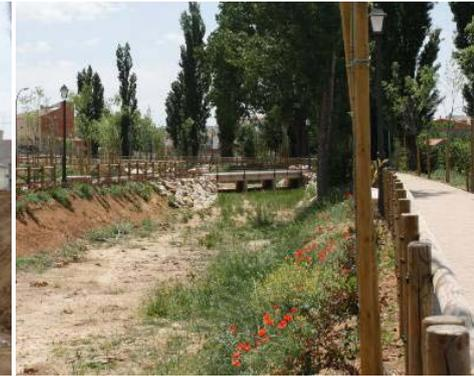
Obra de paso existente bajo el paseo de Castilla, reducido a un único tubo de unos 600 mm de diámetro, lo que constituía un grave estrangulamiento de la sección del cauce.
