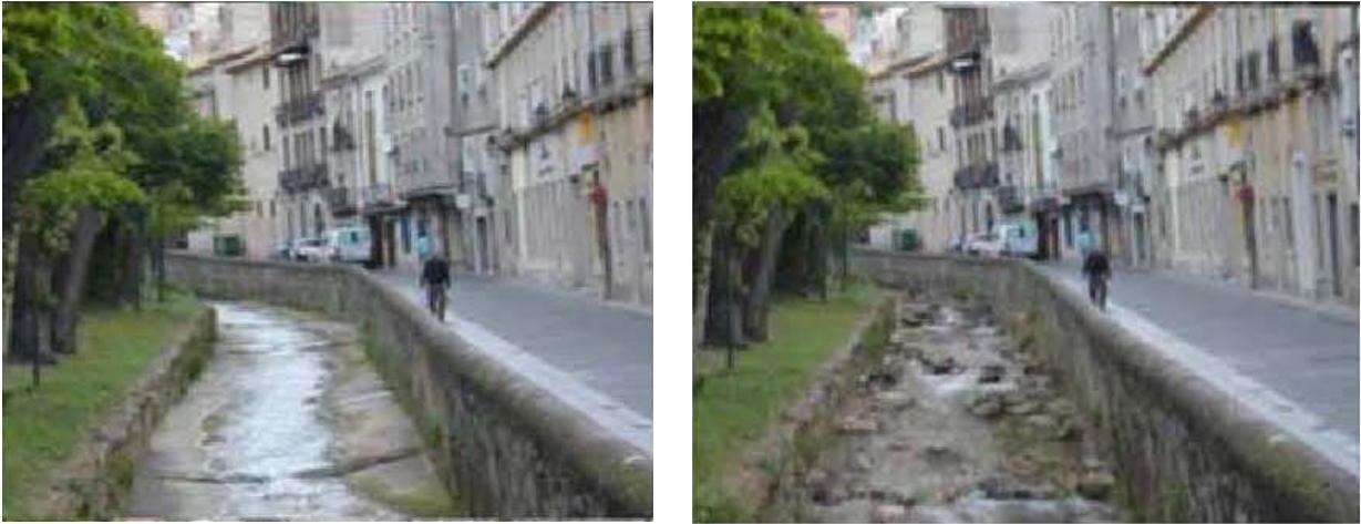
*Fig. 61. Vista del estado anterior a la actuación y tras la misma en la Calle de Los Tintes. Se crean resaltos naturales en el cauce que permite mantener una lámina de agua permitiendo crear un ecosistema fluvial y hacer presente el río en el entorno (aspecto sonoro).
