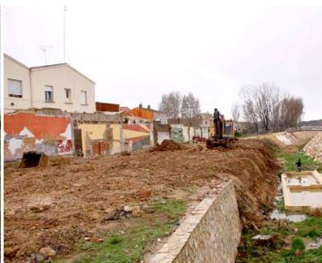
Demolición de la edificación existente. Ampliación de la sección del cauce.
