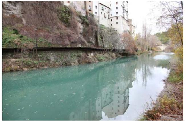
*Fig. 37. Tramo entarimado de la pasarela volada sobre el río Júcar con barandilla de fundición e iluminación.*
