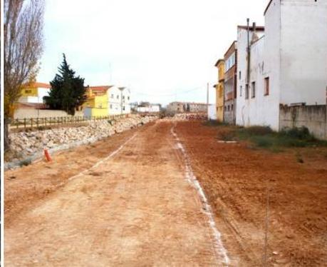
Creación de sendas en la ribera del arroyo. Relleno de tierras. Excavación para dotación de servicios y saneamiento.
