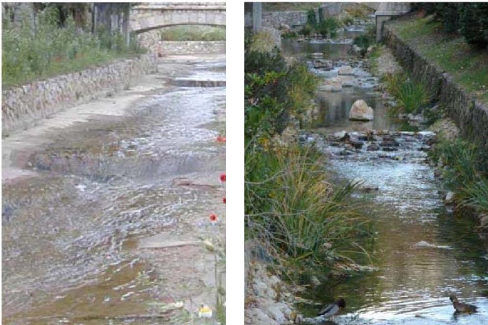
*Fig. 62. Vista del estado anterior a la actuación y tras la misma en otro punto del cauce del río. De nuevo se aprecia la creación de saltos de agua, así como una zona de vegetación en los márgenes del cauce.
