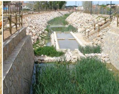
Ejecución de lavadero. Aumento sección hidráulica. Estabilización de taludes. Eliminación de estrechamientos.
