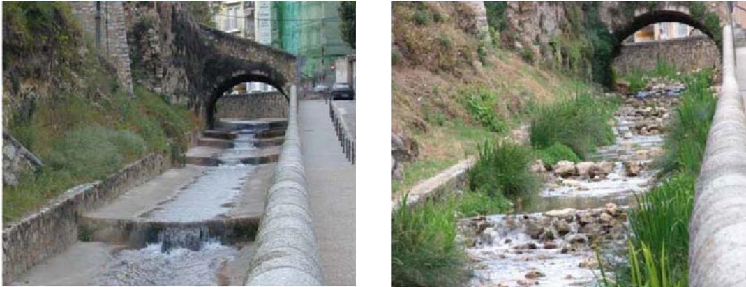
Fig. 63. Vista del estado anterior a la actuación y tras la misma en la calle de Los Tintes cerca del Parque del Huécar. Los saltos de hormigón se naturalizan, se mantiene una lámina de agua constante y se genera una franja de vegetación en los márgenes del cauce.
