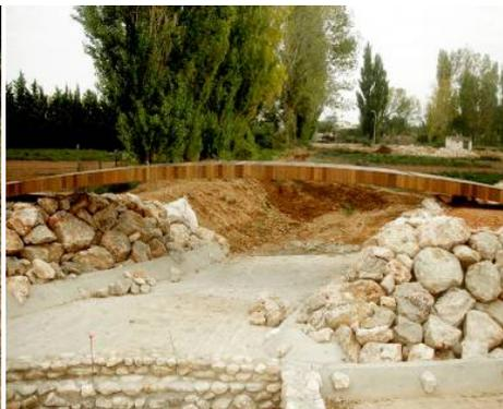
Aumento de sección hidráulica. Estabilización de taludes. Colocación de pasarela peatonal.
