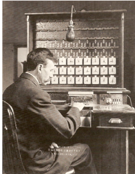
Máquina o sistema de tabulación de Herman Hollerith utilizado, entre otros, para realizar el censo de población de los EE.UU. en 1890 y ejemplo de computación electromecánica, c.a. 1908. ▲
