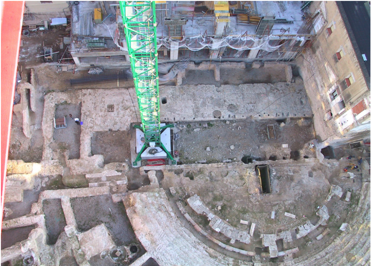
Fig. 39. Vista desde la grúa de la ima cavea , la orchestra , el hyposcaenium y la plataforma escénica; detrás se estaba construyendo el museo. (Archivo Arqueología. F. Escudero.)
