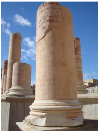
Fig. 75. Teatro romano de Italica : reconstrucción de columnas.
