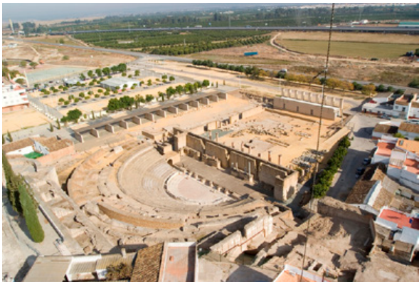
Fig. 8. Proceso de construcción de la anastylis actual. 1991. (A. Jiménez, F. Montero, P. Rodríguez).
