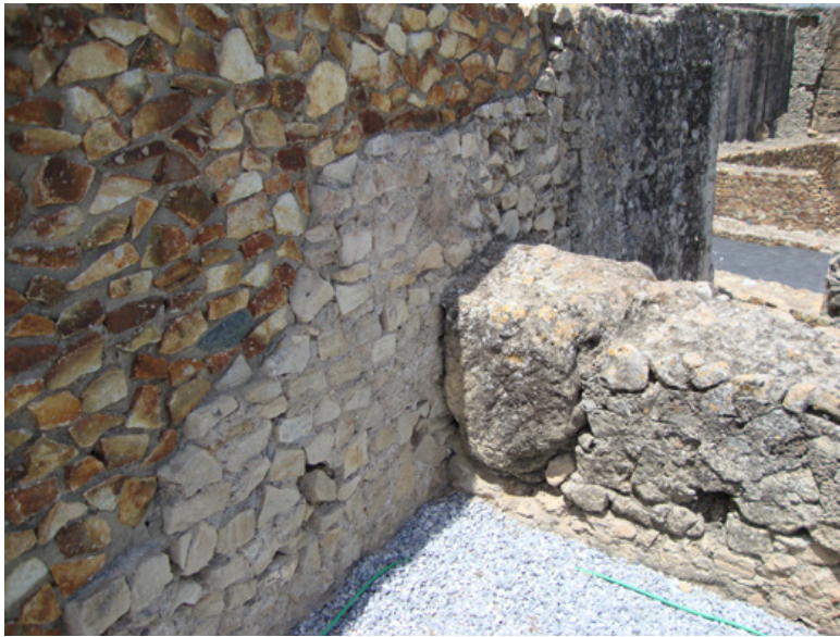
Fig. 80. Teatro de Segobriga : reconstrucción de muro.
