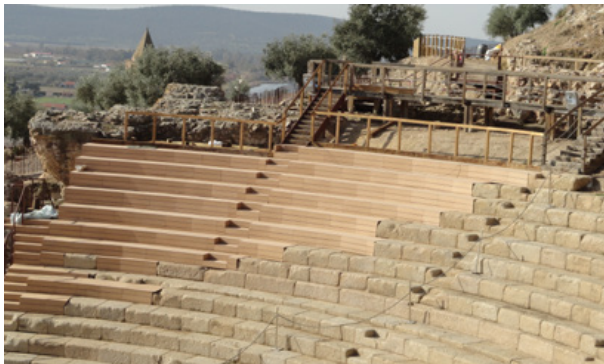
Figs. 62, 63. Teatro de Malaca : detalles de reconstrucción de gradas.
