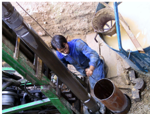
Fig. 62. Perforando para instalar uno de los drenajes. (Archivo Arqueología. F. Escudero)
