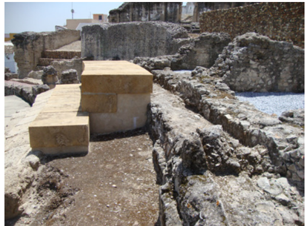
Figs. 51, 52, 53, 54. Teatro de Italica: cavea con la instalación de gradas y detalles restauración.
