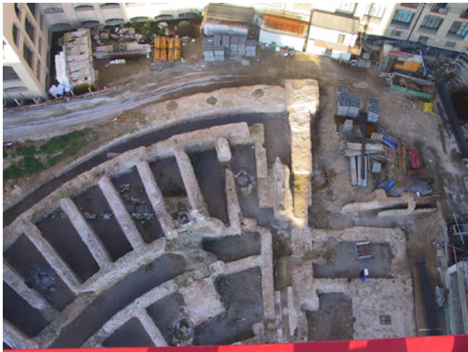
Fig. 16. Cámaras exteriores. De izquierda a derecha: cámara de paso, cámara ciega y cámara de escalera (Archivo Arqueología. G. Bullón)
