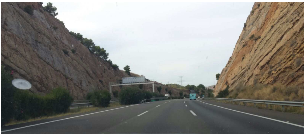
Figura 3. Grandes desmontes rocosos en la vía de gran capacidad AP-7, Les Valls, Valencia (carril derecho, sentido Norte)
