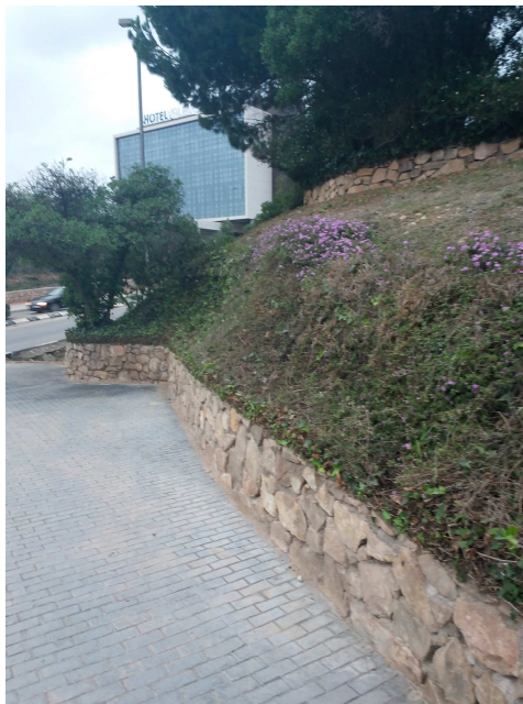
Figura 10. Muro de mampostería
