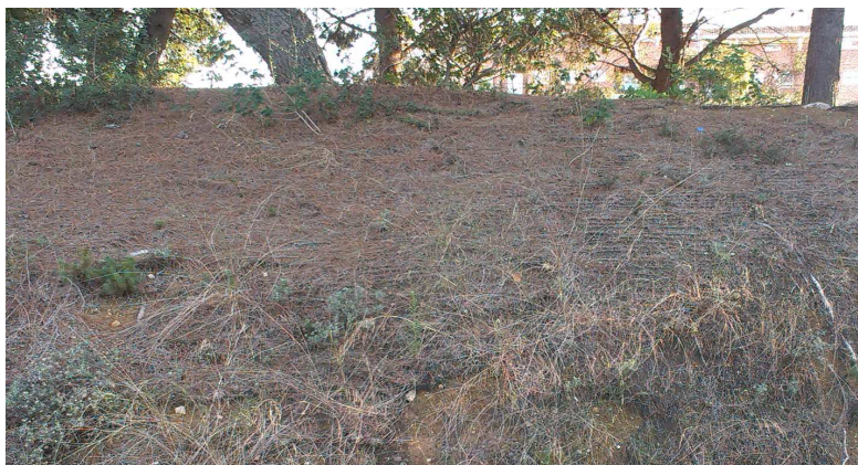
Figura 14. Manta orgánica en talud de carretera, Paterna (Valencia)
