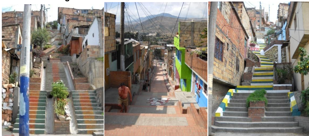
Figura 35. Obras de accesibilidad Zona Ladrilleras.
