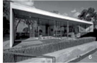
Fachada de la Case Study House 9
