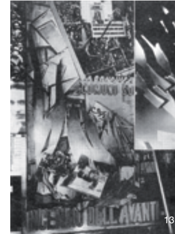
Casa del Fascio Como, 1932.
