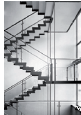
Ayuntamiento de Rødovre Detalle de la escalera.
