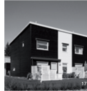
Casa prefabricada Boklok , 1996.
