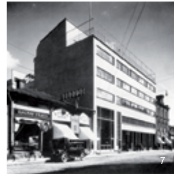
Edificio del periódico “ Turun Sannomat ” Turku, Finlandia. 1928.
