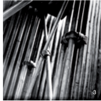
Detalle de la fachada Pabellón Finlandés de la exposición de París, 1937.
