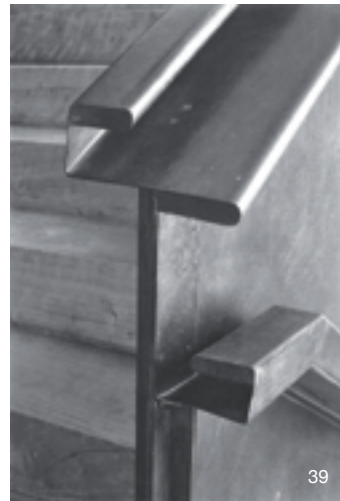
Mobiliario y detalle de la barandilla de chapa de cobre doblada Gobierno civil de Tarragona.. Alejandro de la Sota, 1957-1961.
