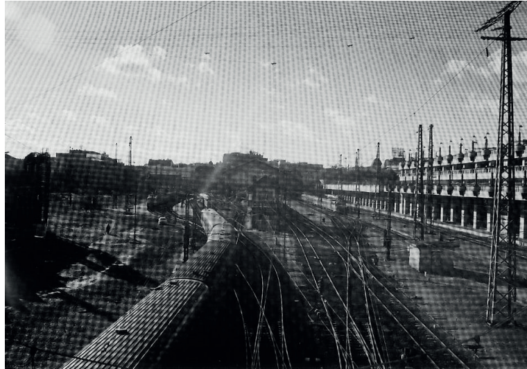
Parte trasera de la estación de tren.
