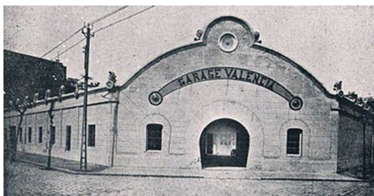
Figura 11. Fachada del Garaje Valencia, situado en el chaflán entre Grabador Esteve y Cirilo Amorós.
