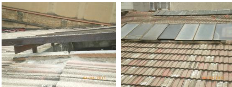
Figura 27. Detalle de Claraboyas o Linternas de Ventilación/Iluminación. Garaje Nogués-Parking Supremo, año 2011.
