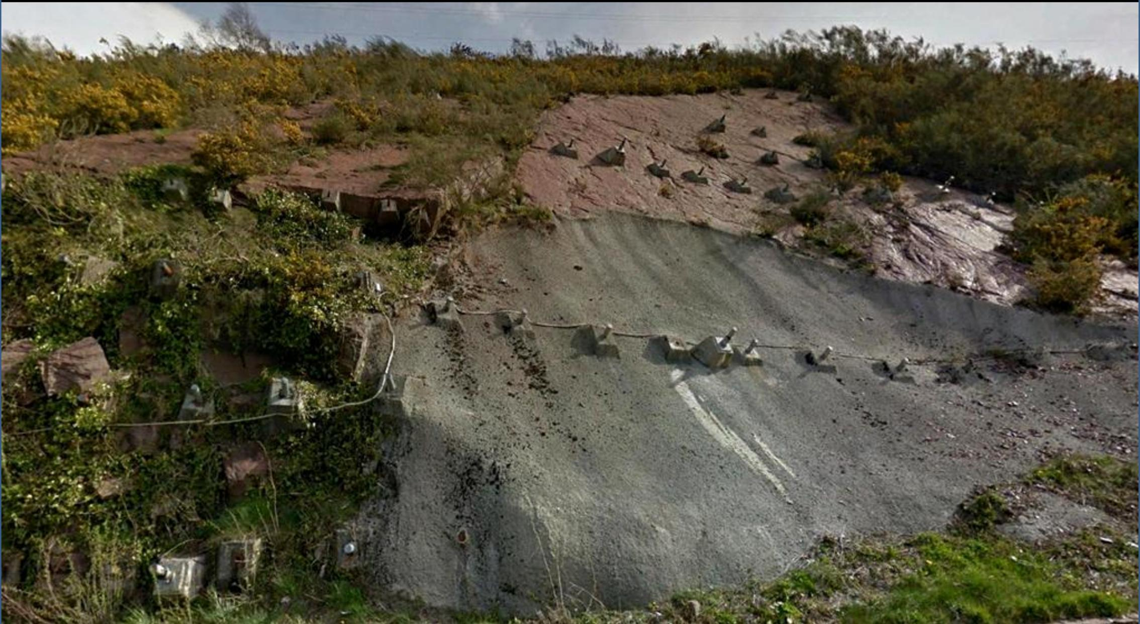
Autovía de Leizarán. Bulonado y gunitado en las arcillas y areniscas del Buntsandstein, Triásico Inf. NE de Eldua, Guipúzcoa. NE Hoja de Tolosa.
