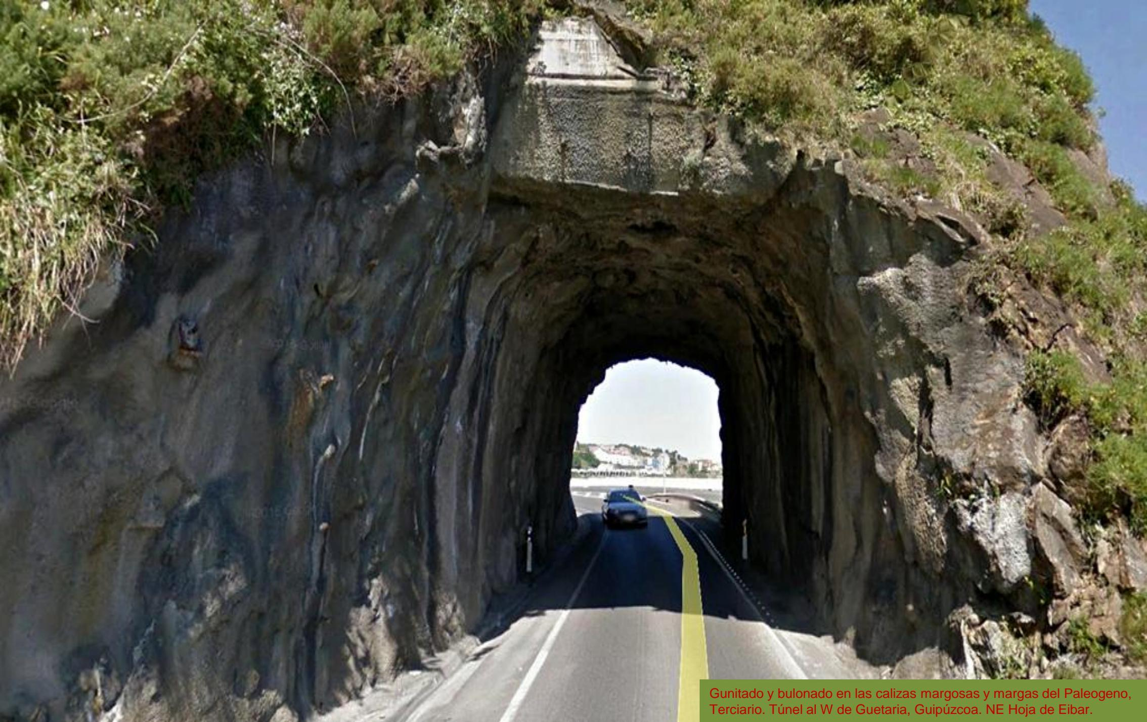
Gunitado y bulonado en las calizas margosas y margas del Paleogeno, Terciario. Túnel al W de Guetaria, Guipúzcoa. NE Hoja de Eibar.
