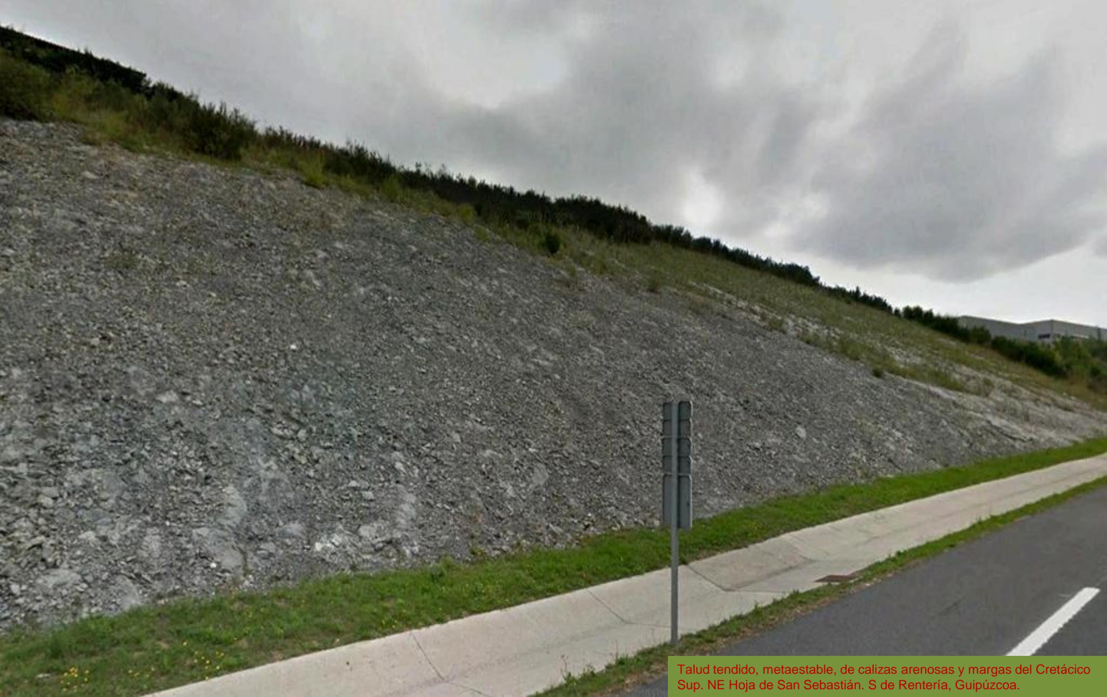
Talud tendido, metaestable, de calizas arenosas y margas del Cretácico Sup. NE Hoja de San Sebastián. S de Rentería, Guipúzcoa.
