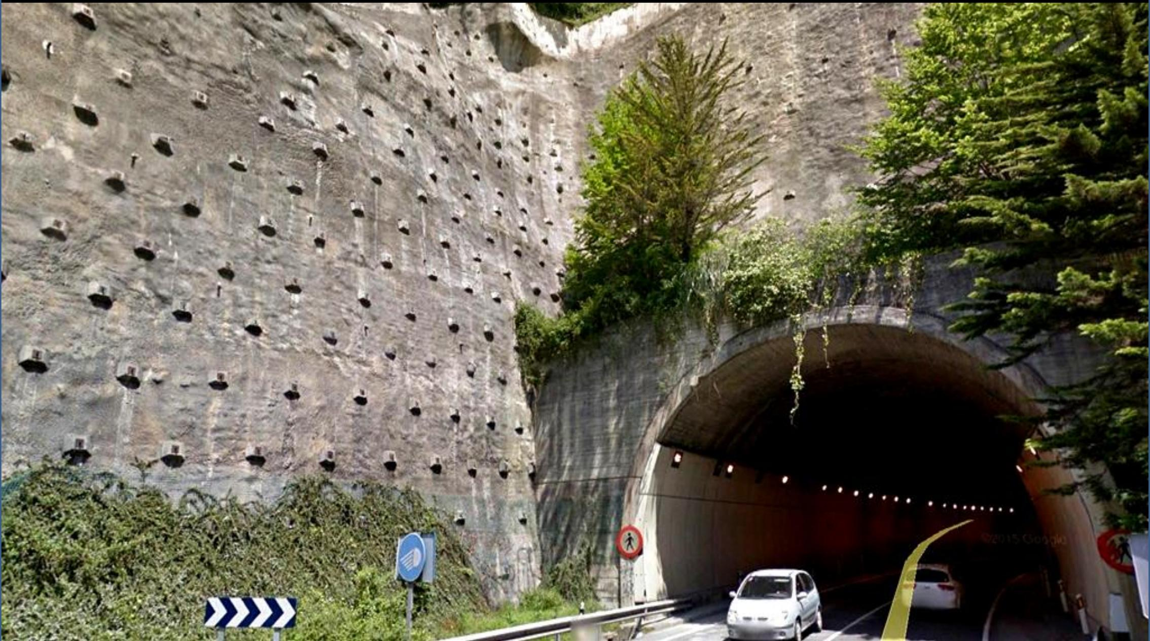
Gunitado y bulonado sistemático a la entrada de túnel. Calizas del Senoniense, Cretácico Sup. W de Eibar, Guipúzcoa. SW Hoja.
