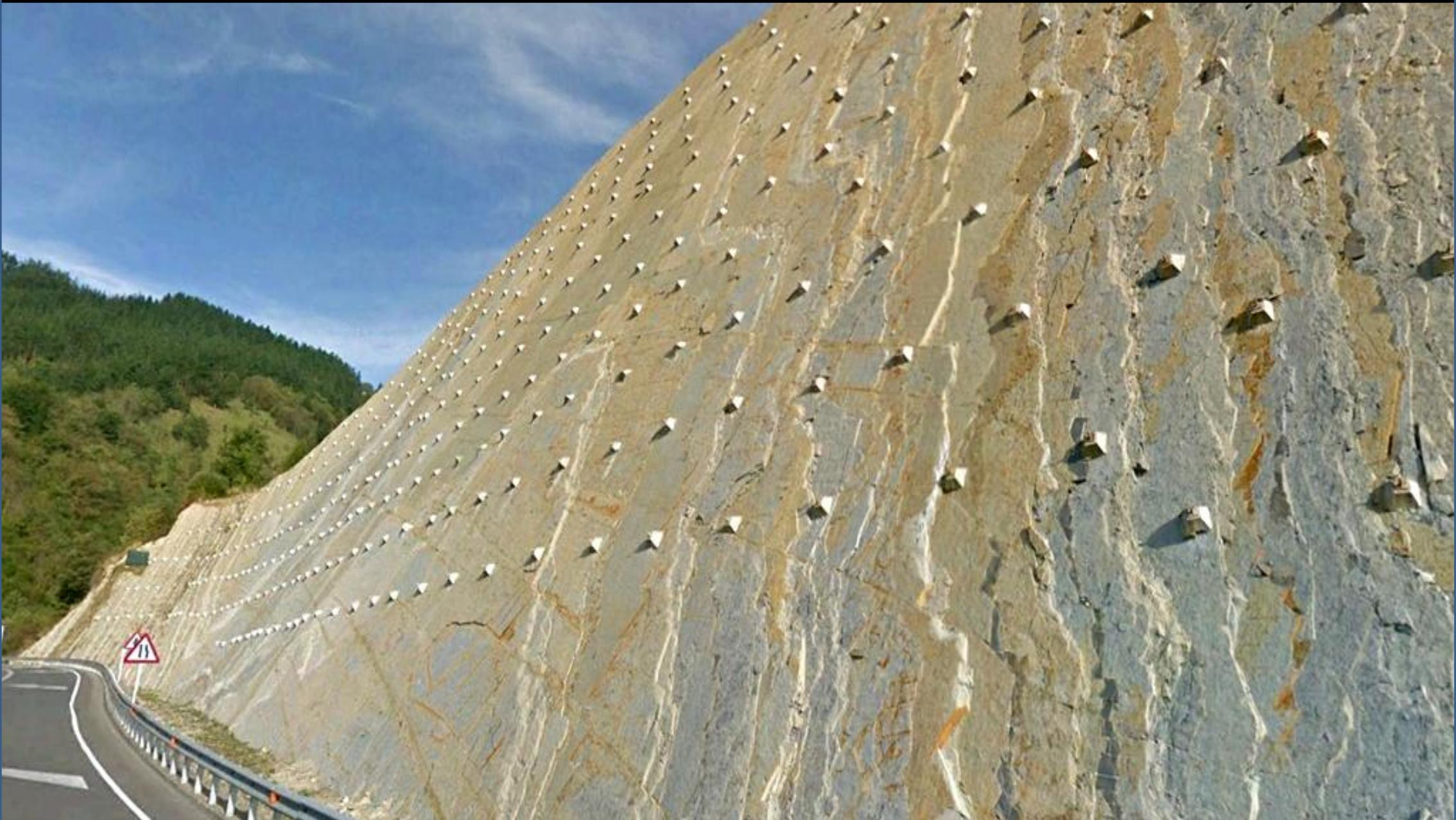
Junto anterior: Bulonado sistemático en la serie carbonatada, muy tectonizada, del Senoniense, Cretácico Sup. W de Eibar, Guipúzcoa. SW Hoja.
