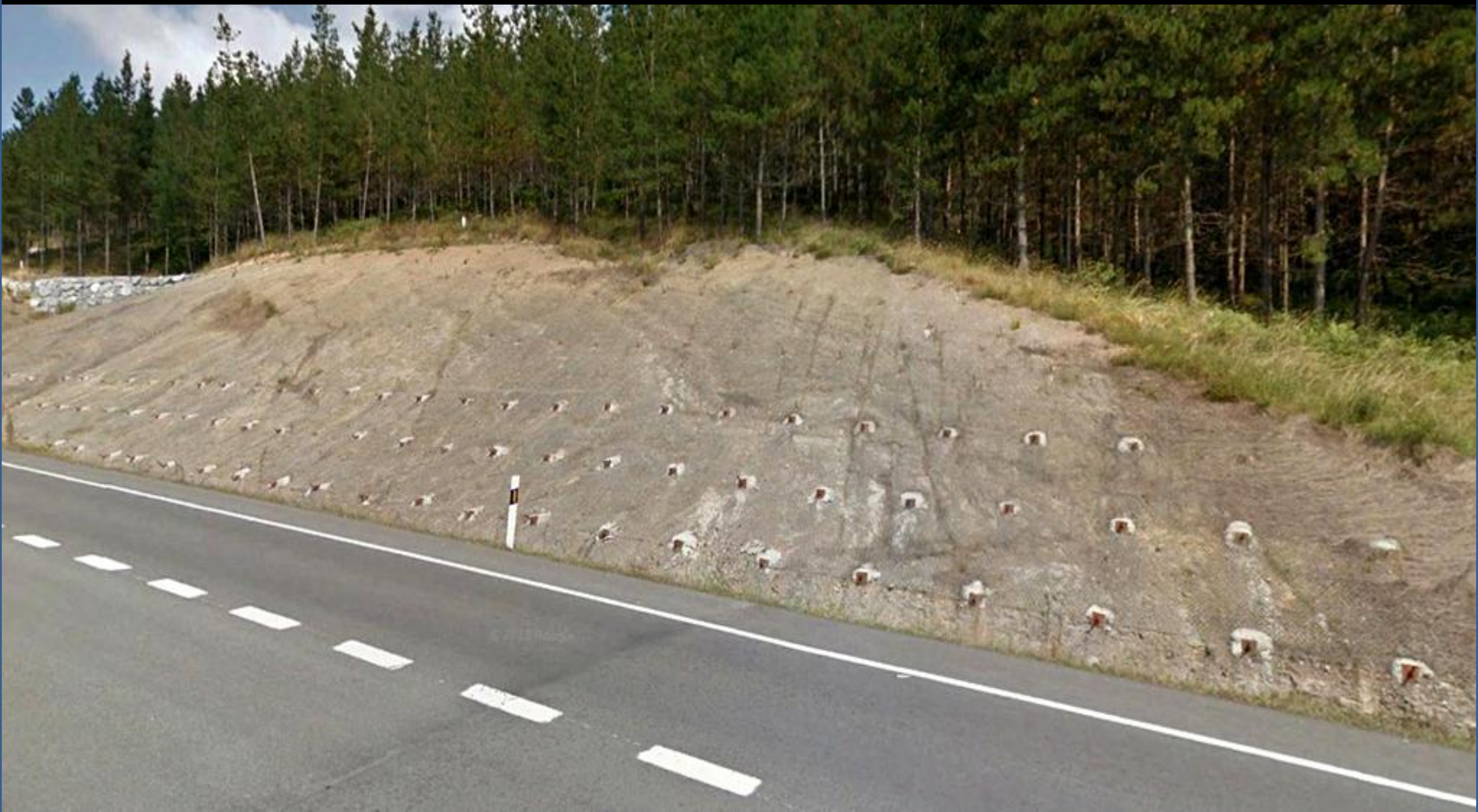
Talud metaestabilizado con bulones y mallazo, en las rocas del Coniaciense, Cretácico Sup. NNE de Inoso, E de Lezama, Álava. SE Hoja de Landaco.
