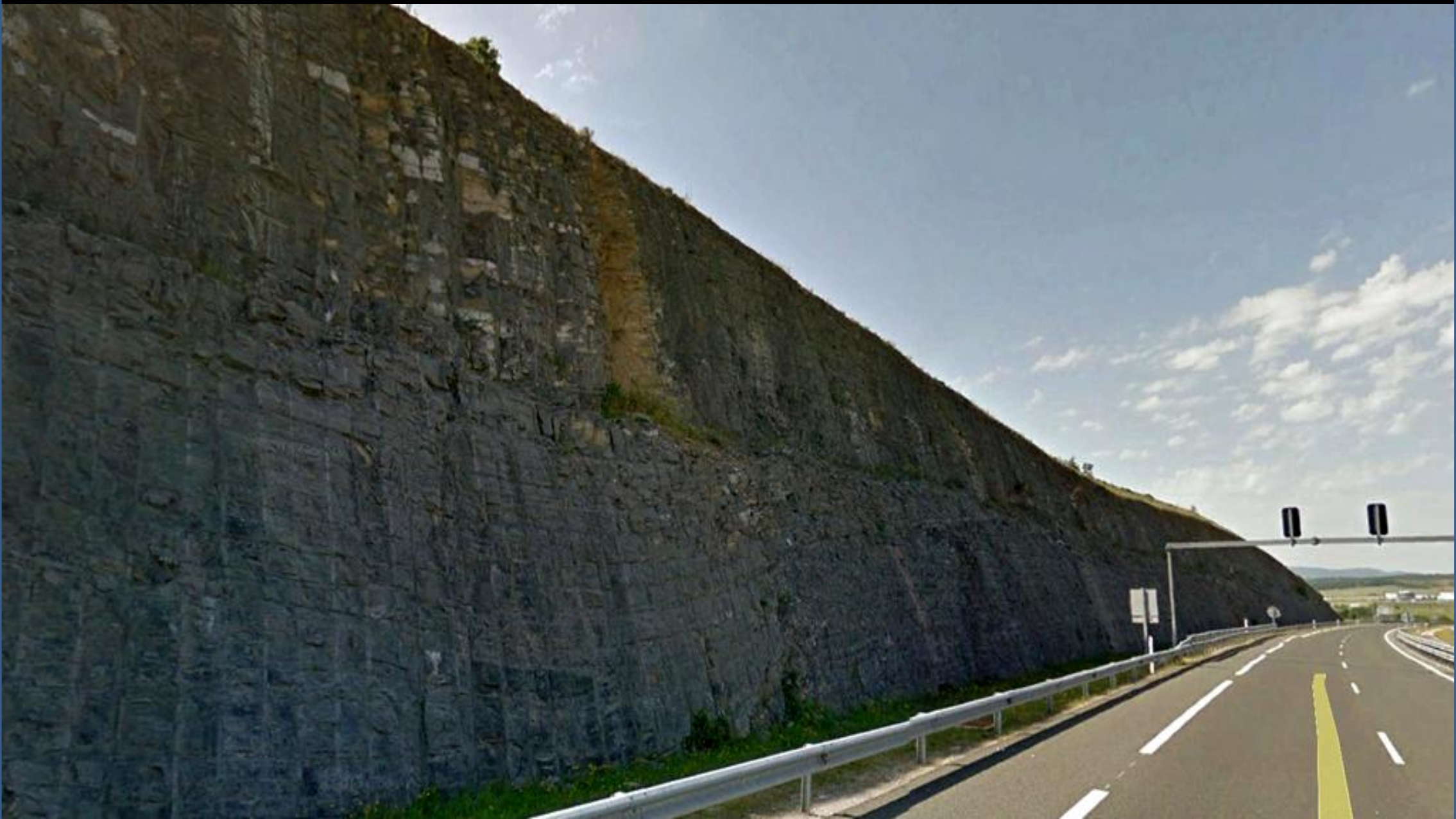
Alternancia de calizas y margas del Cenomaniense-Santoniense, Cretácico Sup. Estribo E en la salida de bocas S del Tunel de Luko, Álava. Centro NE Hoja de Vitoria.
