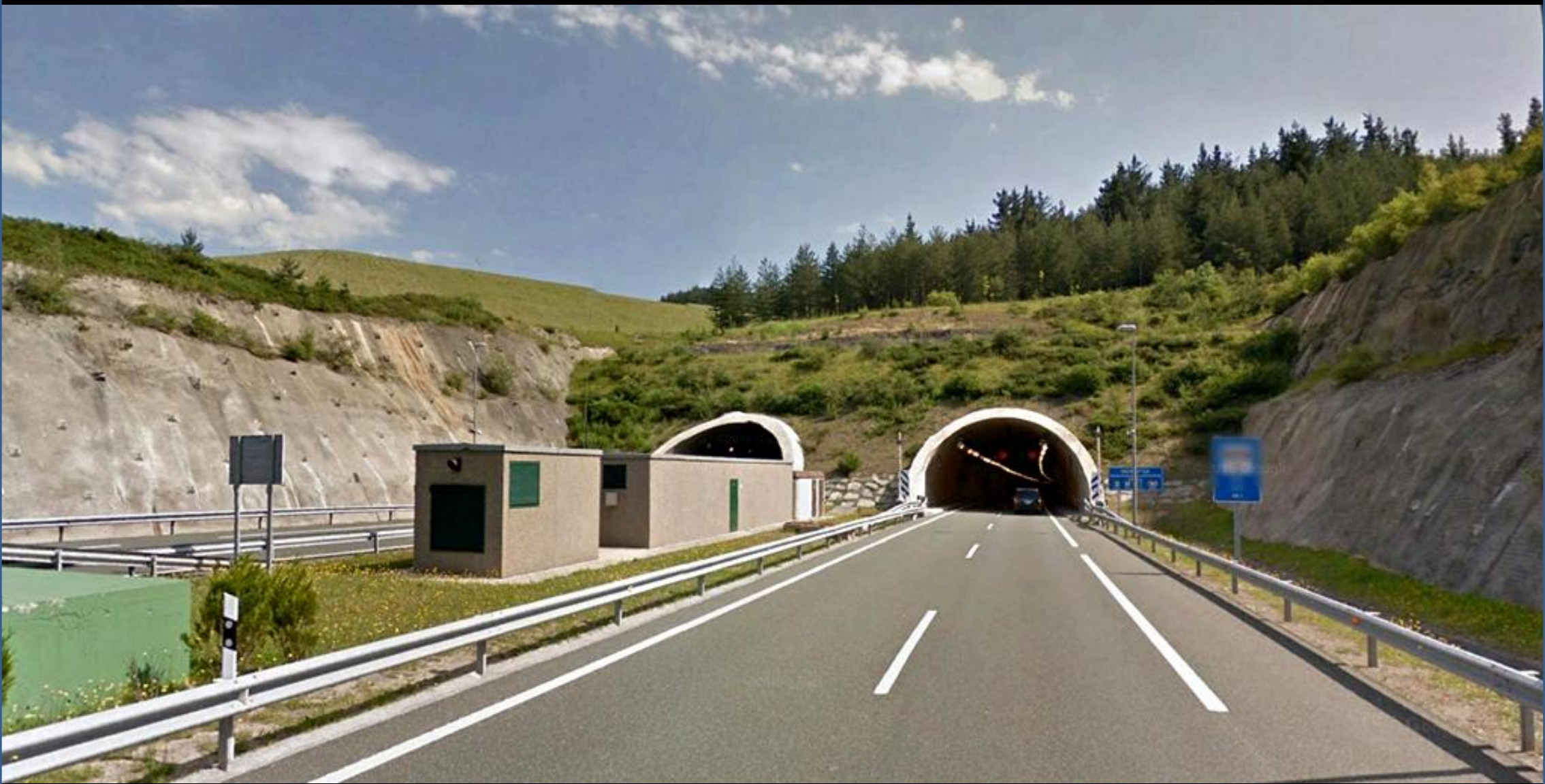
Túneles, Isuskitza. Álava- Guipuzcoa, E de Larrabea. Zona de areniscas, limolitas y niveles de arcillas arenosas del Albiense, Cretácico Inf. Gunitado y con bulones.
