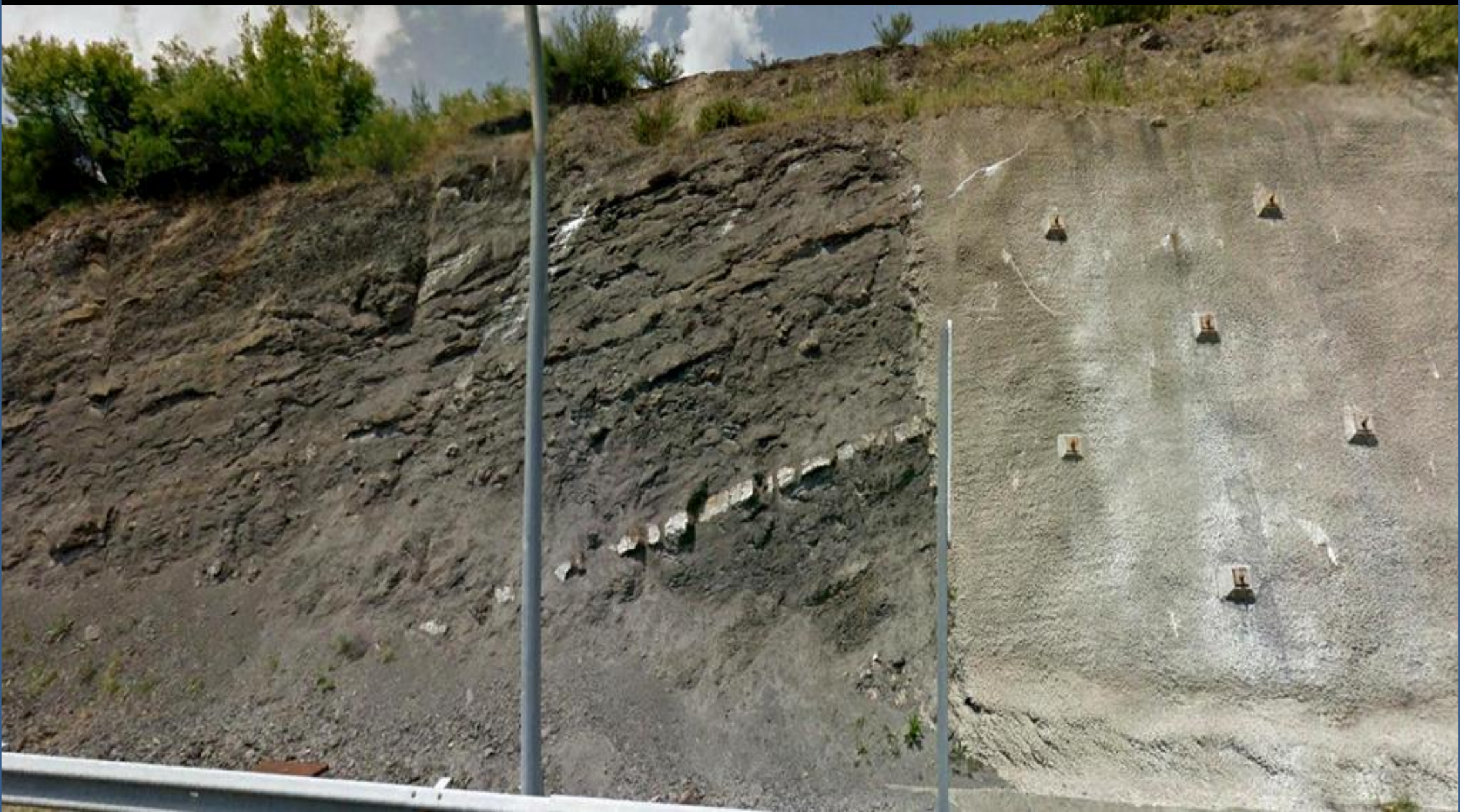
Detalle en zona anterior: Salida túnel, Isuskitza. Álava- Guipuzcoa, E de Larrabea. Zona de areniscas, limolitas y niveles de arcillas arenosas del Albiense, Cretácico Inf. Gunitado y con bulones.
