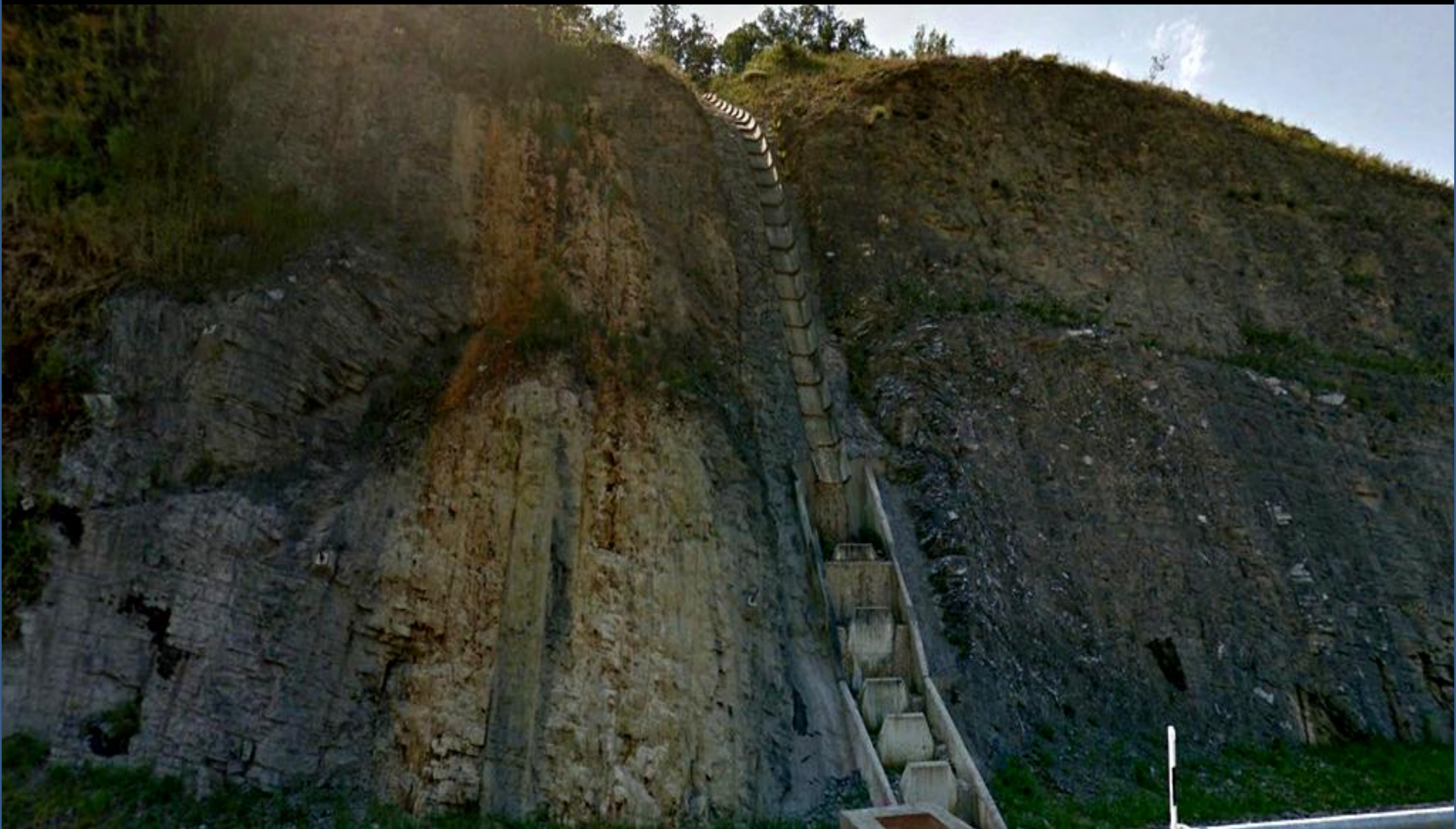
En la zona de la anterior: Para escorrentía superficial. Alternancia de calizas y margas del Cenomaniense-Santonense, Cretácico Sup. Estribo E en la salida de bocas S del Tunnel de Luko, Álava. Centro NE Hoja de Vitoria.
