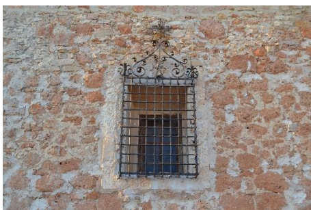
Ilustración 14. Reja que protege la ventana del Camarín.
