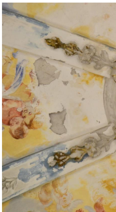
Ilustración 40. Morteros con abolsamientos abiertos.
