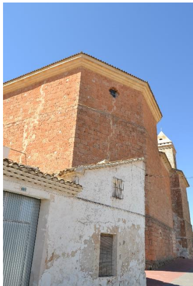
Ilustración 7. Muros de la cúpula mayor.
