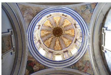
Ilustración 6. Vista de la cúpula y pechinas de la Capilla del Rosario.
