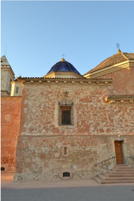
Ilustración 12. Muro exterior del Camarín.
