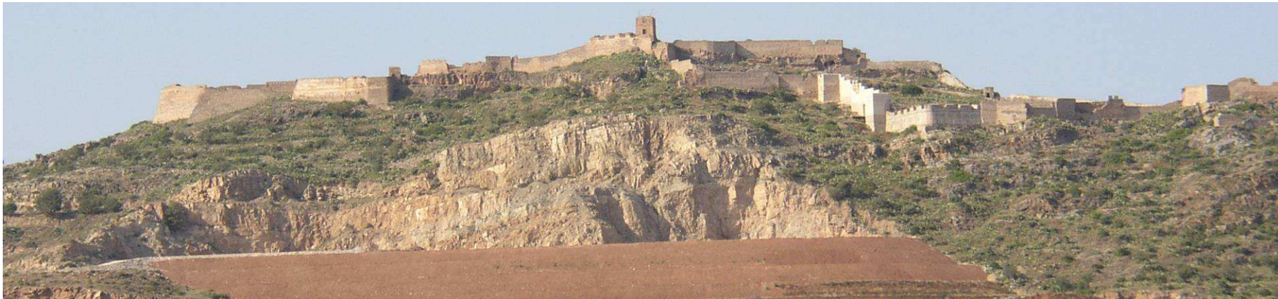
Vista de l procés de reble del tallat de la pedrera del Castell. Autor: Pelayoz. Font:wikipedia
