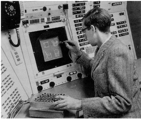
Fig. 25 Sketchpad y lápiz óptico, 1963.
