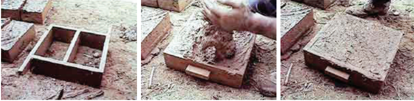
Figuras 48, 49 y 50. Fabricación del ladrillo de adobe. El adobe es la mezcla en húmedo de arcilla, arena y paja. Sin embargo las proporciones de cada componente son importantes para obtener adobes adecuados. Existen varias técnicas recomendadas para verificar que la tierra utilizada para construir adobes es la adecuada. Podemos encontrar la información necesaria para su correcta formulación y la descripción de algunas técnicas en: leonardo.bauchwitz.com.ar/?p=6 ([Consulta: 2 Noviembre 2008]).
