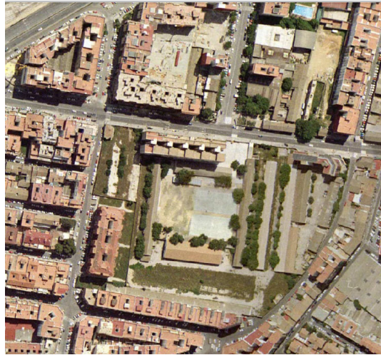
Figura 209. Parque Central de Ingenieros de Valencia. http://www.valenciaparquecentral.es/
