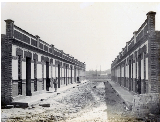
Figura 88. El barrio durante su construcción (Obtenido del Archivo Municipal) - © VTiM
