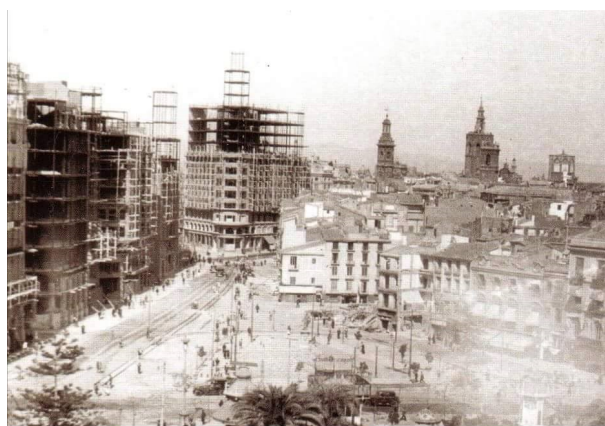
Figura 73. Inicios de los trabajos de demoliciones en la Bajada de San Francisco
