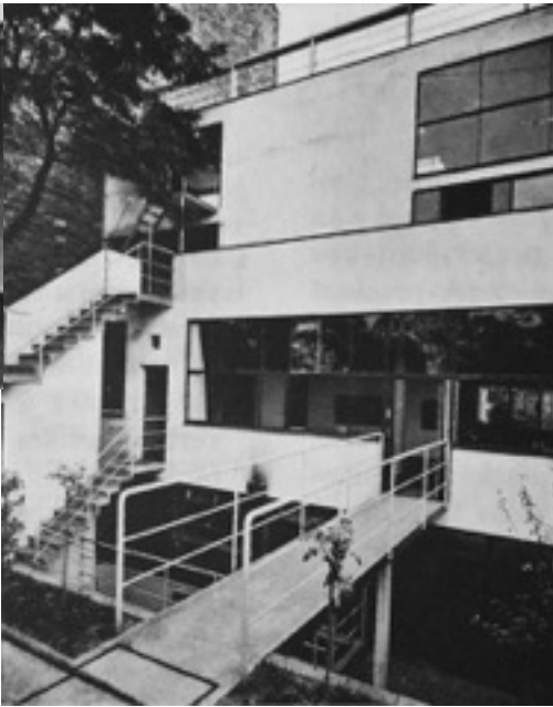
VISTA DE LA FACHADA TRASERA
