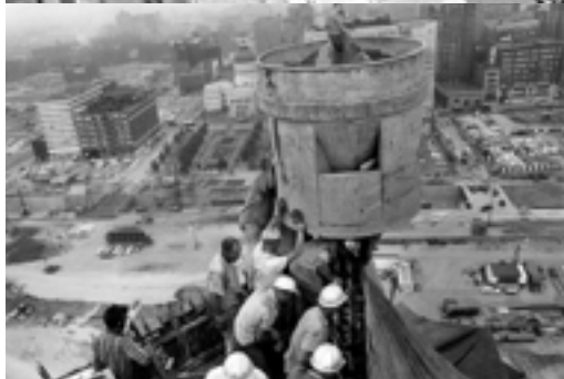
HORMIGONADO DE UNA SECCIÓN http://farm3.static.flickr.com/2514/3984362834_f9ba5560d2.jpg
