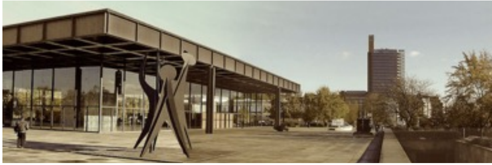
PANORÁMICA DE LA NEUE NATIONALGALERIE
