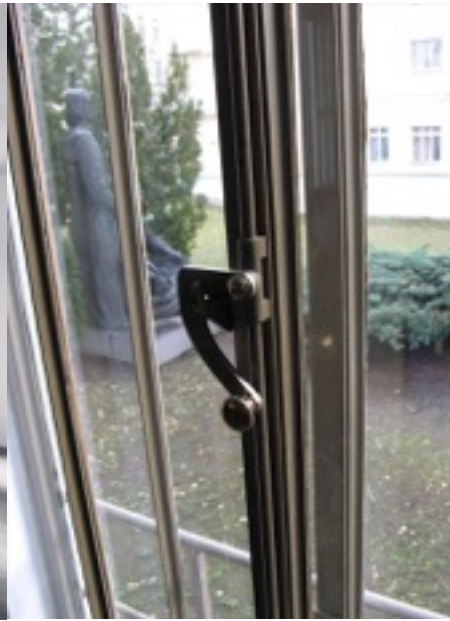
DETALLE DE LAS VENTANAS
