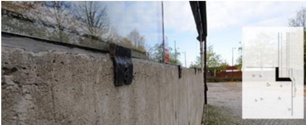
SIGURD LEWERENTZ. KIOSKO DE LAS FLORES EN EL CEMENTERIO DE MALMO, SUECIA 1969.
