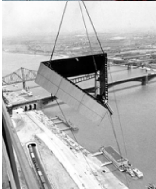
IMÁGENES DEL MONTAJE DE LAS SECCIONES DEL ARCO,
