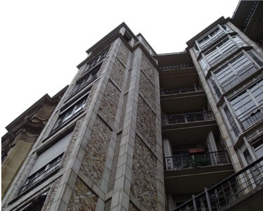
AUGUSTE PERRET. CASA DE LA RUE FRANKLIN Nº 25 BIS (1902-03) EN PARÍS Fotografías propias
