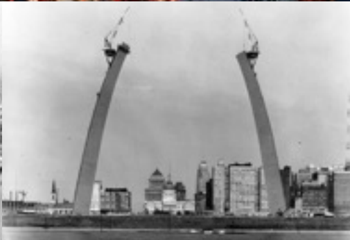
IMÁGENES DEL MONTAJE DE LAS SECCIONES DEL ARCO,
