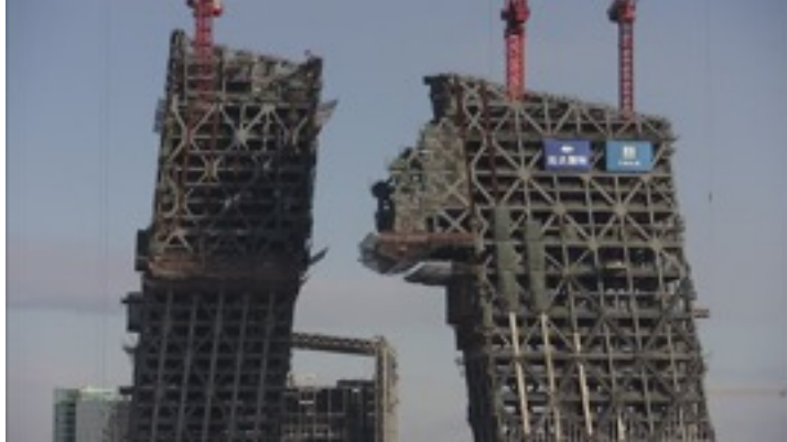
CCTV. Vista de la ubicua diagonalización de la estructura durante el proceso de la construcción. http://footage.framepool.com/shotimg/qf/138558005-cctv-headquarters-ole-scheeren-rem-koolhaas-obra-bruta.jpg
