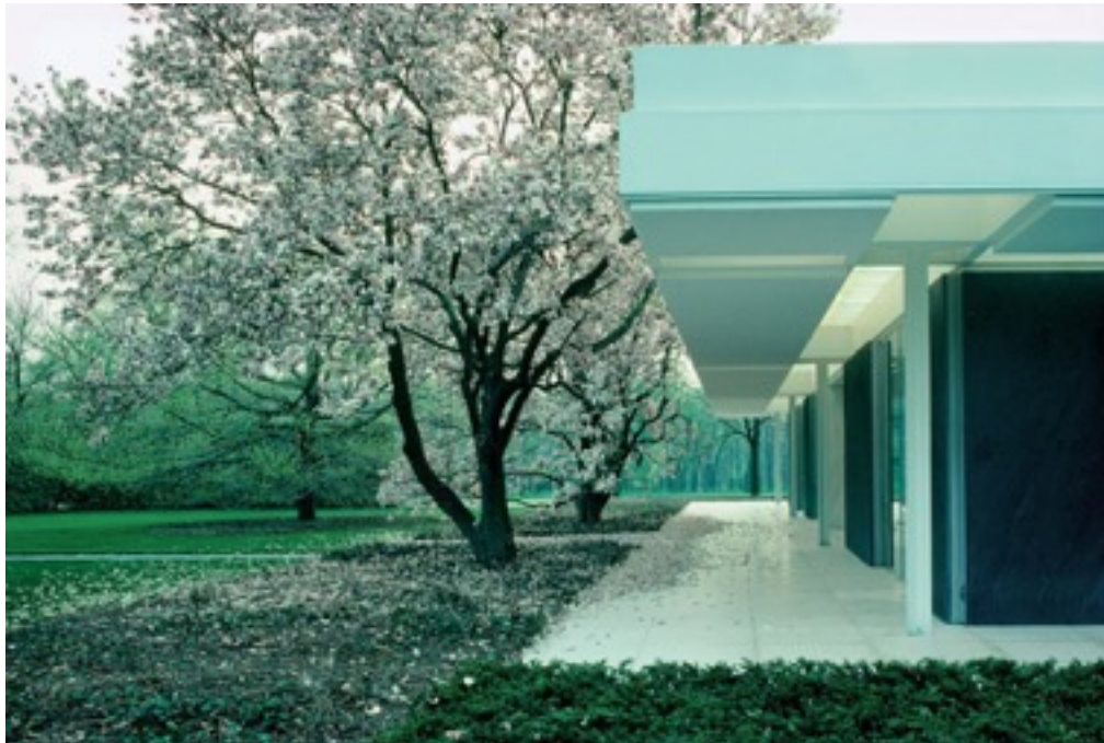
CASA MILLER. ZONA EXTERIOR CUBIERTA DEL LADO SUR
