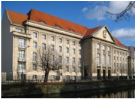
MINISTERIO FEDERAL DE DEFENSA (BENDLERBLOCK).
