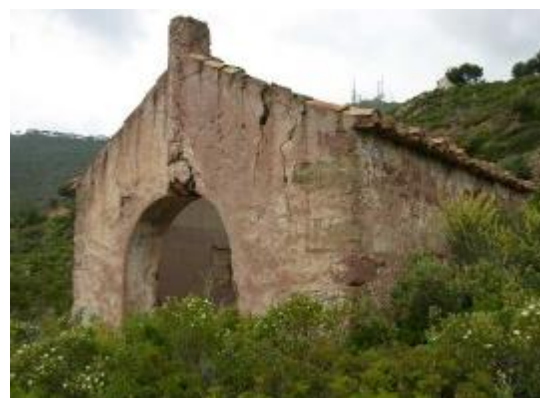
Vista exterior: fachadas principal y este
