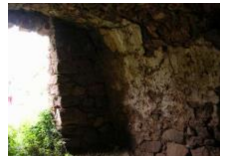
Puerta de acceso. Vista interior
