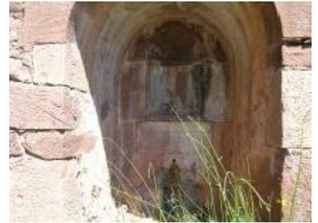
Vista del interior
