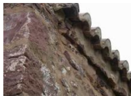
Detalle superior del muro
