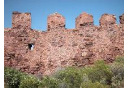
Detalle de la fachada este
