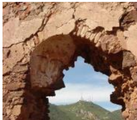
Detalle de la ventana
