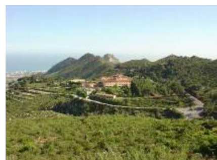
Vista general del conjunto
