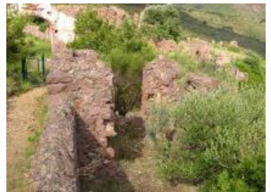
Vista exterior (fachada oeste) (desde arriba del muro de las Estaciones) (muestra las 2 ventanas cegadas arruinadas) (al fondo, a la izquierda, el Arco del Panteón)
