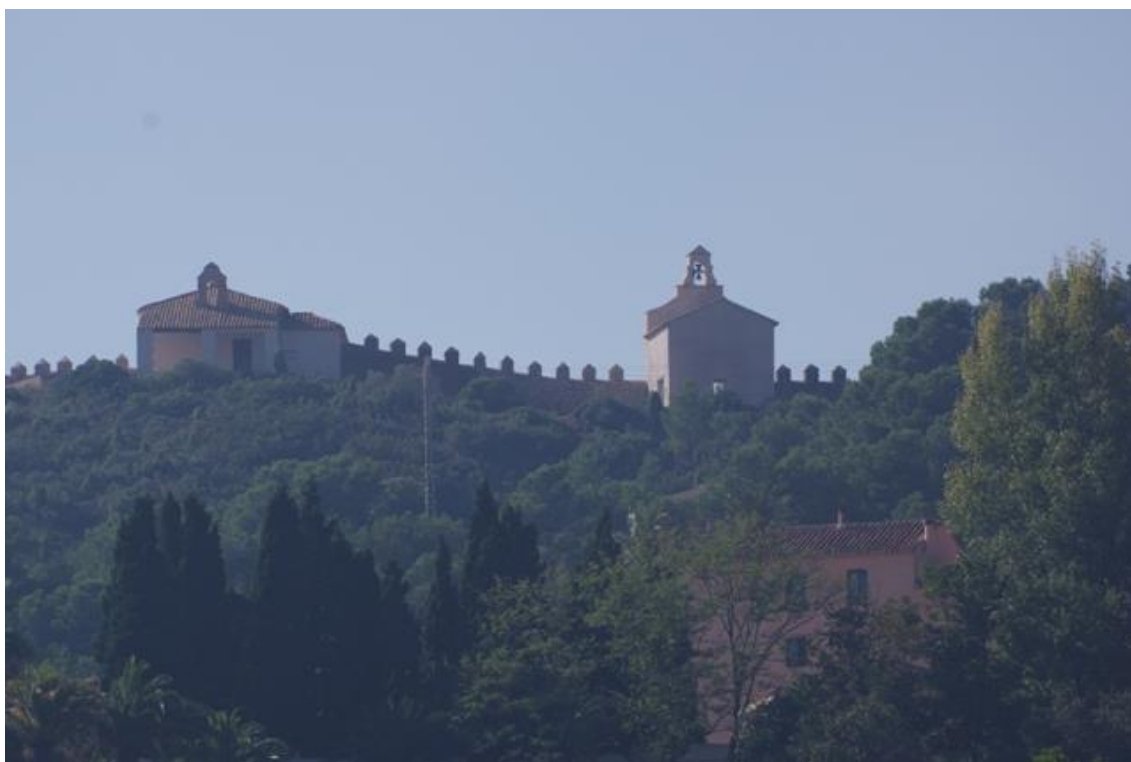
Figura 44: Silueta de la zona de la Portería alta (con la Ermita del Carmen, la casa de la Portería y el muro) (desde la hipotética ubicación de la desaparecida Ermita de S. Antonio Abad y S. Pablo Primer Ermitaño)
