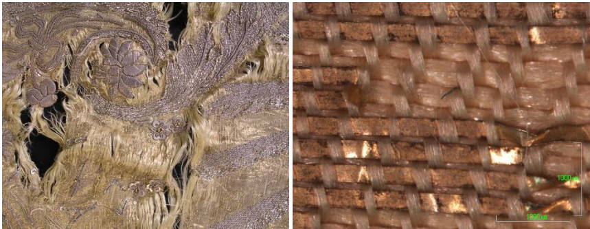
Figura 422. Detalle de roturas y pérdidas del conjunto Brochado e imagen con ME de las pérdidas de tramas de laminillas metálicas.
