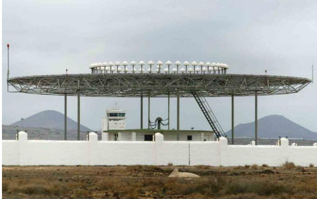
Fig 6. Instalación DVOR/DME [fuente:AENA]
