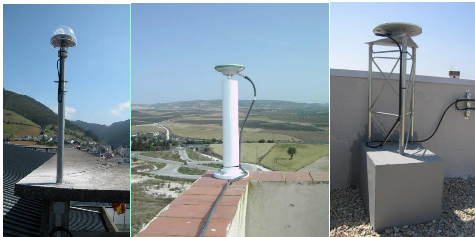
Fig 50. Ejemplos de monumentación de antenas GNSS [fuente propia]
