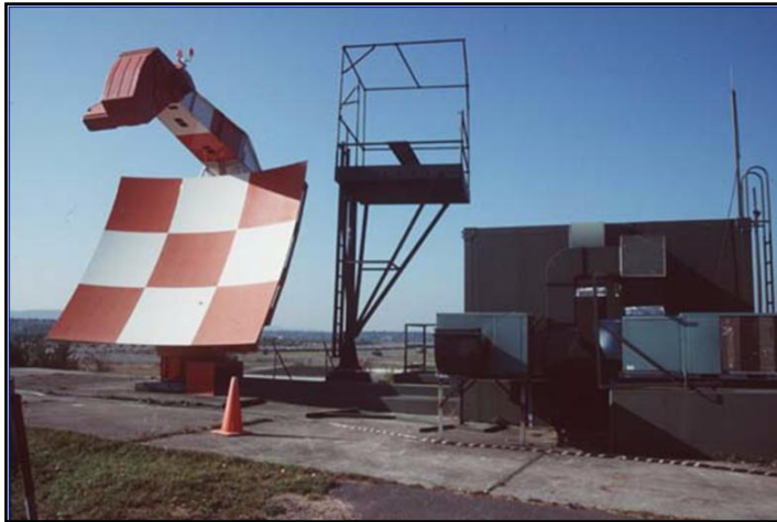
Fig 18. Sistema de Radar de aproximación [fuente:AENA].
