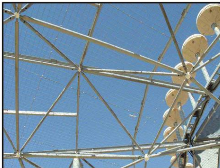
Fig 10. Detalle de Instalación VOR/DMA [fuente:AENA]
