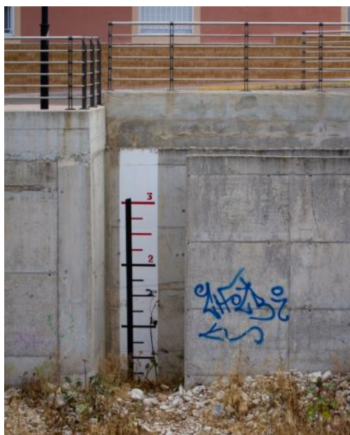
Figura 40. Regla limnimétrica sobre el encazamiento del río Girona a su paso por El Verger. Fuente: Elaboración propia.
