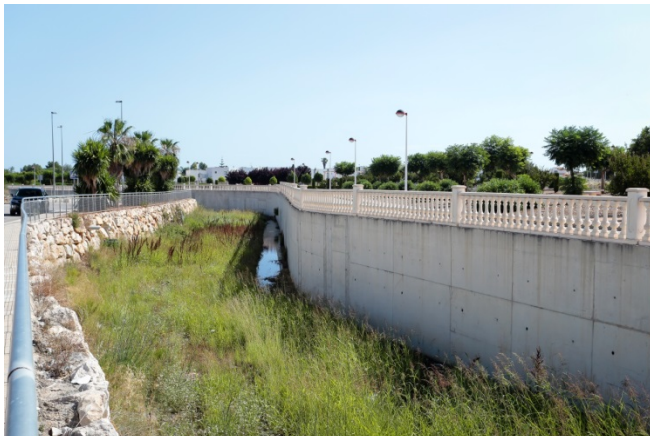
Figura 61. Encauzamiento del barranco de Portelles entre los municipios de Els Poblets y El Verger. Fuente: Elaboración propia.
