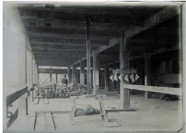
Fábrica La Ceres de Bilbao en construcción. 1899-1900 CNAM/DAF/ Cité de l'architecture et du patrimoine/ Archives d'architecture et du XXe siècle Recurso consultable en [ http://www.cehopu.cedex.es/hormigon/ ]
