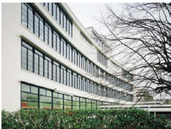
Fotografía de estado actual, con unos toldos exteriores añadidos y las carpinterías restauradas. Disponible en http://fr.topic-topos.com/ecole-jean-baptiste-clement-boulogne-billancourt
