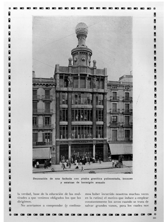
Edificio "El Siglo", en Barcelona, sede de los Grandes Almacenes Damians Arquitectos: Lluís Homà Moncusí; Eduard Ferrés, Ignasi Mas. Construcciones y Pavimentos S.A. Recurso consultable en [ http://www.cehopu.cedex.es/hormigon/ ]
