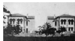
Las escuelas de Villar del Arzobispo antes de la segunda fase en la que se completó el grupo escolar. En la imagen son dos edificios separados. Ver marcas en planta en la A1 150 del anexo
