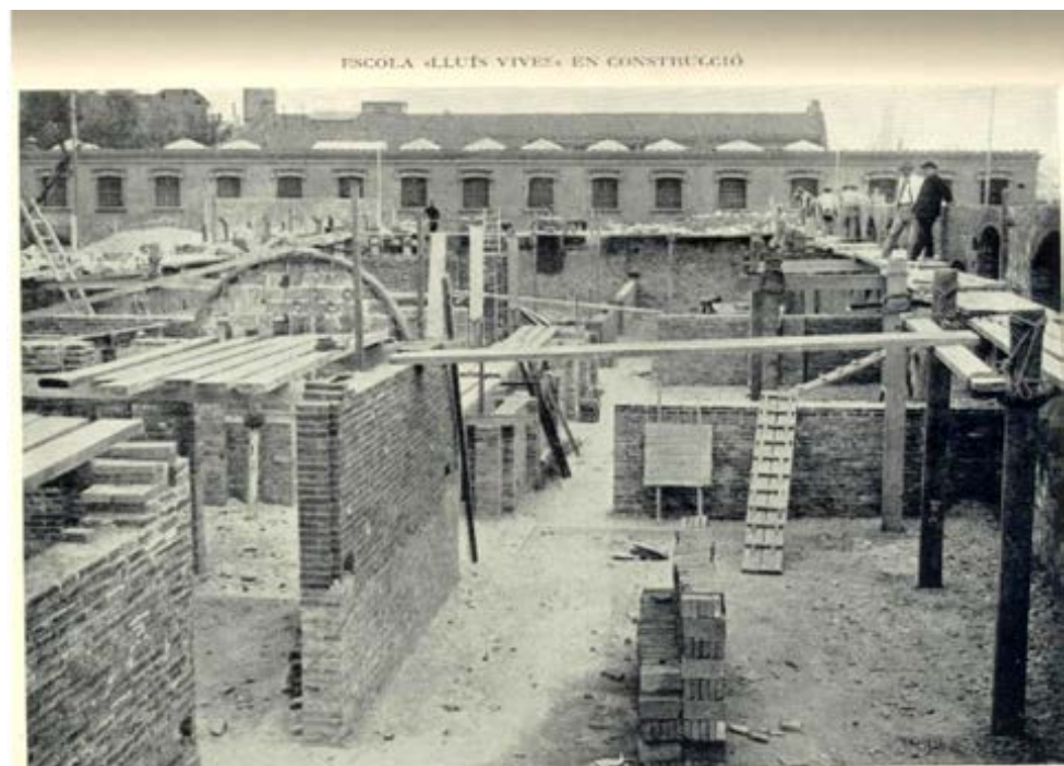
Grupo escolar Lluís Vives en construcción
