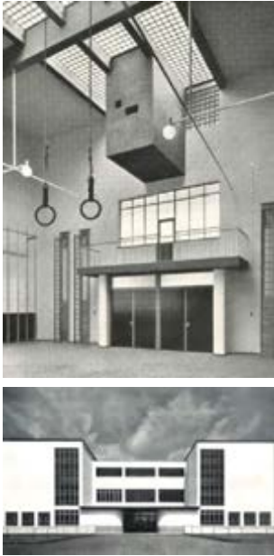
Arriba, sala central polivalente de la escuela en Celle. Obsérvese la cabina de proyección en la parte superior, y las puertas de acceso desde el vestíbulo. Abajo, acceso al edificio desde la vía pública
