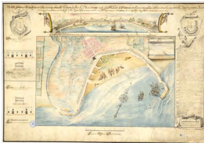
Fig. 11 *PLAN geométrico del estado que en el día tienen las obras del Puerto que de orden de S.M. se construye en la playa del Grau de Valencia, en el que se manifiestan las Direcciones de sus caminos, Muelle y contraMuelle*, de José Serrano, 1824. Fuente: Servicio Geográfico del Ejército. 182.
