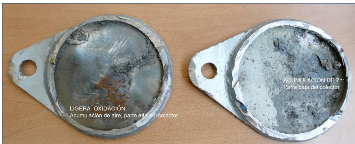
Fotografía 2-33: Hidrante 2. Estado interior zona seccionada. Detalle de corrosión y acumulación de Zn.
