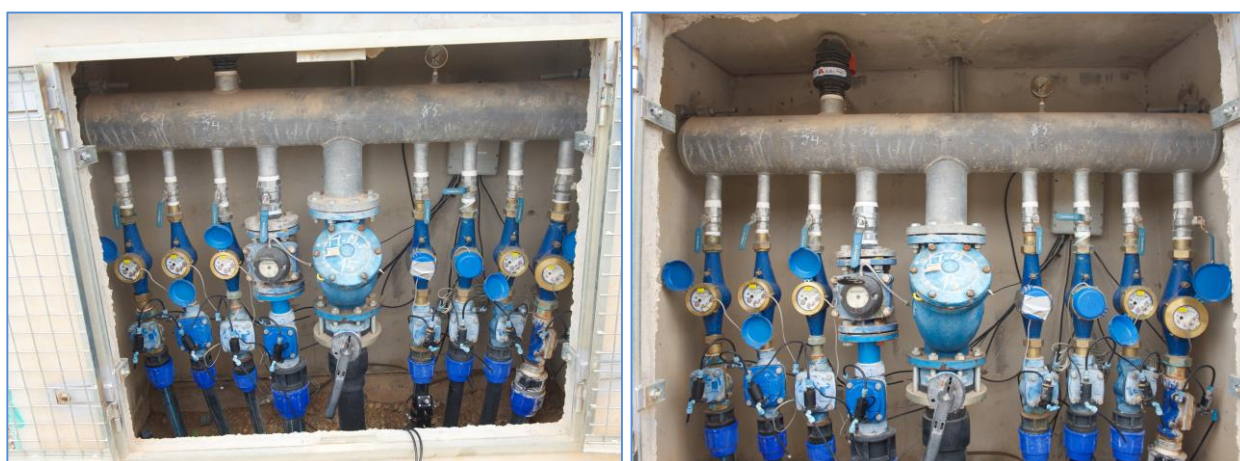
Fotografía 2-9: Hidrante vertical V2. C.R. Los Tollos 2012. Tipo 1. (Fotos Balbastre I.). Filtro caza piedras mal colocado, ventosa sin válvula de aislamiento, tomas muy justas.
