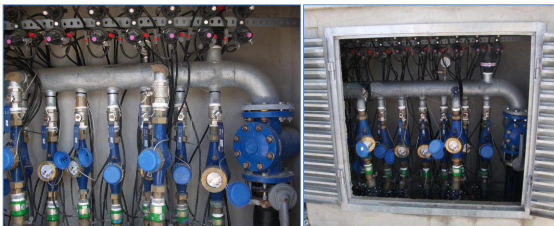
Fotografía 2-4: Hidrante vertical V1-3. C.R. Tarragon 2014. Tipo 1. (Fotos Balbastre I.). Dificil acceso a las tomas por salidas excesivas en el hidrante, sin elemento de filtración.
