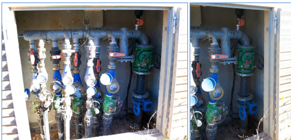
Fotografía 2-4: Hidrante vertical V1-3. C.R. Tarragon 2014. Tipo 1. (Fotos Balbastre I.). Dificil acceso a las tomas por salidas excesivas en el hidrante, sin elemento de filtración.
