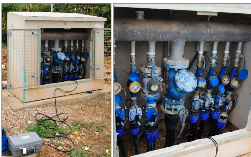
Fotografía 2-48: Detalles instalación en la Toma de DN 30.
