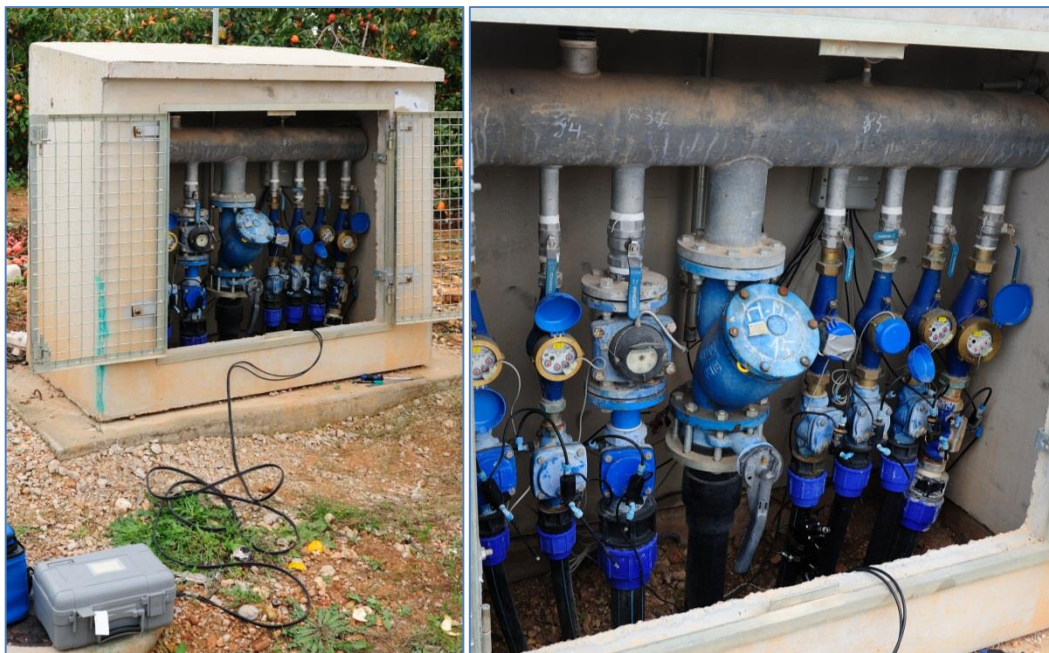
Fotografía 66: Detalles instalación en Toma 30.
