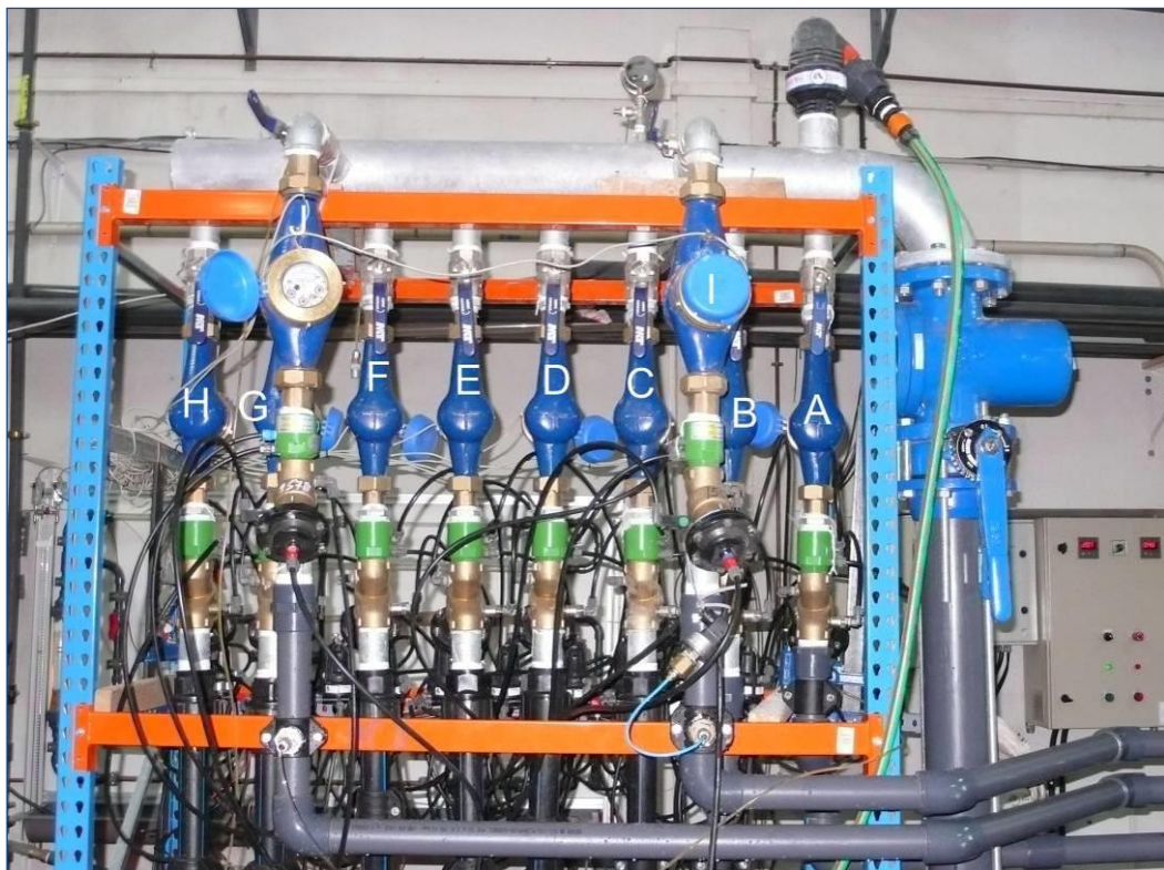
Fotografía 31: Hidrante 7. Detalle posterior del hidrante.
