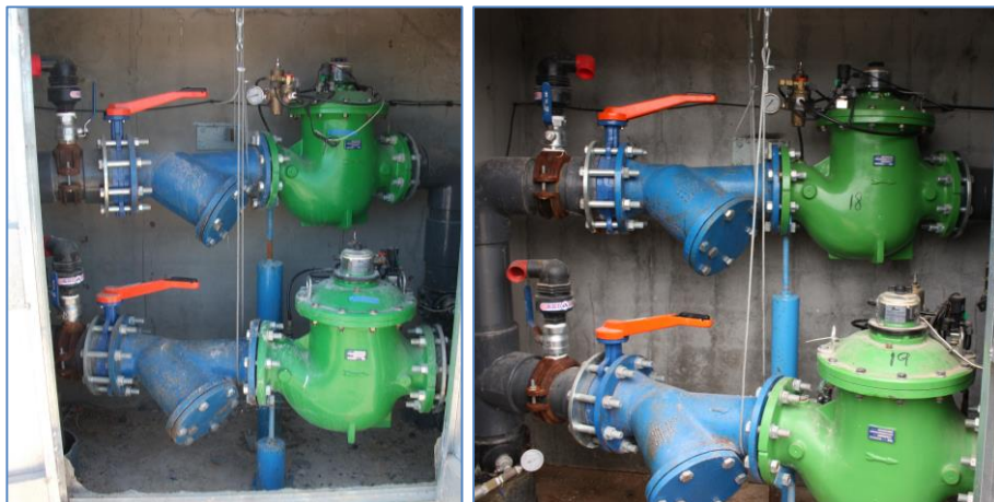
Fotografía 2-21: Hidrante horizontal H1-4. C.R. Casinos 2010. Tipo 3. (Fotos Miranda M., Palau C.V.). Dificultad en el acceso a las tomas.
