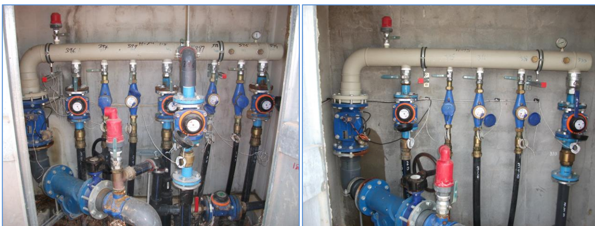
Fotografía 2-6: Hidrante vertical V1-4. C.R. Cota 220 2010. Tipo 1. (Fotos Miranda M.) Buen acceso a las tomas y válvula de retención en cada toma para evitar el vaciado del contador después de la parada del riego.
