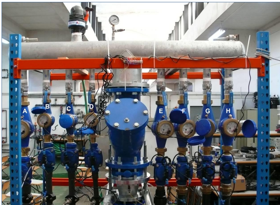
Fotografía 36: Hidrante 8. Detalle hidrante.
