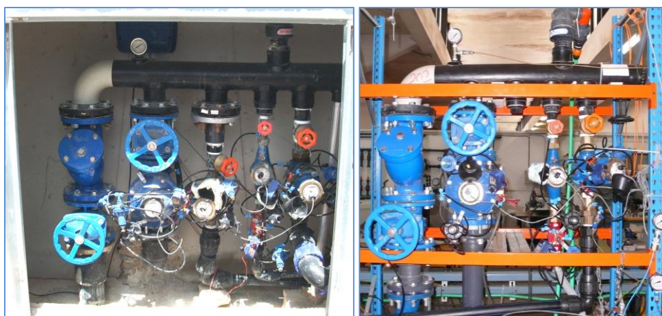
Fotografía 2-3: Hidrante V1-2 C.R. San Isidro y Realengo 2010. Tipo 4.(Fotos Miranda M., Balbastre I.). Poco espaciamento entre tomas, ventosa sin válvula de aislamiento y filtro caza piedras mal colocado.
