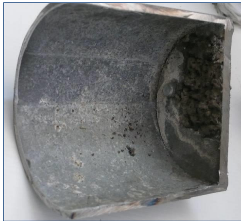
Fotografía 34: Hidrante 7. Detalles del estado interior de la sección 1, extremo toma H.
