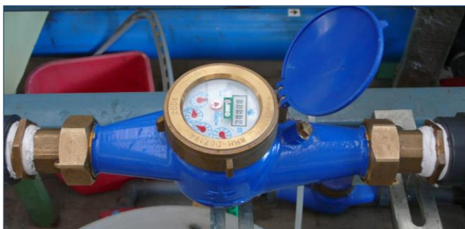
Fotografía 2-51: Contador Wehrle Modelo RMM en posición horizontal
