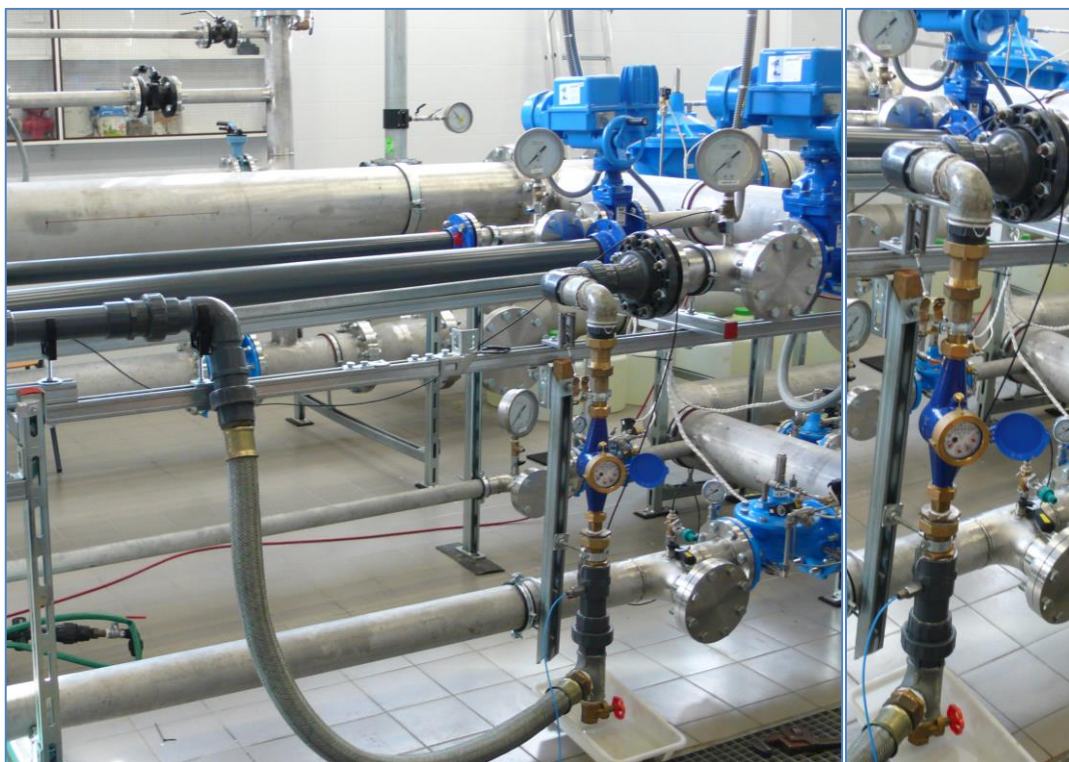
Fotografía 2-50: Detalles de la instalación del contador para el bloqueo en ensayos de laboratorio.
