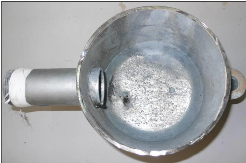
Fotografía 41: Hidrante 8. Detalles del estado interior de la sección 2, extremo toma H.
