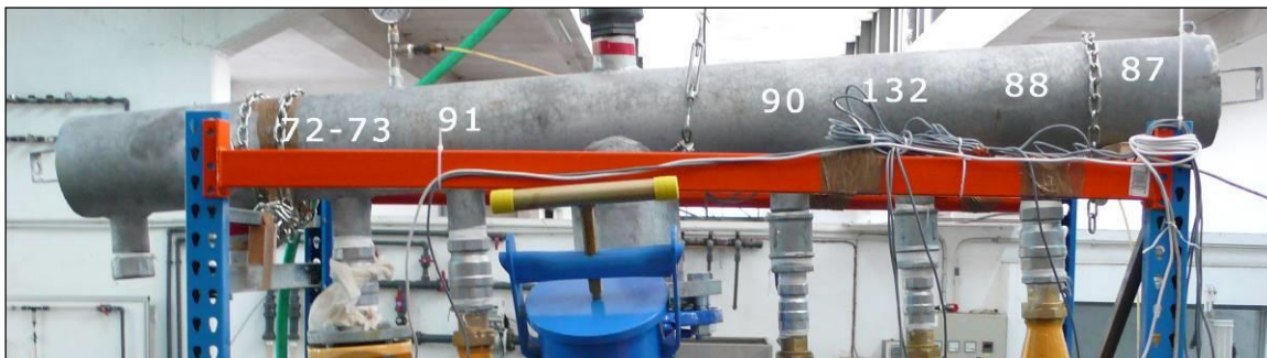
Fotografía 23: Hidrante 5. Colector completo
