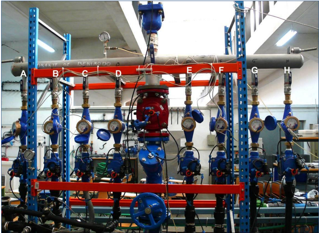
Fotografía 26: Hidrante 6. Detalle hidrante.
