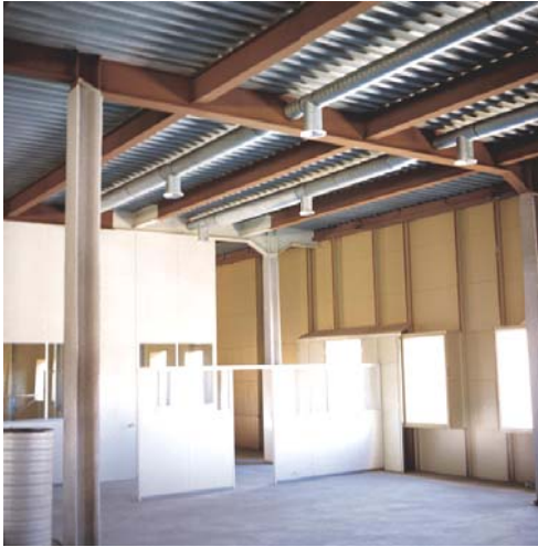
529. Edificio de Correos y Telecomunicaciones, León (1981-1983). A. de la Sota. Sistemas de industrialización ligera y montaje en seco.
