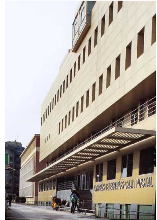
358. 360. Edificio de Correos y Telecomunicaciones León (1981). A. de la Sota.
