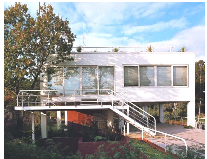
461. 462. 463. Casa Domínguez (Pontevedra, 1975). A. de la Sota. Imágenes de la fachada a la calle y al jardín, y planta primera.
