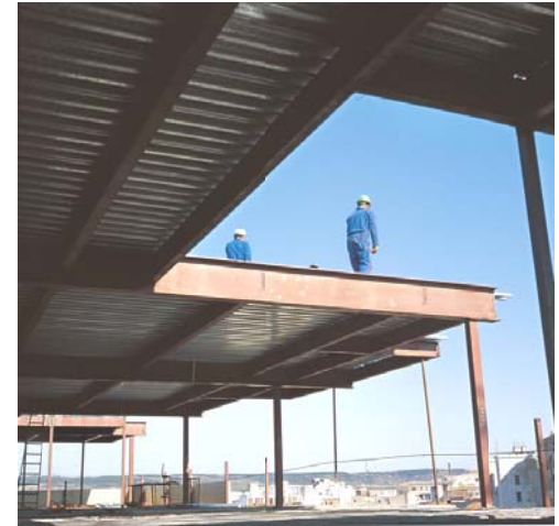
530. Edificio de Correos y Telecomunicaciones, León (1981-1983). A. de la Sota. Montaje de sistemas de industrialización ligera.
