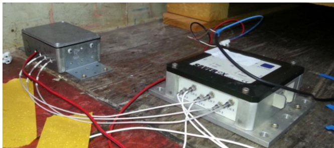
Figura 37. Instalación de los registradores de vibraciones en el contenedor
