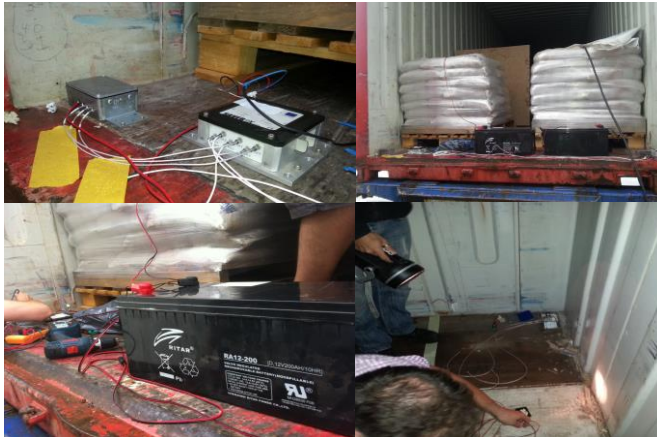
Figura 38. Instalación de los registradores de vibraciones en el contenedor
