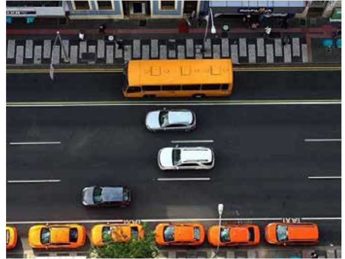
Avenida Marechal Deodora con la nueva vía exclusiva para buses
