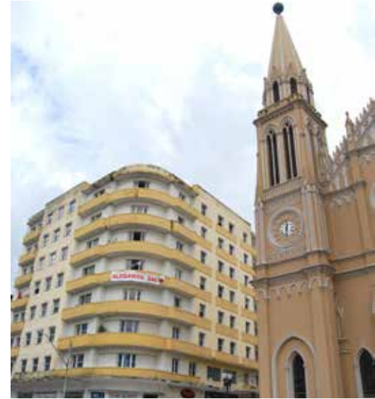
Edifício Nossa Senhora da Luz en contraste con la Catedral
