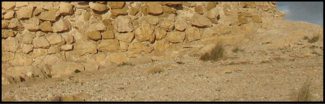
Base de planta circular, con alambor
