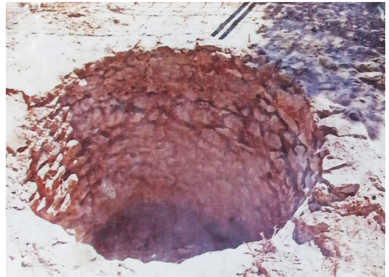
27. La calera, antes de ser rellenada de tierra durante la restauración
