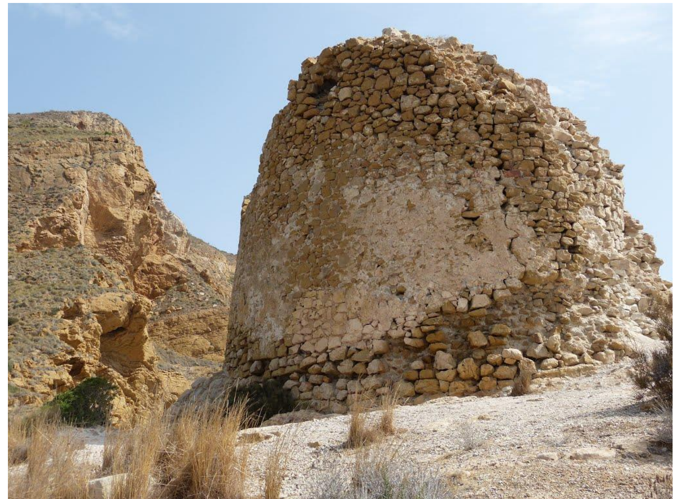
19.Estado actual de la torre. Sólo distinguible su base
