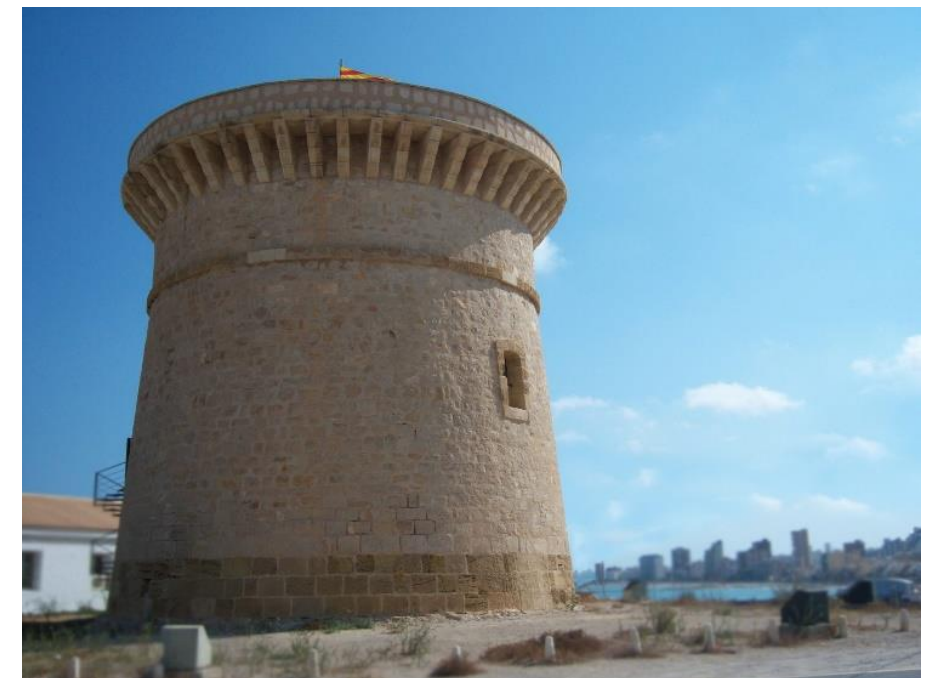
4.5 TORRE DE LA ILLETA
