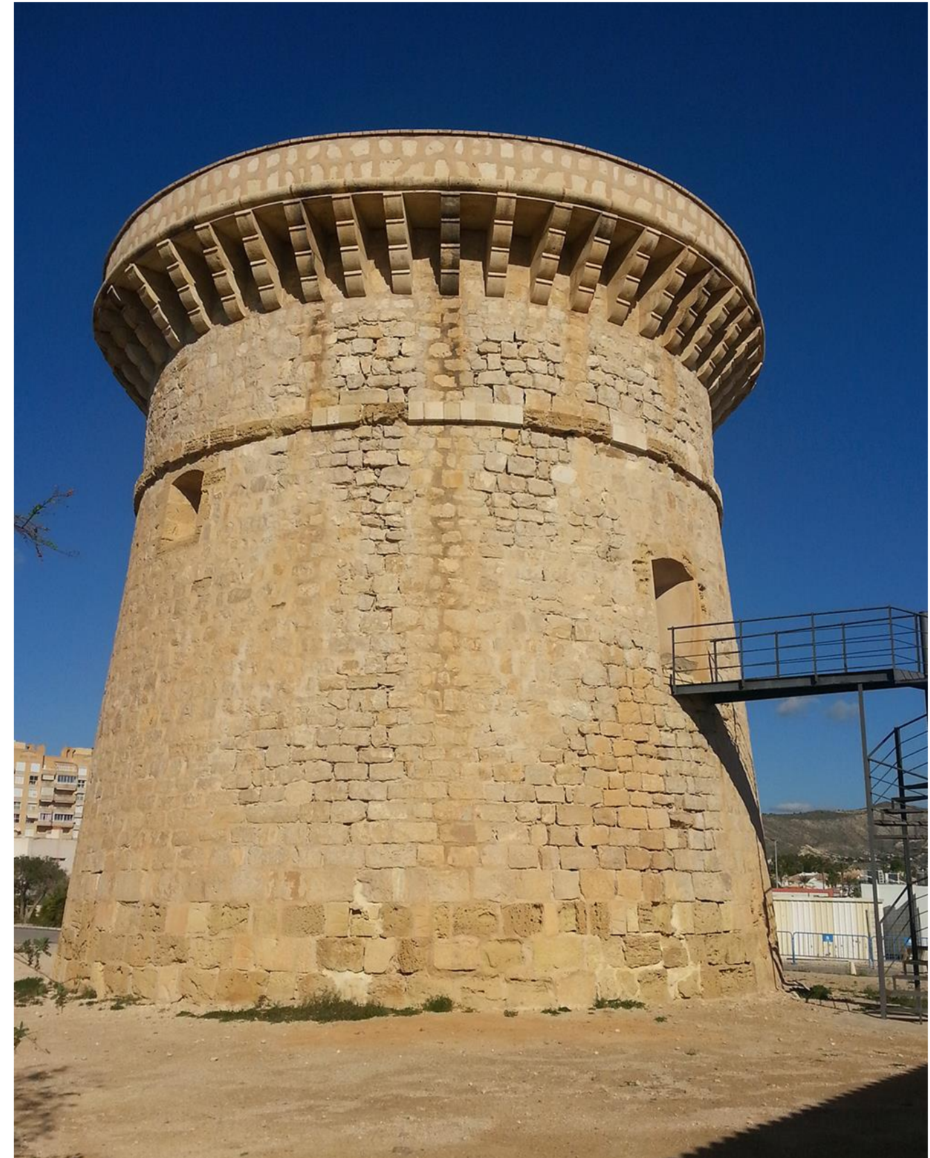
31. Estado actual de la torre, noviembre de 2015. Fotografía propia.
