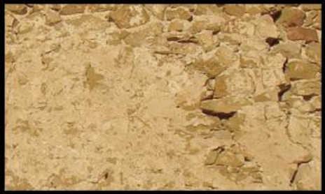
Fabrica de mampostería enfoscada con mortero de cal
