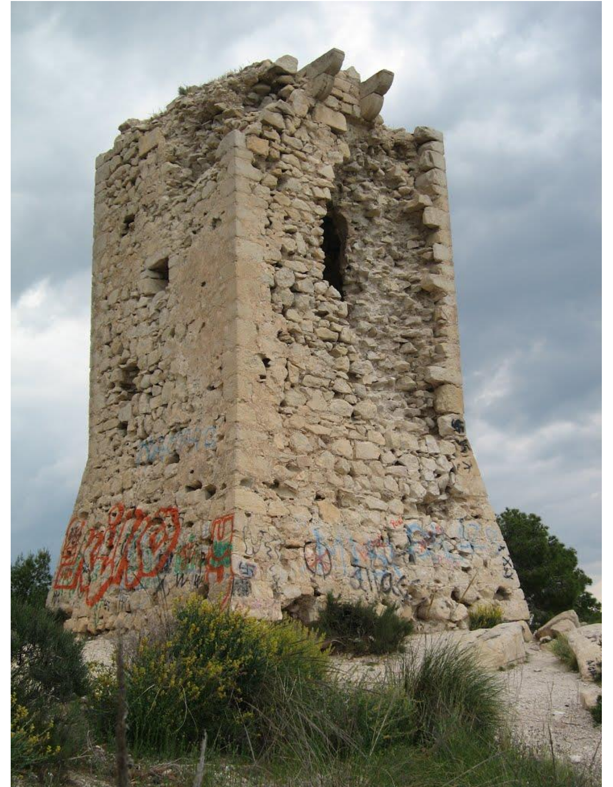
24. Estado de la fachada sur, previamente a su restauración. Fuente: www.alicantevivo.org
