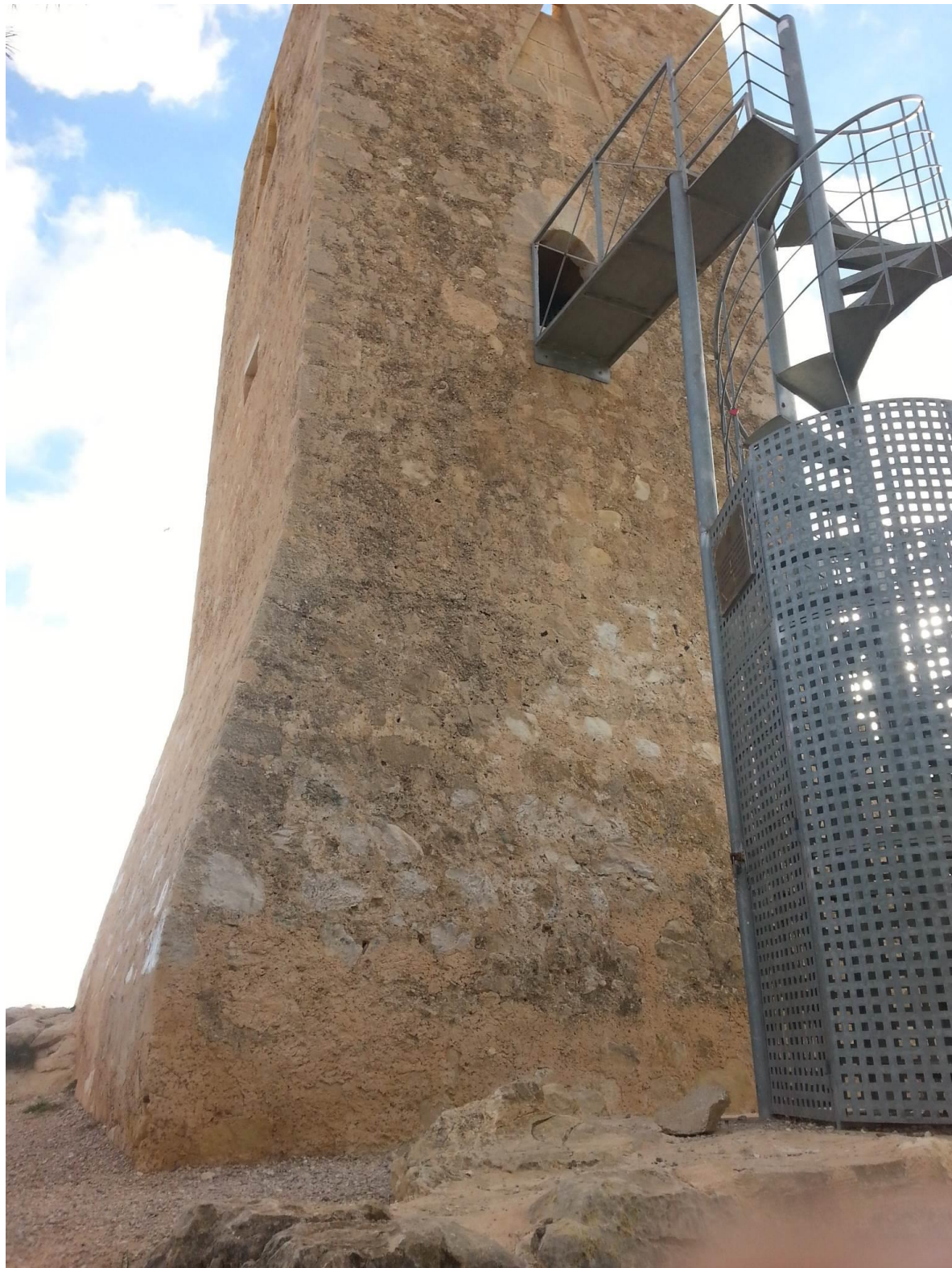
25. Fachada norte en 2016. Se aprecia tras la restauración, la colocación de una escalera metálica. Fotografía propia.
