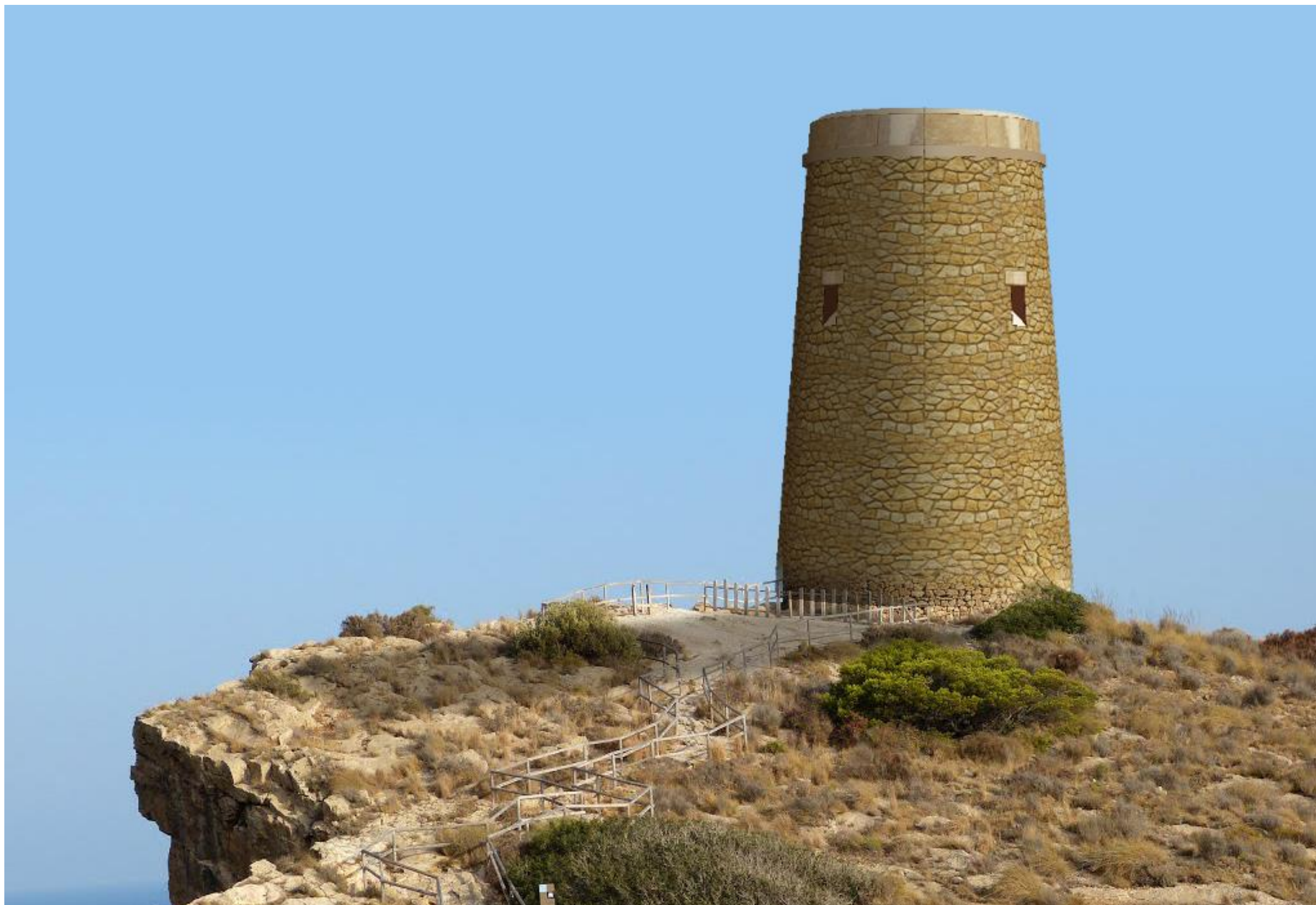
23. Reconstrucción virtual de la Torre de les Caletes. Mediante combinación de fotografía y volumetría 3D obtenida con SolidWorks y técnicas fotogramétricas.
