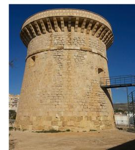
La torre de la Illleta fue restaurada en los 90, aunque no con rigor a su estado original. De ésta torre se ha podido realizar un escáner 3D y cruzar los datos con fotografías, para obtener un levantamiento fotogramétrico 3D perfecto.
