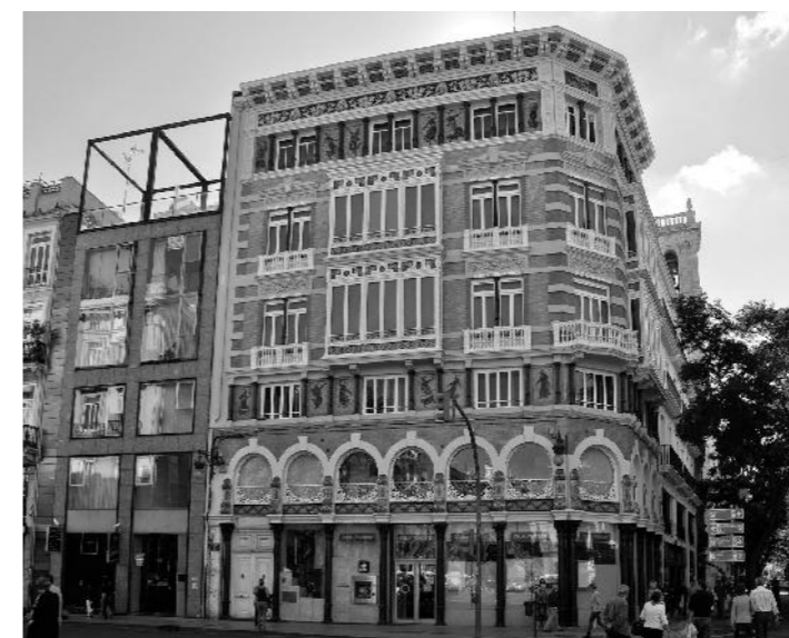
Edificio La casa de Cuba. 1895. http://valenciaarenaycal.blogspot.com.es/
