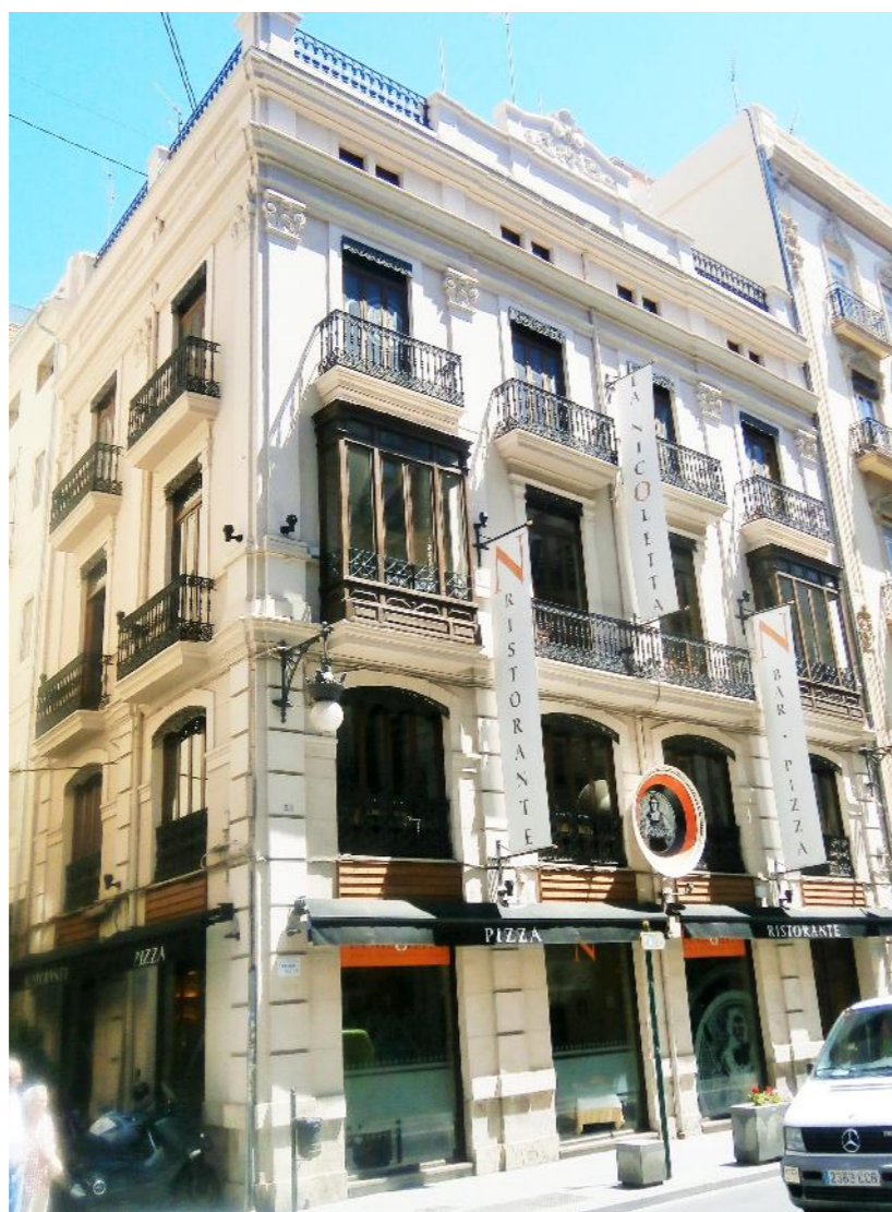
Fachada principal.La calle de la Paz.
