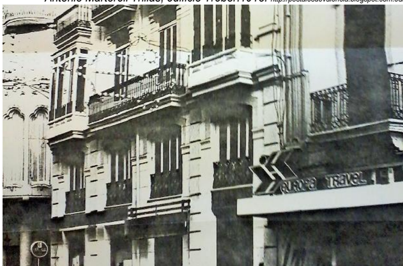
Fachada del edificio,objeto de estudio.1985.Proyecto original
