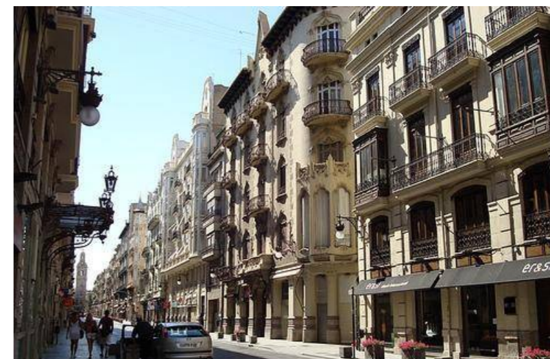
Edificio de la calle la Paz,33.2008. http://www.urbarama.com/
