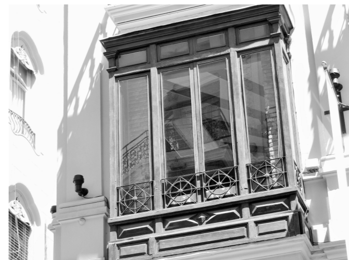
Carpintería de madera de los miradores
