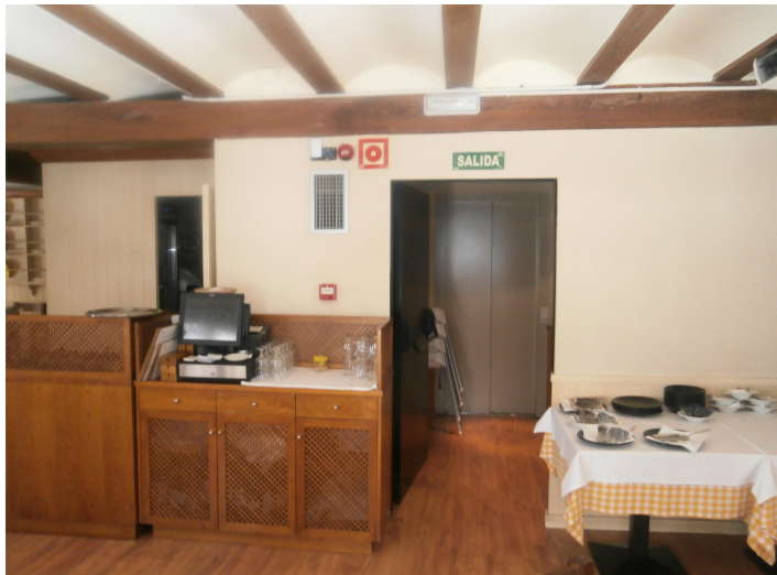
Tabiquería revestida de yeso y paneles de color blanco.
