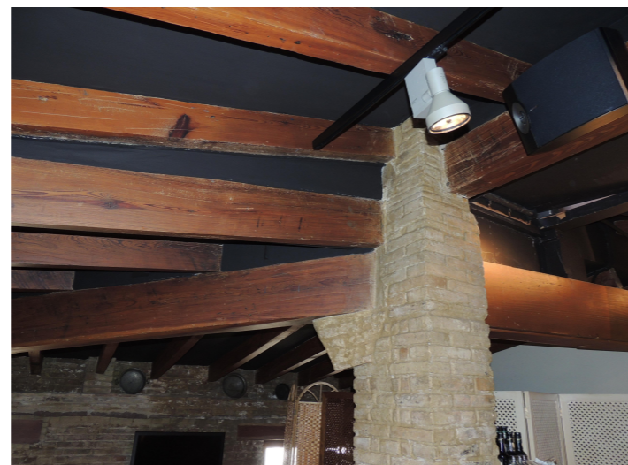
Estructura bajo tejado
