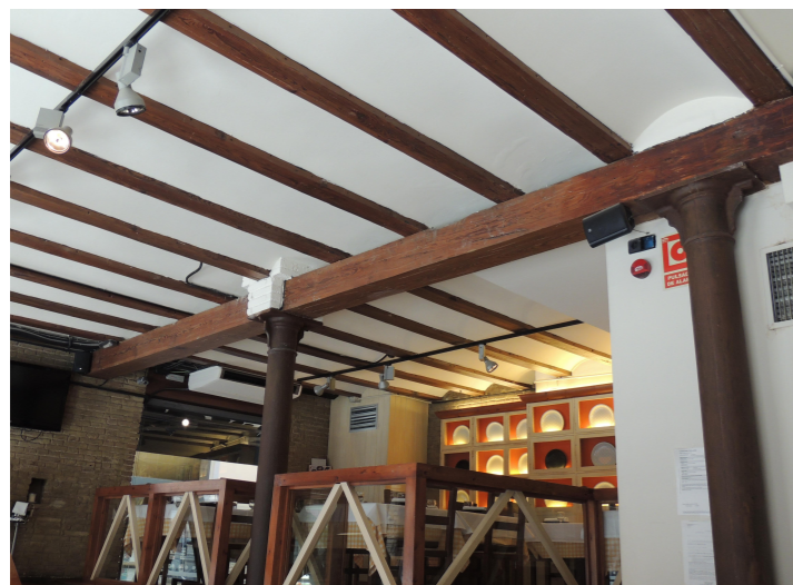
Pilares de hierro fundido, vigas de madera y fachada de ladrillo macizo
