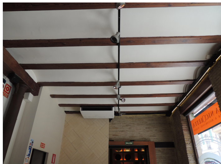
Estructura de madera. Forjado planta primera.
