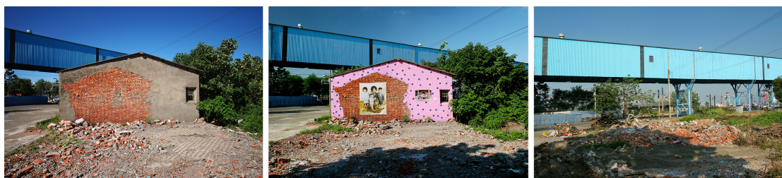
Las imágenes documentan el estado antes y después de la casa por la obra de Yang Shun-Fa.
