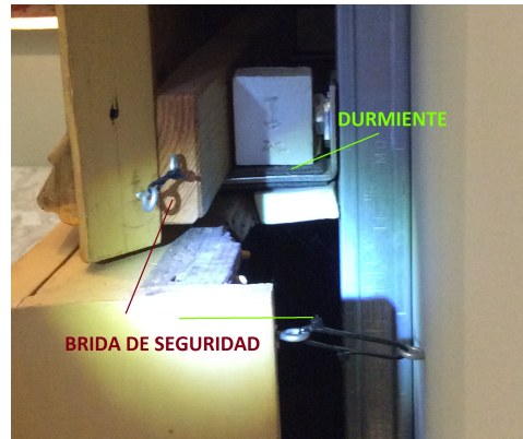
Imagen derecha 46 e imagen izquierda 47. Sistemas de suspensión y fijación en el montaje. Fuente: Autor.
