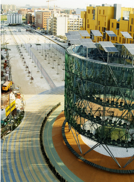
Fig.3.48. Ecosistema Urbano, árbol lúdico y de aire en el bulevar de la naturaleza.
