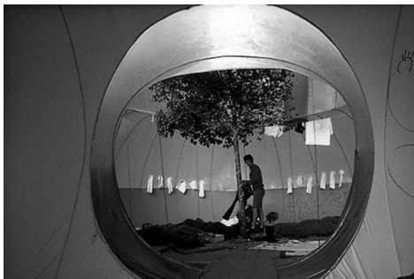
Fig.3.14. José Miguel de Prada Poole, Instant City, Ibiza, 1971. Era una ciudad de plástico, efímera, basada en un sistema constructivo simple de cilindros y esferas hinchables interconectados con la posibilidad de crecer según las necesidades
