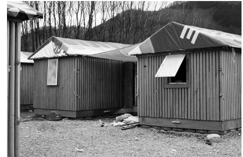
Fig.3.15. Shigeru Ban, Paper Log House, 1995. Viviendas de emergencia para los damnificados en el terremoto de Kobe, Japón. Autoconstruidas con economía de medios, usan como cimentación cajas de refresco llenas de arena, paredes de tubos de cartón reciclado protegidos del agua con parafina, y una cubierta de lona que permite la ventilación.
