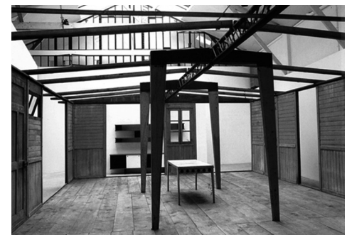
Fig.3.16. Jean Prouvé, Charlotte Perriand y Pierre Jeanneret, Maisons à portiques, 1939-47. Pabellones desmontables donde ningún elemento sobrepasa los 100 kg, de montaje rápido, sencillo y transportable en un camión de una sola vez.
