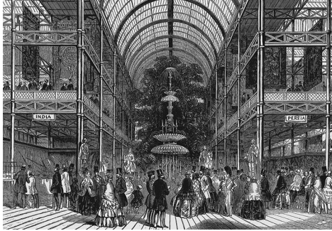
Fig.3.1. Paxton, Crystal Palace, Londres, 1851. Vista interior del transepto. El Crystal Palace supuso la aplicación a gran escala de elementos prefabricados que Paxton desarrolló a partir de sistemas empleados en los invernaderos. La modulación del edificio vino dada por la hoja de vidrio plano que más grande se fabricaba.
