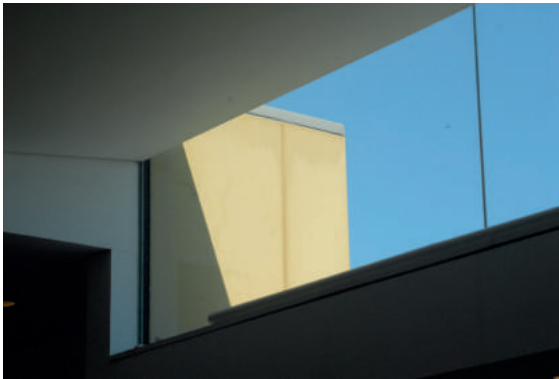
Fig.34. La luz de Norte entra en las salas de museo desde la zona superior deslizándose por las grandes losas que emergen como lucernarios.
