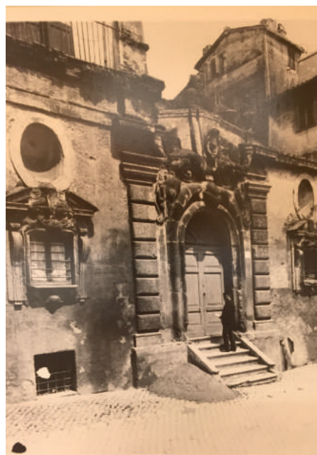
Fig. 130. Fotografía de la fachada a la Via Gregoriana, 1904/1907, archivo Biblioteca Hertziana
