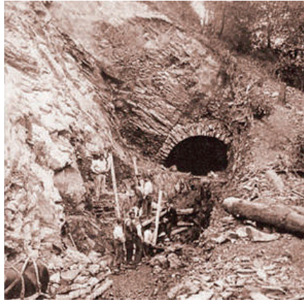
Fig. 132. Excavaciones para el ferrocarril en la sierra de Atapuerca
