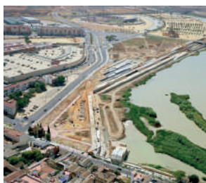
Fig.47. Vista aérea de las obras del Balcón del Guadalquivir. Imagen de archivo 2004.
