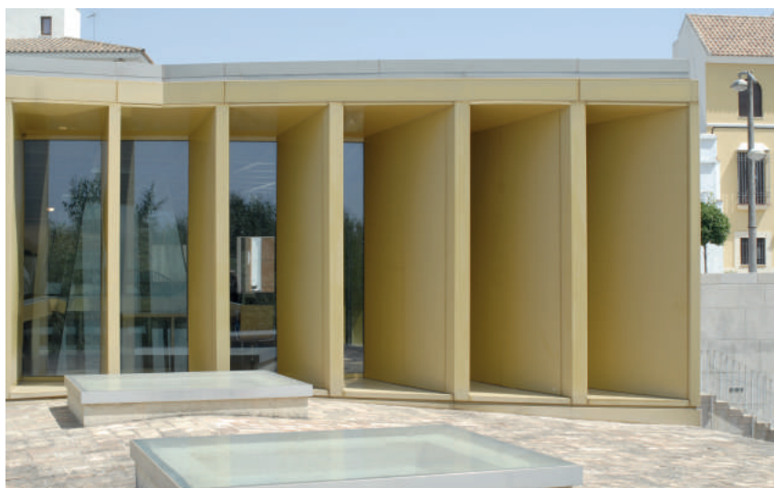
Fig. 354. Juan Navarro Baldeweg, lucernarios en cubierta sobre la sala de molienda.
