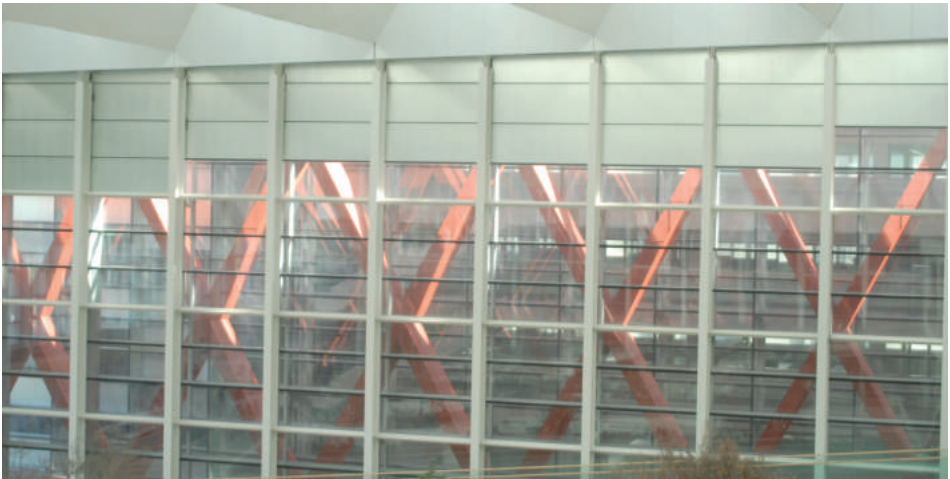
Fig. 138, Vista de la estructura metalica de sujecion roja.
