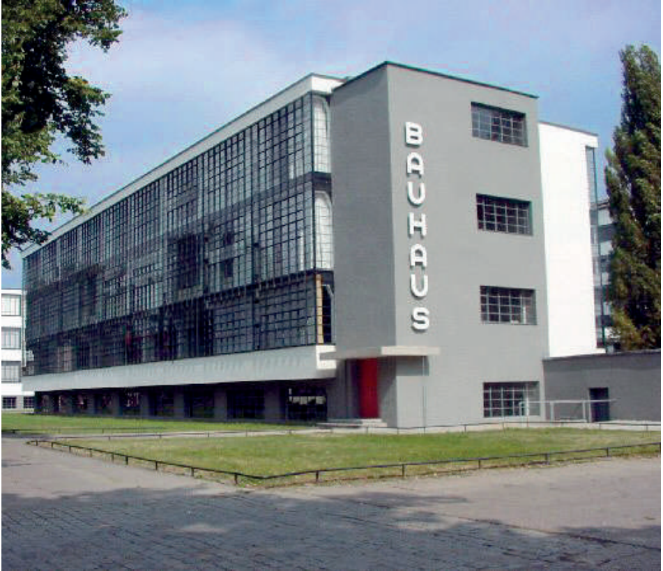
Fig. 1. Imagen del edificio de la Bauhaus en Dessau, Alemania.
