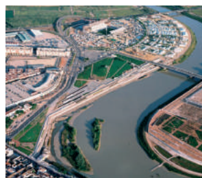
Fig.48. Vista aérea de las obras del Balcón del Guadalquivir en la actualidad.
