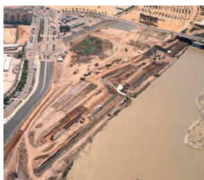
Fig.46. Vista aérea de las obras del Balcón del Guadalquivir durante las obras. Imagen de archivo 2002.
