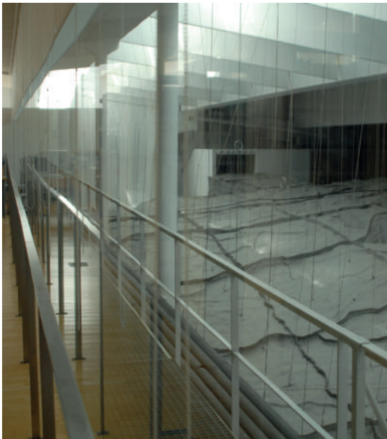
Fig.41. Imagen de los cables y el techo que sostienen la neo-cueva, desde la zona técnica del museo.
