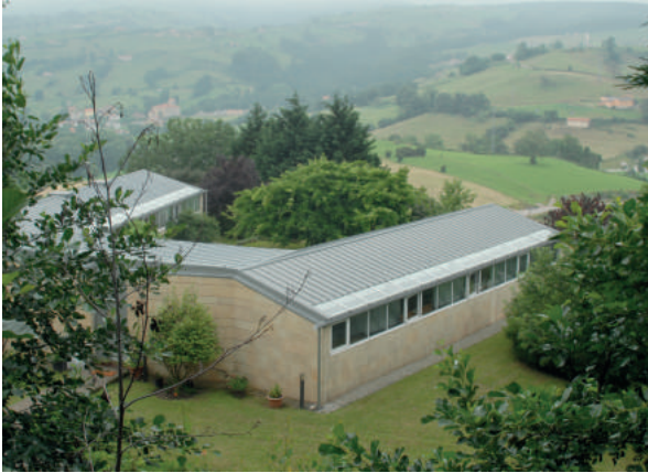
Fig. 8. "Casa de la Lluvia", Liernés, Santander, 1982.
