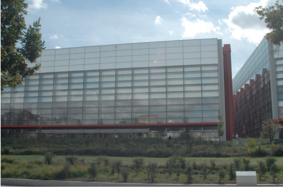
Fig. 143, Museo de Burgos, Vista de la fachada principal.
