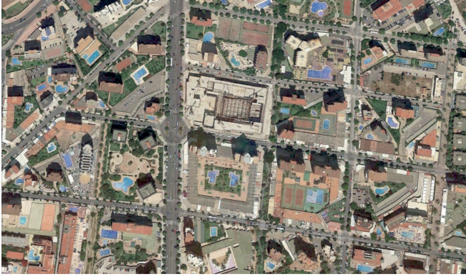
Fig. 358. Imagen aérea del emplazamiento del concurso con la obra en construcción. 21
