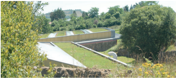
Fig. 38. Vista superior del volumen de las cubiertas ajardinadas, inmersa en el paisaje cántabro.
