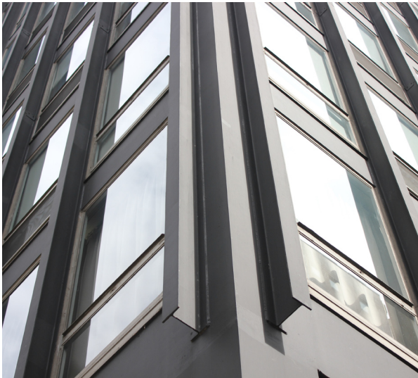
Detalle de la esquina y perfiles de acero en I de las torres en la zona inferior. Fotografía año 2015.
