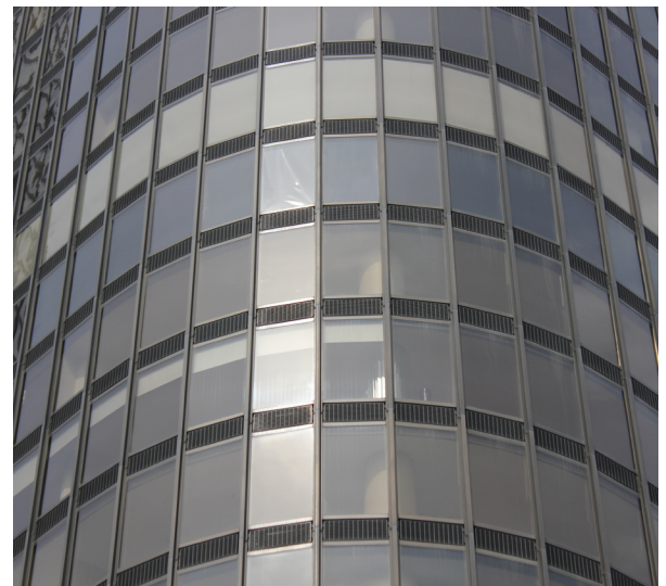
Detalle de la fachada. Elemento de ventilación natural en el perímetro. Fotografía año 2015.
