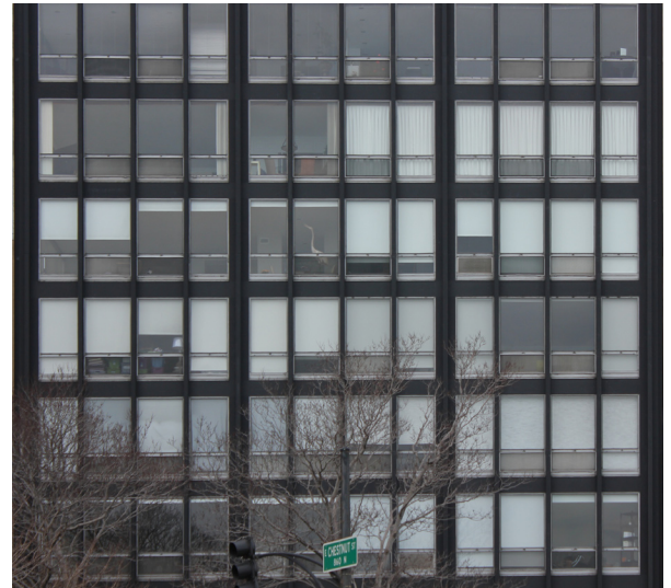
Muro cortina de las torres caracterizado por la modulación, y los perfiles de acero. Fotografía año 2015.
