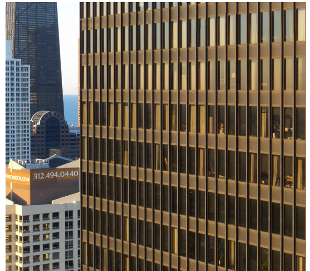
Vista de la fachada del muro cortina. Fotografía de JMCMichael año 2004.
