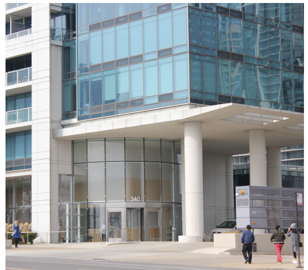
Marquesina de entrada. Fotografía año 2015.
