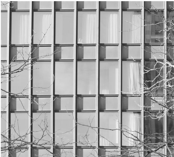
Vista de la fachada del muro cortina. Fotografía año 2015.
