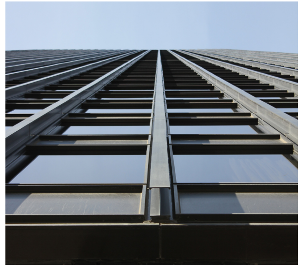
Perfiles de fachada. Fotografía año 2014.
