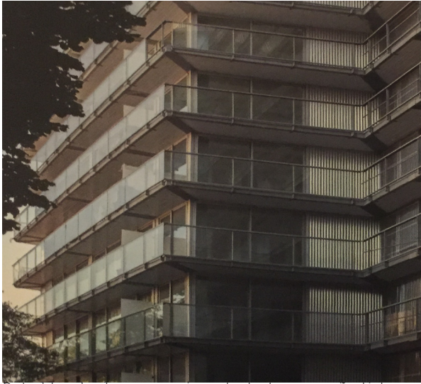
Detalle de los espacios de balcones añadidos. Fotografía extraída de la publicación El Croquis 177/178.
