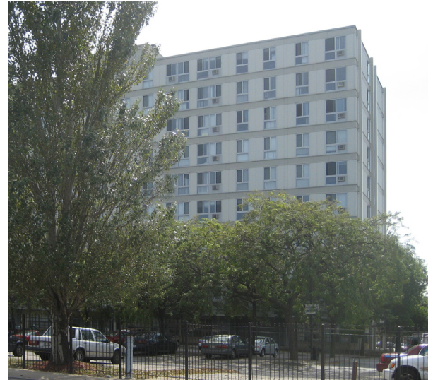
Fotografía de la fachada norte de una de las torres del conjunto de Lake Grove Village. Fotografía año 2009.
