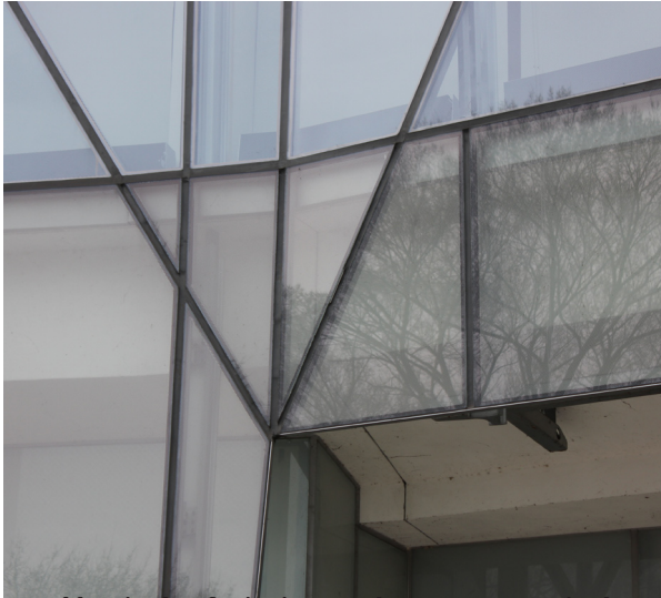
Detalle de la fachada en el retranqueo de la entrada y confluencia de paneles de diferente tamaño y ángulo. Fotografía año 2015.
