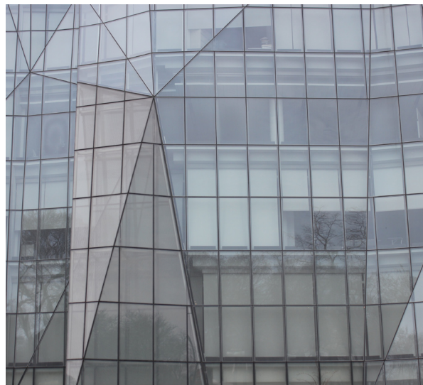
Detalle de pliegue en la fachada principal. Fotografía año 2015.
