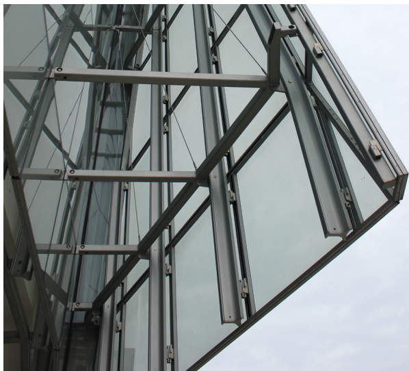
Detalle de marquesina de entrada. Fotografía año 2015.
