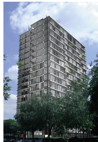
Proyecto de Transformación de Tour Bois le Prêtre, París, 2005-2011, Lacaton & Vassal.
