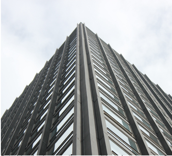
Detalle de la esquina y perfiles de acero en I de las torres en la zona superior. Fotografía año 2015.
