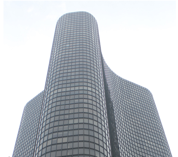
Piel ondulante de la torre. Vista de la parte superior. Fotografía año 2015.
