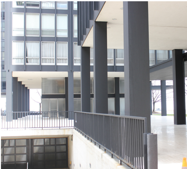
Conexión entre torres. Fotografía año 2015.
