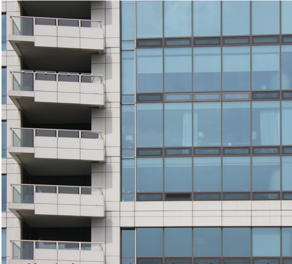
Detalle de los espacios de los balcones y los paneles de vidrio operables en la fachada Sur. Fotografía año 2015.
