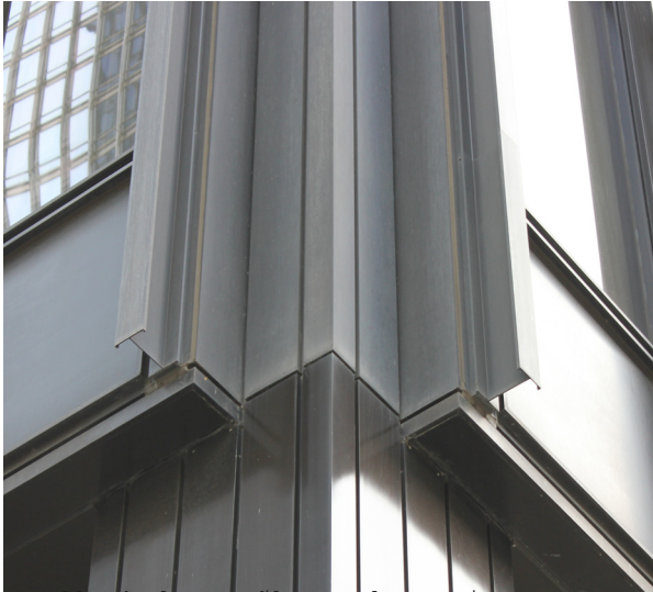
Detalle de los perfiles en la esquina. Fotografía año 2015.
