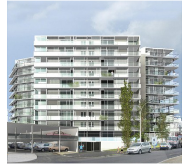
Proyecto de Transformación de torre de viviendas en Saint Nazaire, 2006-2012, Lacaton & Vassal. Fotografía del proyecto extraída de la publicación 2G No.60.
