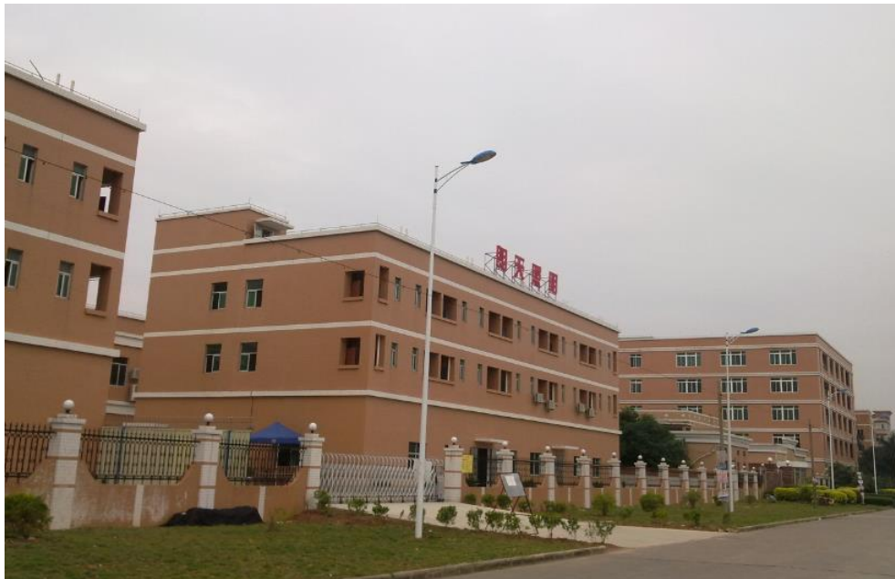
Figura 1: Instalaciones de LT Fuente: www.lighting-lt.com
