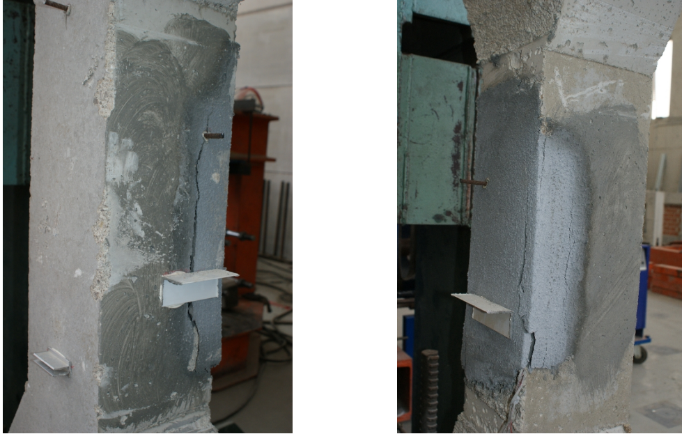
Figura 163 - Pilares PRP_R4+PU tras el ensayo a compresión. Fisuración caras laterales C2 y C4 respectivamente.
