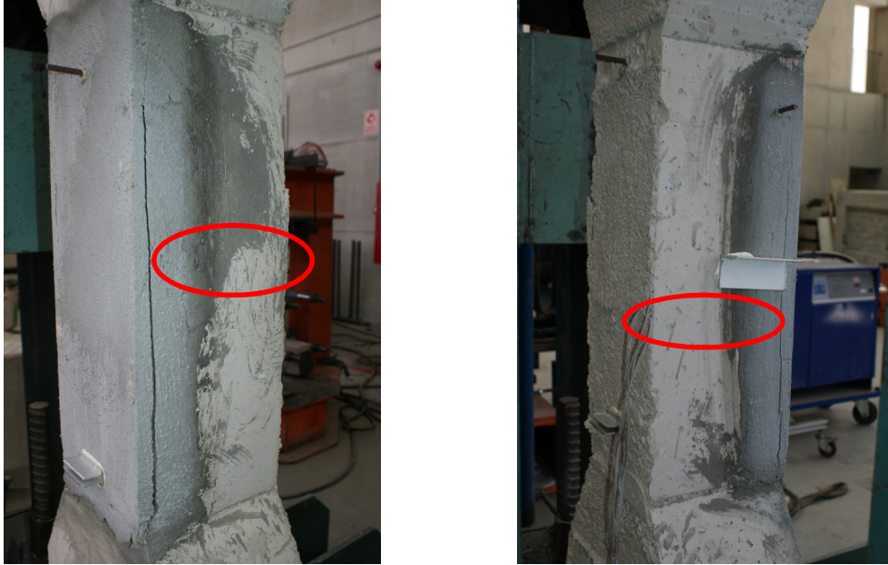
Figura 108 - Pilares PR1C_R3 tras el ensayo a compresión. Fisuración caras laterales, C2 y C4 respectivamente.
