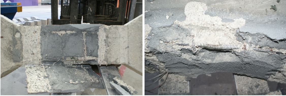
Figura 173 - Pilares PRP_R4 tras el ensayo a compresión. Detalle del desprendimiento de la capa de reparación tras el ensayo.
