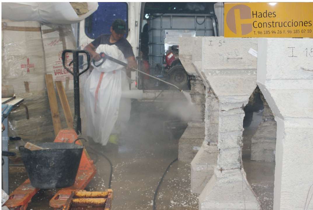
Figura 37 - Limpieza de las superficies mediante chorro de agua a alta presión.
