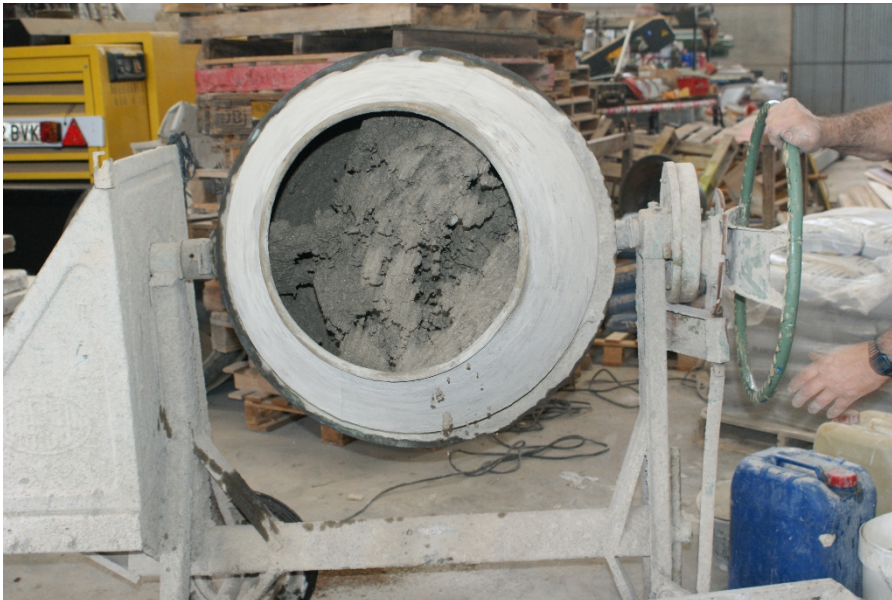
Figura 26 – Fabricación del hormigón de los pilares para los ensayos previos.
