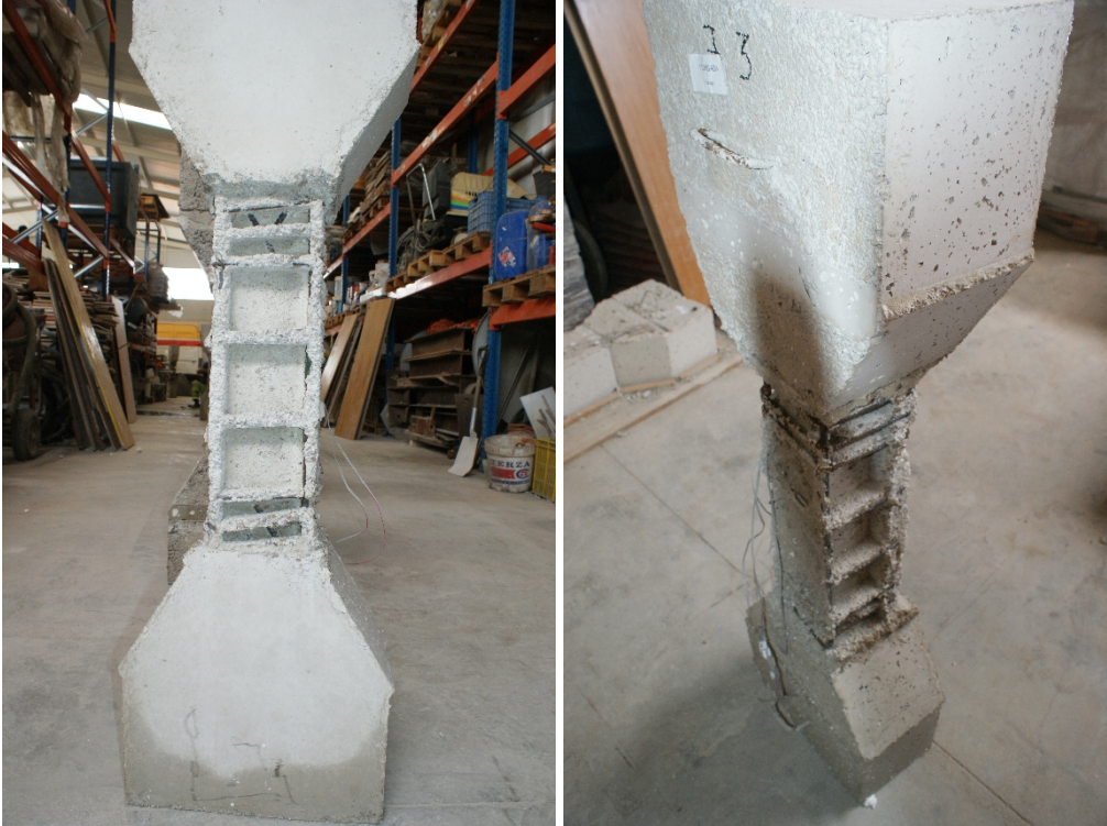
Figura 38 - Detalle del pilar daño 4 caras.
