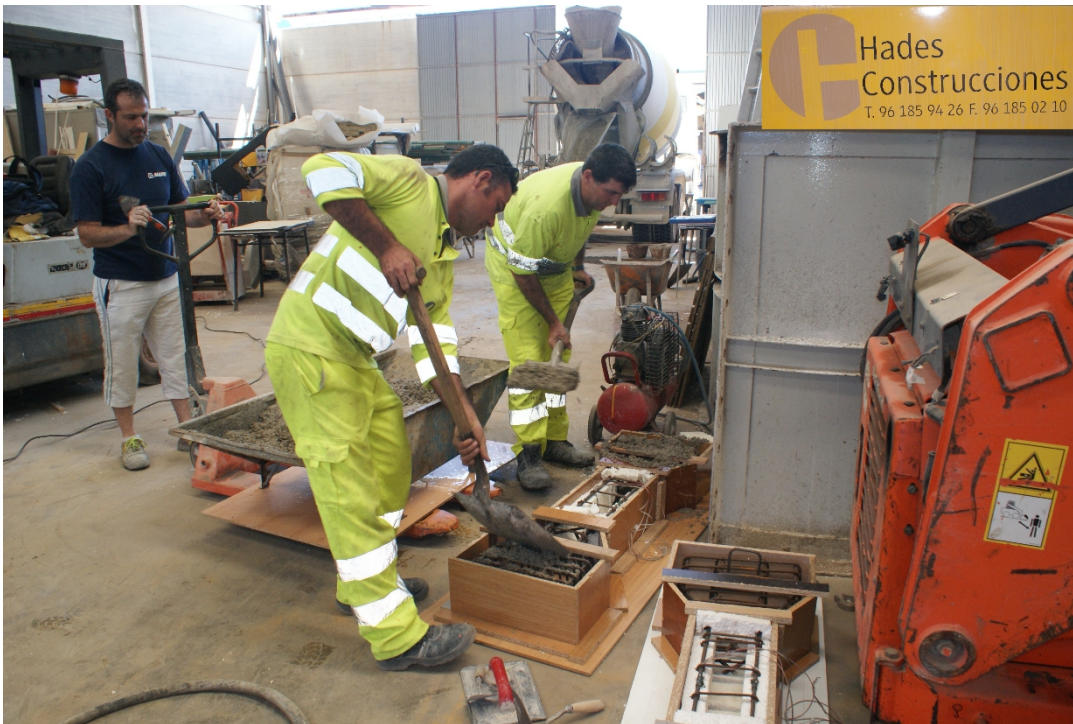
Figura 32 - Relleno de los encofrados.
