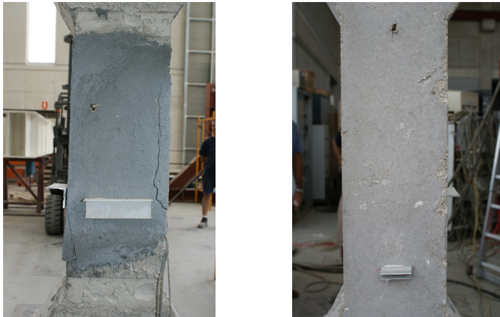
Figura 162 - Pilares PRP_R4+PU tras el ensayo a compresión. Fisuración caras C1 y C3 respectivamente.
