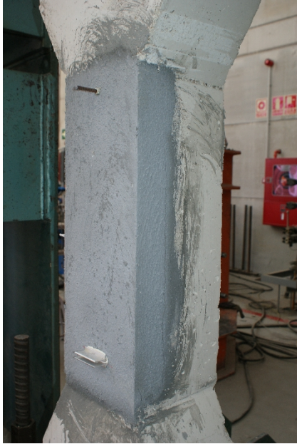
Figura 118 - Pilares PR1C_R4+PU tras el ensayo a compresión. Fisuración cara lateral C2.
