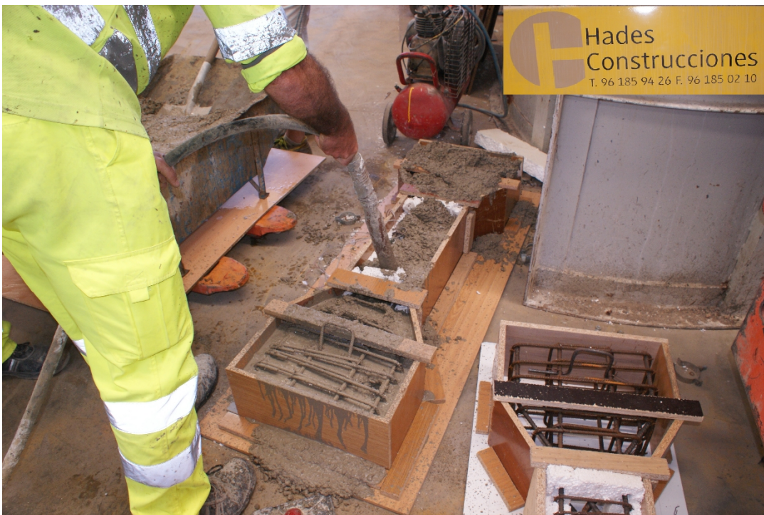
Figura 33 - Vibrado del hormigón.
