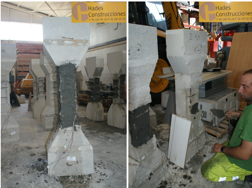
Figuras 43 y 44 - Relleno primera capa pilar a cuatro caras y parcheo.
