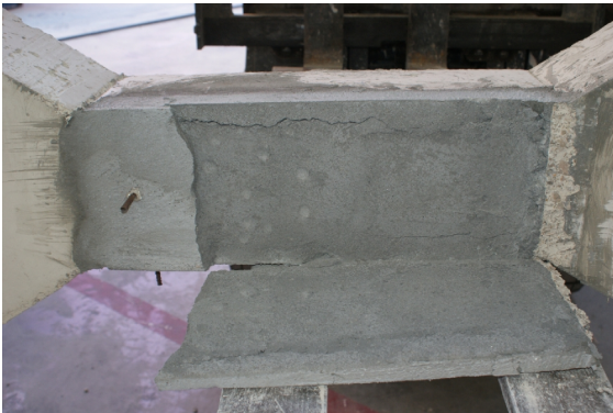
Figura 109 - Pilares PR1C_R3 tras el ensayo a compresión. Detalle del desprendimiento de la capa de reparación tras el ensayo.
