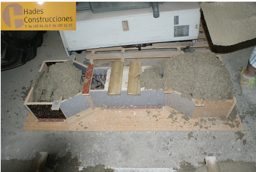
Figura 35 - Hormigonado pilar parcheo.
