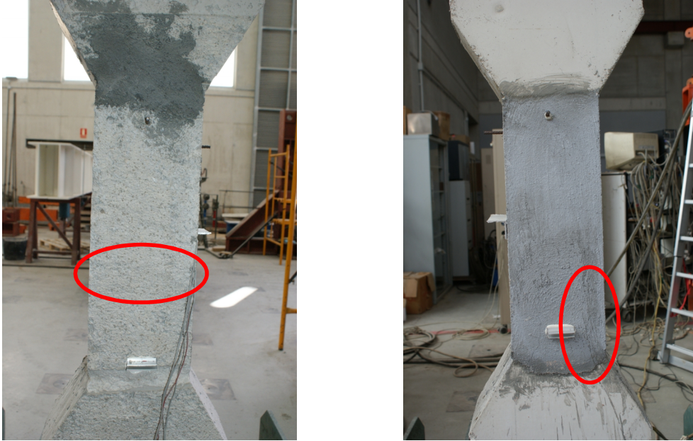
Figura 96 - Pilares PR1C_R3+PU tras el ensayo a compresión. Fisuración caras C1 y C3 respectivamente.
