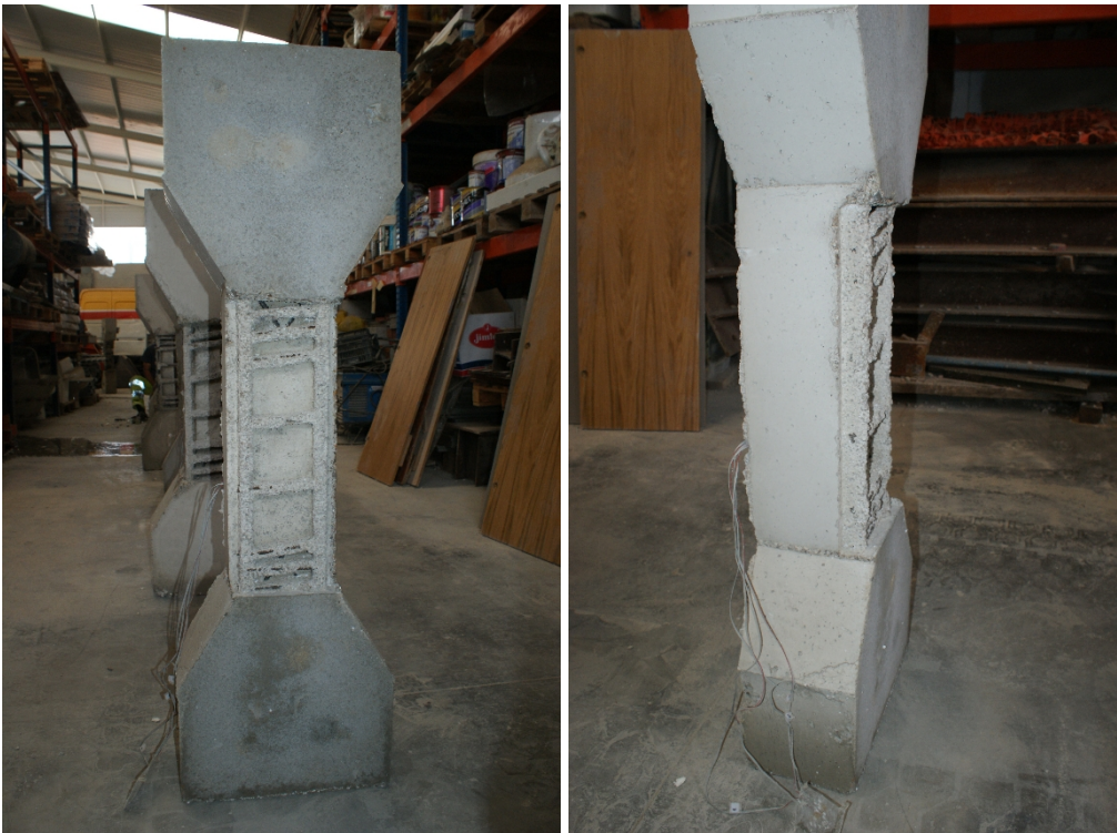
Figura 39 - Detalle del pilar daño 1 cara.
