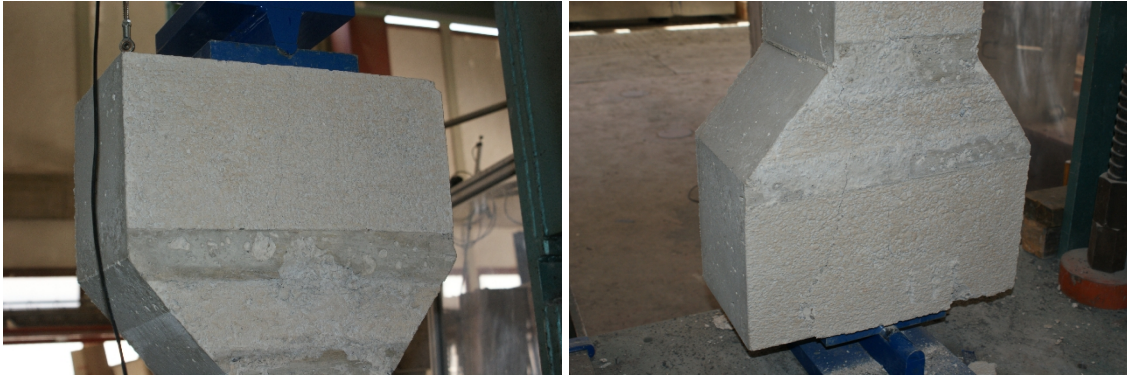
Figura – 18 Fotografías fallo cabezas pilares (cara delantera).
