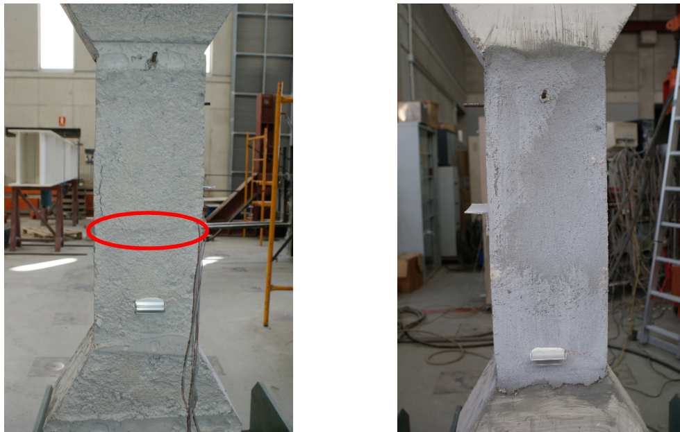
Figura 107 - Pilares PR1C_R3 tras el ensayo a compresión. Fisuración caras C1 y C3 respectivamente.
