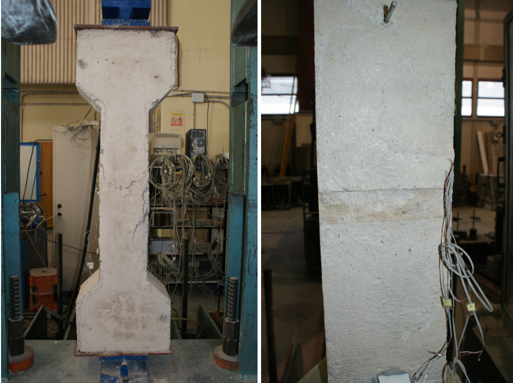
Figura 24 – Detalle rotura pilar hormigonado en una sola vez
