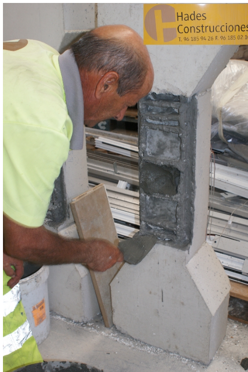
Figuras 47 y 48 - Aplicación del puente de unión y colocación de la primera capa de mortero de reparación.
