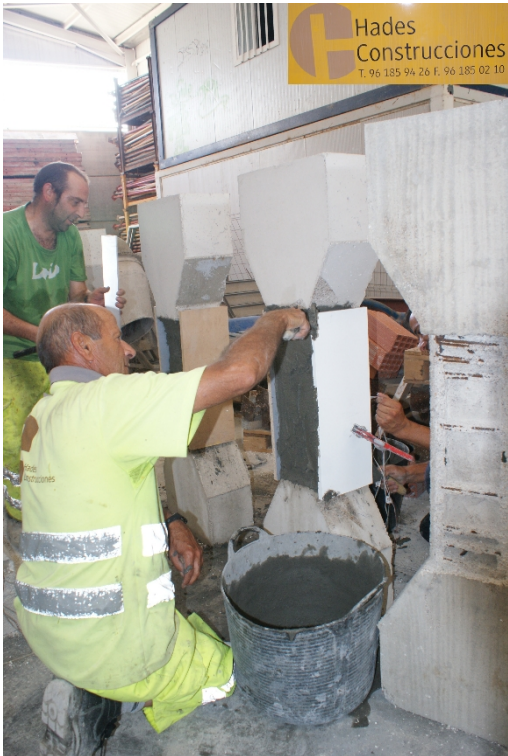
Figuras 45 y 46 - Encofrado a dos caras, relleno del resto del espesor.
