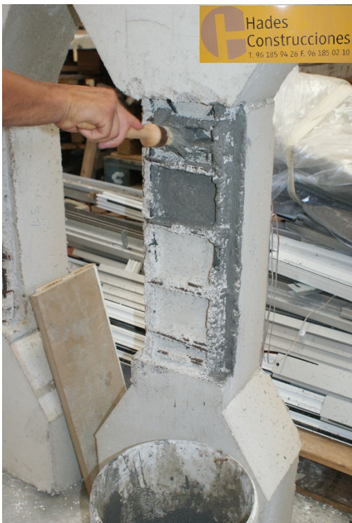
Figuras 47 y 48 - Aplicación del puente de unión y colocación de la primera capa de mortero de reparación.
