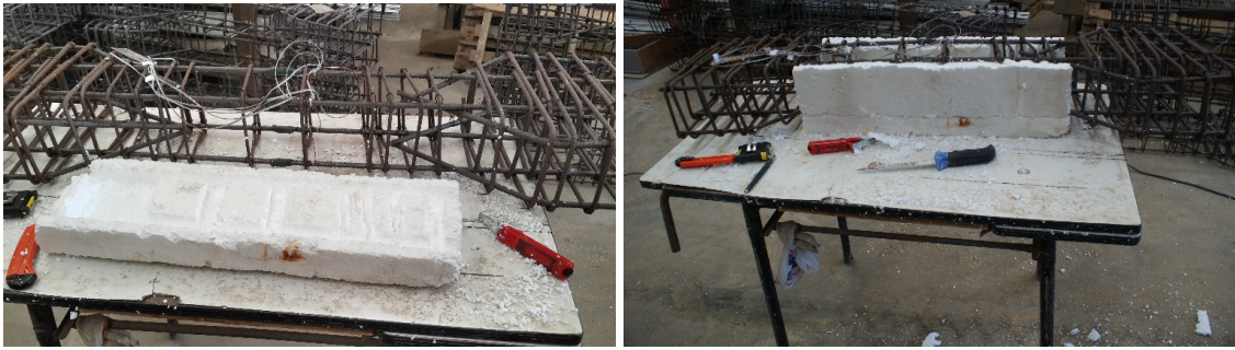
Figura 28 - Detalle elaboración daño pilares daño en las 4 caras.
