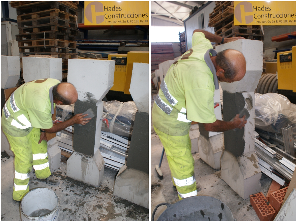
Figuras 49 y 50 - Fratasado de las superficies.
