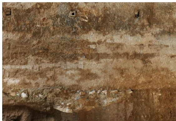
Foto_28 Paño de muralla. Lienzo inferior con su base vista y las primeras agujas del tapial
