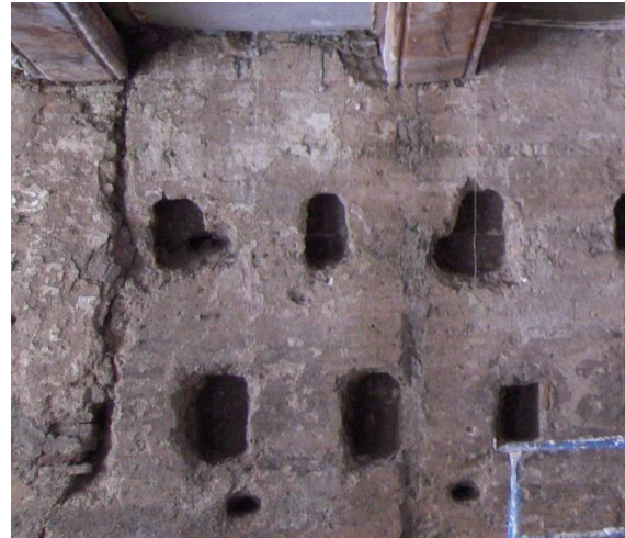
Foto_24 Huellas de los mechinales dejados en la muralla de los diferentes forjados del edificio. De abajo arriba: agujas del tapial, mechinales del siglo XIV, y mechinales del S. XIII., Los correspondientes al siglo XIII, coinciden con la altura del arco de ingreso en el Palacio.
