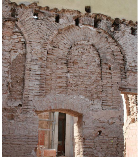
Foto_25 Arco cristiano de medio punto sirviendo de relleno a un arco islámico a la altura del adarve. 2008.
