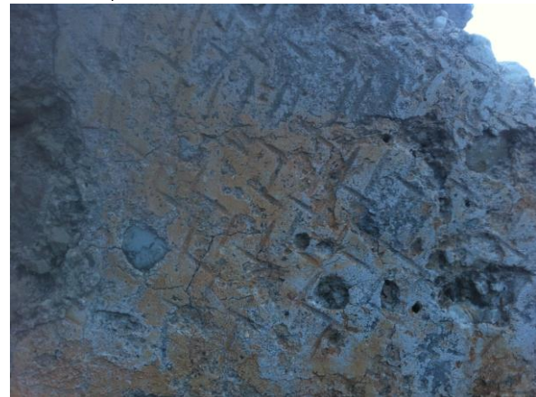
Foto_43 Detalle de la costra con incisiones en la torre albarrana del Castillo de Corbera (s. XII). Año 2014.
