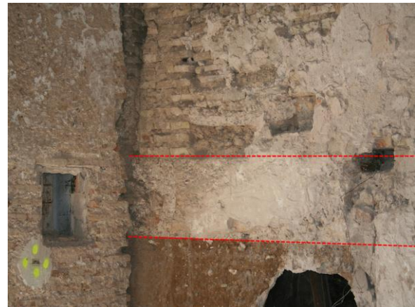
Foto_34 Adarve o paso de ronda sobre la muralla. En la fotografía aparece señalado con líneas color rojo.
