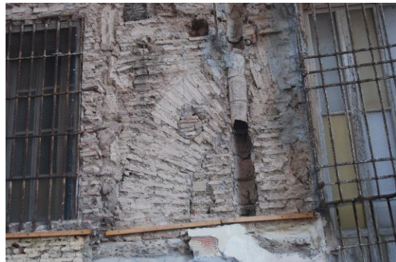
Foto_9 Ladrillos formando un arco. Palacio de los Eixarc. Valencia, 2015
