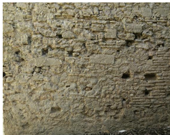
Foto_38 Detalle fachada sur torre. 2015
