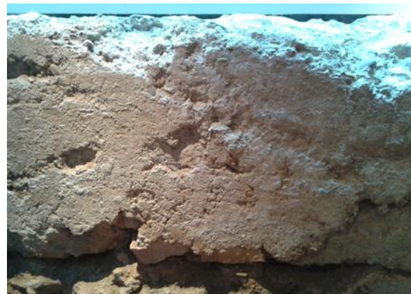
Foto_53 Aspecto muralla taifa en el Palacio del Marqués de Caro. 2015
