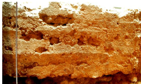
Foto_25 Muralla de tapia con mampuestos vistos parcialmente. Palacio Marques de Caro 2015
