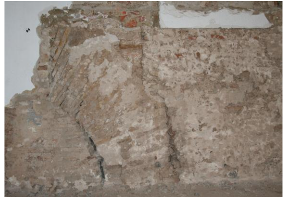
Foto_19 Arco abierto en la fachada sur del primitivo Palacio del Marqués de Caro y que comunicaba el salón principal con el patio. Siglo XIII
