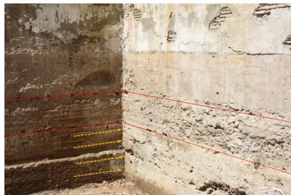
Foto_44 Encuentro muralla con la torre exterior donde se aprecia que la torre se apoya sobre la muralla más antigua, representado esto con las líneas amarillas en la foto. A partir de la segunda caja, representada con una línea en color rojo, la torre y muralla se levantan al mismo tiempo durante el mismo proceso constructivo, compartiendo cajas y tongadas de tierra y cal.
