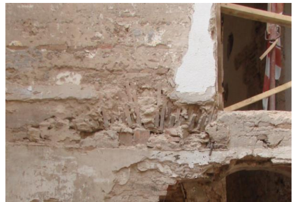
Foto_47 Arco encontrado en la base del muro sur de la torre interior.
