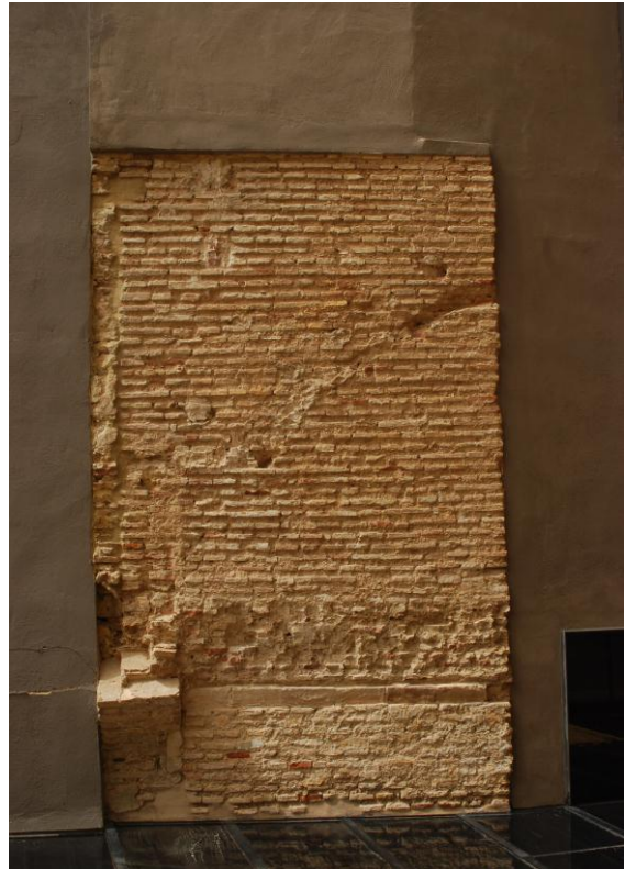
foto_59 Cicatriz marcada en la fachada norte del Palacio al amortizarse la muralla islámica y abrir paso en el antiguo atzucat. Para evitar su desmoronamiento se cerró con un muro de ladrillos. 2015
