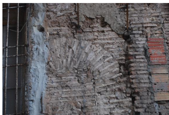
Foto_11. Arco de ingreso de medio punto levantado con fábrica de ladrillo. Fachada posterior del Palacio de los Eixarcs. Valencia. 2015
