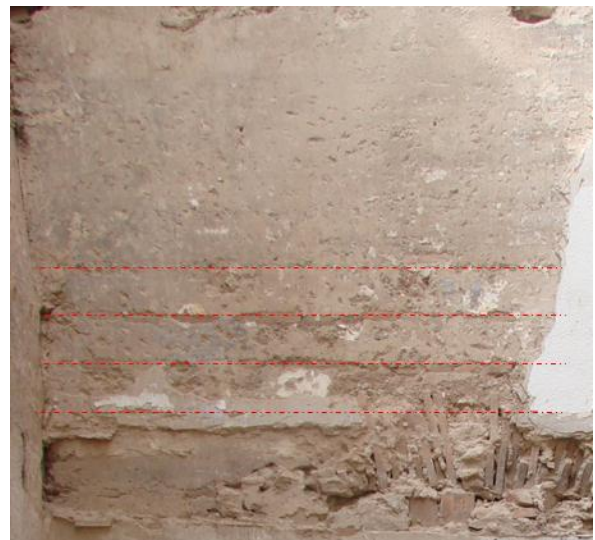
Foto_48 Muro norte de la torre interior con verdugadas de ladrillos sobre el arco encontrado en la base. Referencia (Foto_45)
