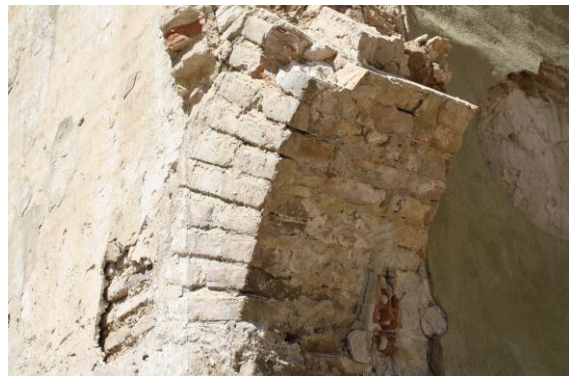
Foto_60 Arquillo de paso levantado al restañar la herida de la muralla. 2015
