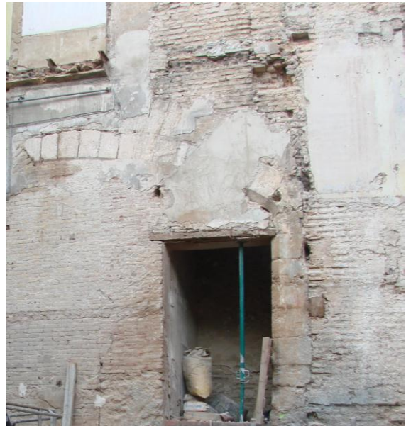
Foto_53 Arco Escarzano abierto en la fachada Sur de la segunda crujía. Siglo XV. 2008
