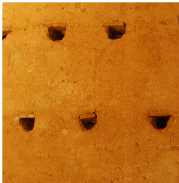
Foto_46 Fachada Sur de la crujía principal del primer palacio. El muro se levantó con la técnica del tapial valenciano, pero hay zonas sin ladrillo, a modo de tapia calicostrada. Los mechinales abiertos cada 1 m. se han dotados de visera.
