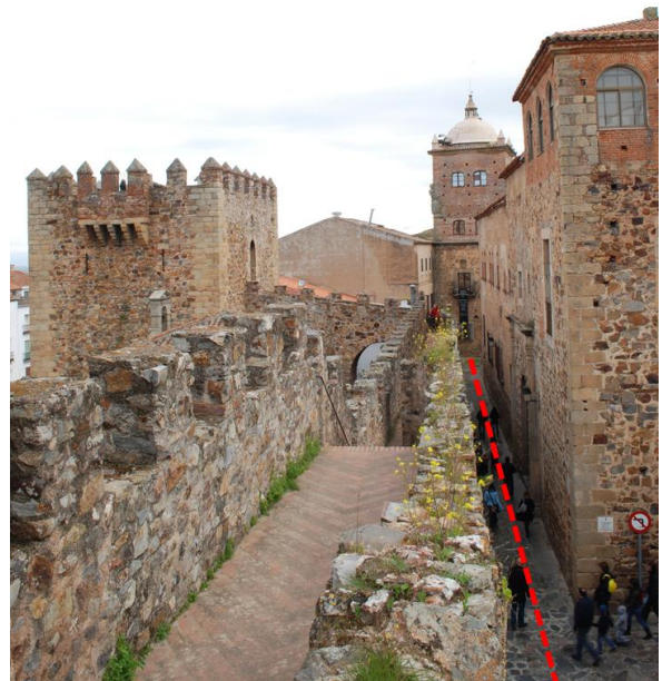
Foto_61 Paseo de ronda junto a la muralla de Cáceres. Se puede observar también el adarve de la muralla con las almenas y el murete que hace de quitamiedos.
