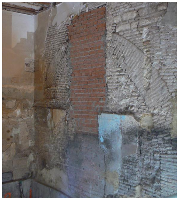
Foto_21. Gran arco ojival de la entrada en el primitivo edificio. Siglo XIII
