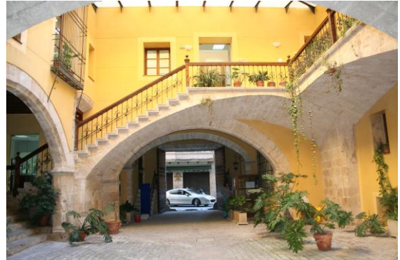
Foto_13. Escalera en patio descubierto sobre bóveda capialzada. Palacio de los Mercader. Valencia 2006.
