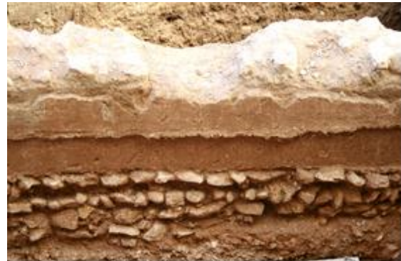
Foto_9 Muro de hormigón sobre mampuestos en hiladas regulares. Fase excavación arqueológica Palacio Marques de Caro. 2007
