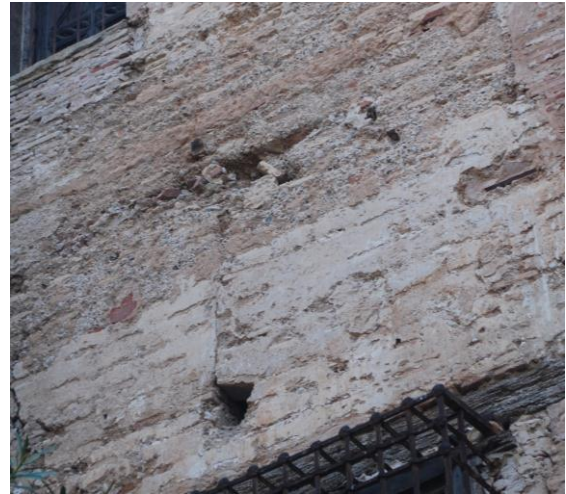
Foto_48 Tapia Valenciana y con aguja vista en la fachada interior de la casona de los Eixarcs en Valencia. 2015
