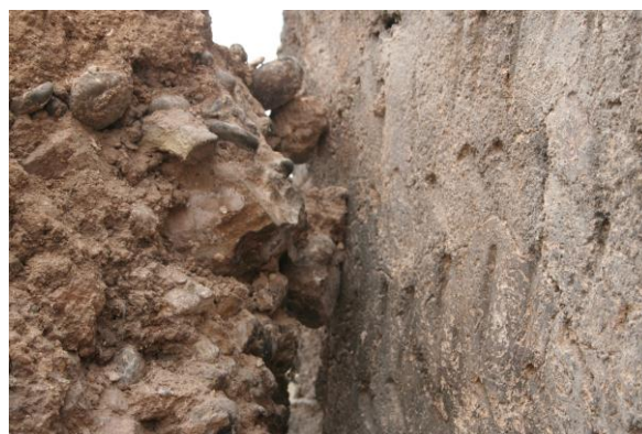
Foto_60 Detalle del apoyo de un muro sobre otro, cubriendo la costra con incisiones del muro oeste de la torre.
