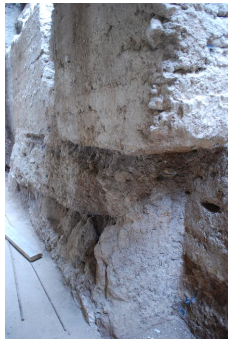
Foto_27 La nueva muralla se levanta sobre la antigua y la amortiza completamente.
