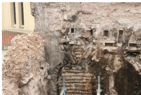
Foto_59 Se aprecia que la fachada norte de la torre interior se apoya sobre el muro oeste de la torre, donde se abren los arcos de ingreso a la habitación interior de la misma durante la intervención del Palacio del Marqués de Caro. 2008
