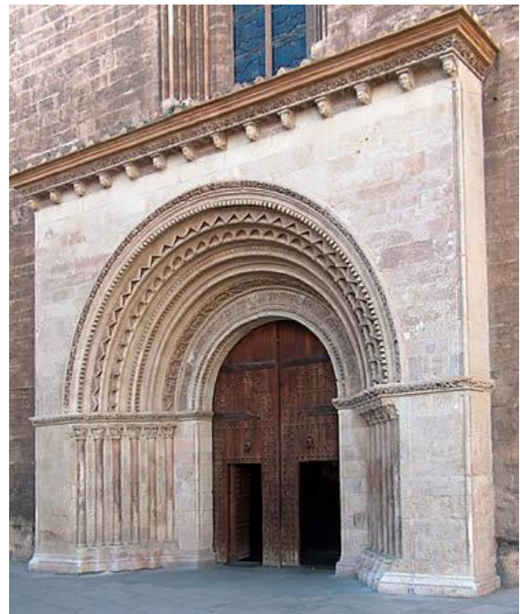
Foto_5. Portada Románica de la catedral de Valencia levantada en sillería. Siglo XIII. Foto Arteguias.com
