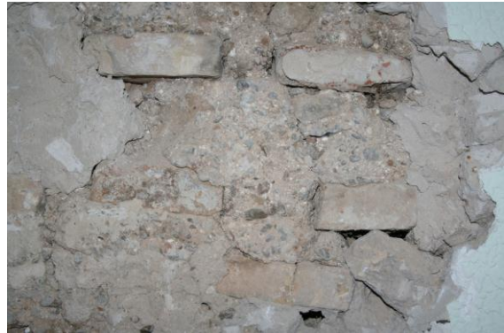
Foto_8 Ladrillos encastrados en tapia valenciana Palacio del Marqués de Caro. 2007
