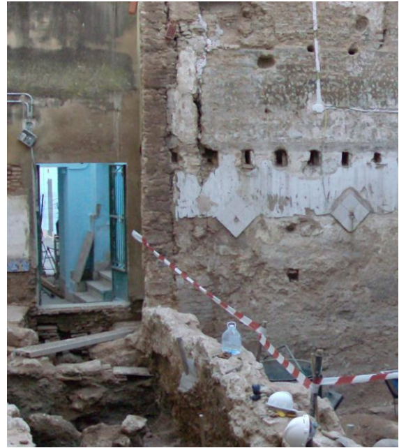
Foto_29 Amortización de la muralla en el atzucat. En la fotografía puede observarse el final de la muralla y el muro levantado en su sección para protegerla. 2008.
