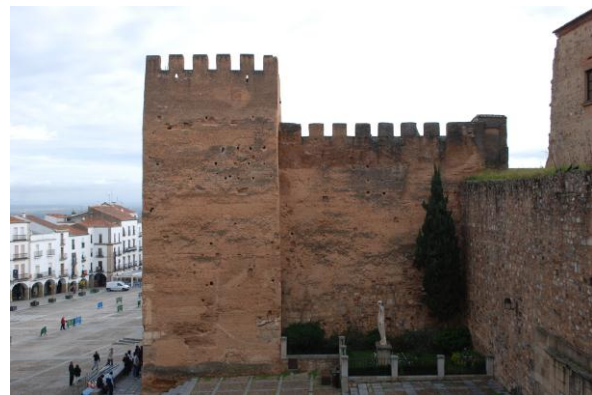
Foto_57 Torre de la Yerba | Muralla almohade de Cáceres. 2010
