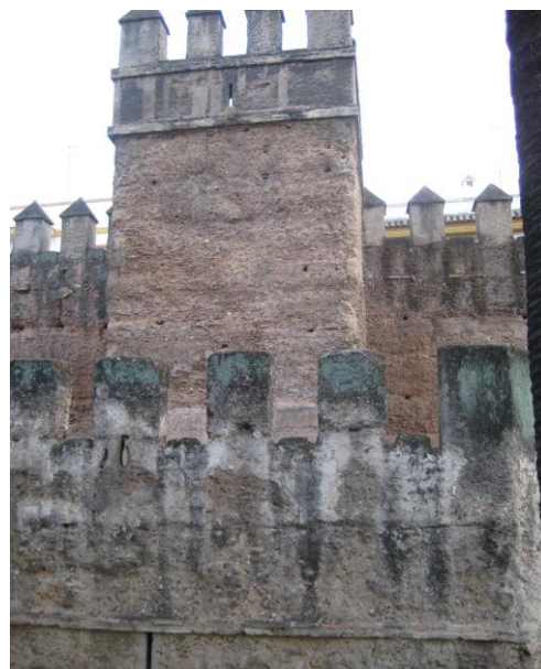
Foto_52 Relación antemuro y muralla principal donde puede observarse la diferencia de altura entre ambos muros, lo que provoca que tengan anchos diferentes Muralla almohade de Sevilla. 2010
