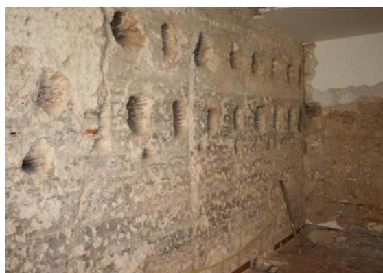
Foto_32 Tapia de tierra calicostrada. Lienzo interior de la muralla. En la foto destacan mechinales en desuso.
