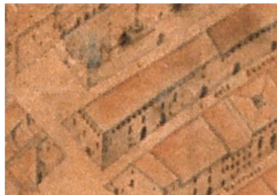
Imagen_26 Edificio de los Eixarc, de doble crujía. Tosca 1704
