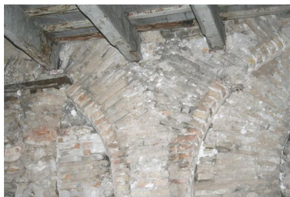
Foto_41 Fábrica que comparten los arcos gemelos de la torre. Foto tomada durante la intervención de rehabilitación del Palacio Marques de Caro. 2007.
