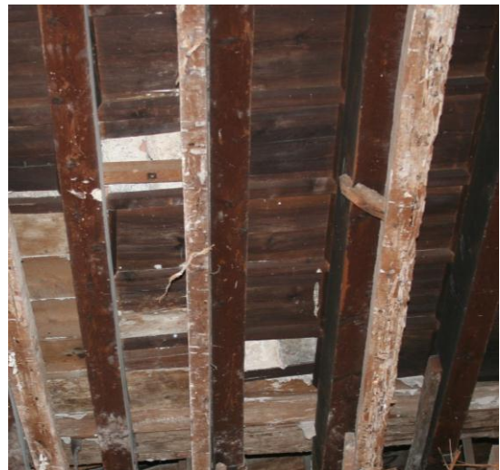
Foto_63 Restos del Alfarje sobre techo del siglo XIX hallados durante la restauración del Palacio. 2007
