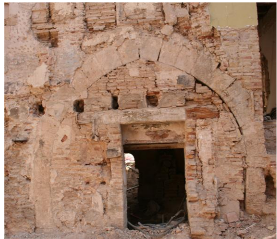
Foto_30 Arco ojival levantado en la fachada sur de la crujía transversal, y cegado posteriormente. 2007
