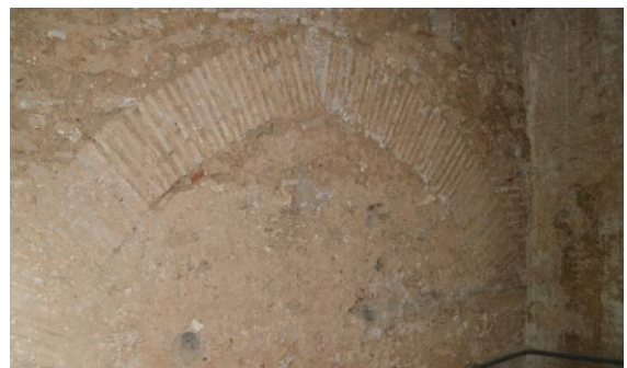
Foto_28. Arco de descarga en la fachada norte de la torre islámica. 2011
