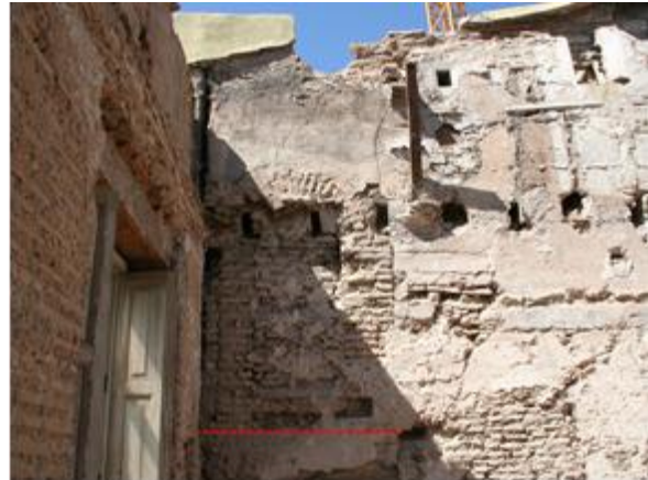
Foto_49 Arco sobre el adarve cuya cara superficial está señalada con una línea punteada de color rojo, abierto en el muro de la torre interior que permite el paso de la tropa. Foto tomada durante la intervención de rehabilitación del Palacio Marques de Caro. 2007.
