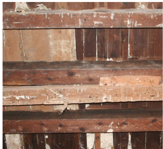
Foto_55 Alfarje sobre una de las estancias de la nueva planta primera. Marqués de Caro, 2007.
