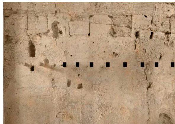
Foto_35 Almenas amortizadas de la muralla taifa de Valencia. C/Blanquerías, 2_C/Rocas, 8. Archivo Universidad de la Florida.
