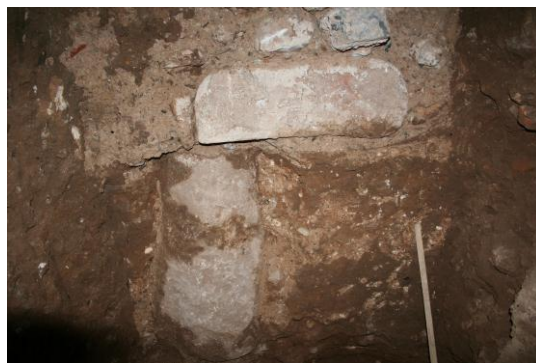
Foto_16 Meta reutilizada como soporte en el muro de fachada.
