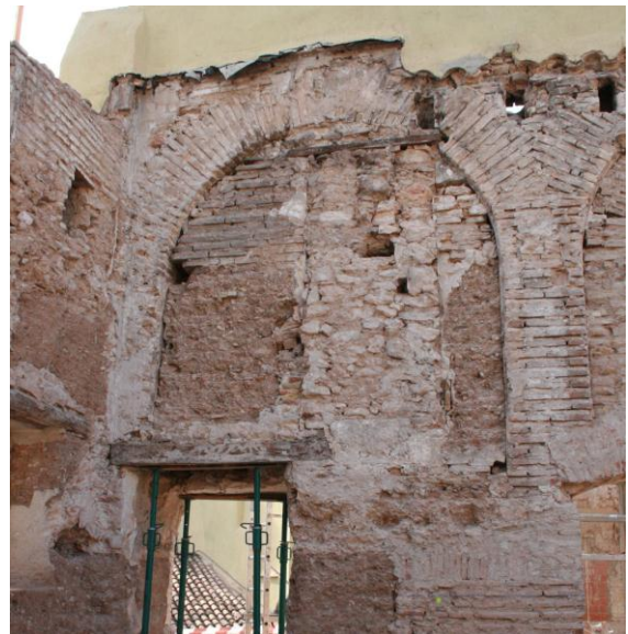
Foto_26 Relleno de distintos materiales del arco gemelo del adarve. 2008
