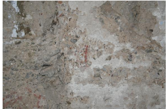
Foto_22_Tapia Valenciana del muro de separación entre el salón principal y la estancia trasera, con restos policromos. Siglo XII
