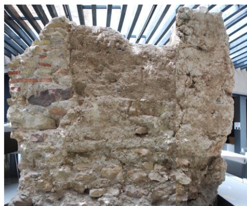
Foto_31 Sección de la muralla más moderna donde quedan vistos los dos paramentos exteriores y el relleno de tierra. 2015
