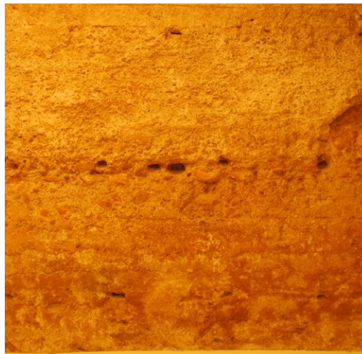
Foto_37 Detalle fachada norte torre. 2015
