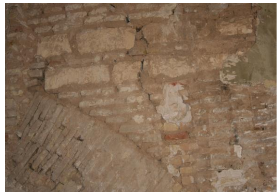
Foto_20 Sillarejos en la fachada principal del primitivo Palacio. Siglo XIII.
