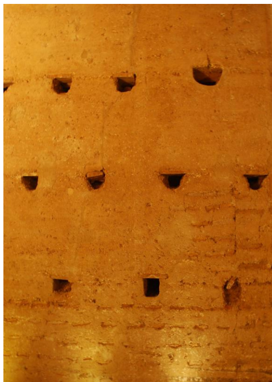
Foto_18 Fachada sur del primitivo Palacio del Marqués de Caro. Siglo XIII. El tapial valenciano se entremezcla con tapial calicostrado. Las agujas son de gran tamaño y están dotadas de visera. 2015
