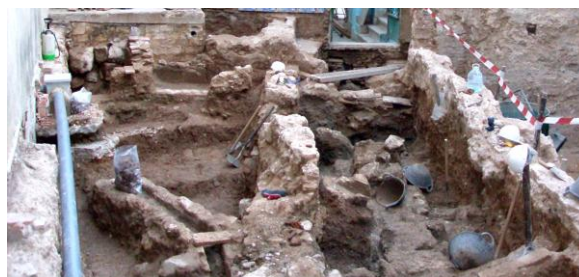
Foto_24 Adarve o antiguo Atzucat islámico bajo el actual. Foto 3ª Fase excavación arqueológica Palacio Marques de Caro. 2008.
