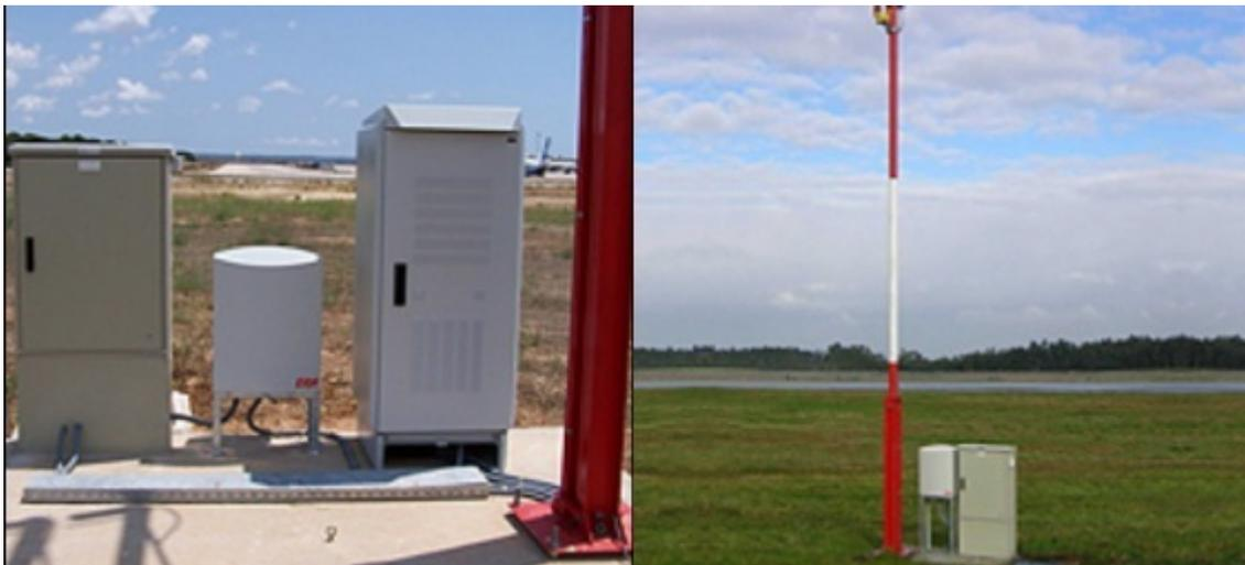
Figura 5.1. Equipo de tierra para sistema multilateración.
